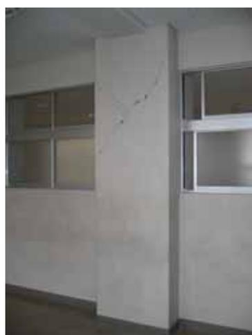
写真 6.22 教室の短柱のせん断破壊
