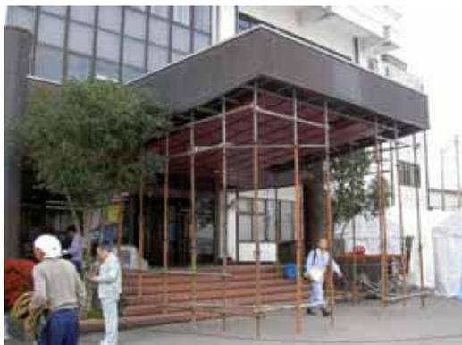
写真 6.39 庇の損傷
