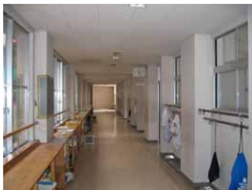
写真 6.20 腰壁による柱の短柱化
