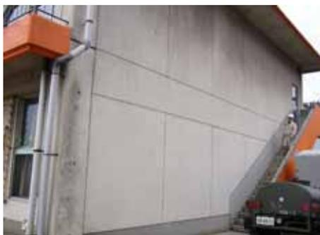
写真 6.44 外壁亀裂状況(妻壁)
