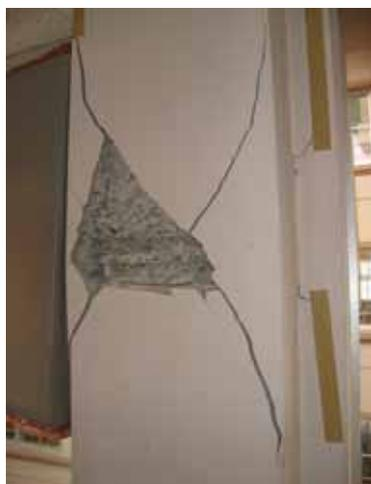
写真 6.21 中庭側の短柱のせん断破壊
