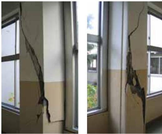
写真 6.1 特別教室棟の 1 階廊下側短柱のせん断破壊
