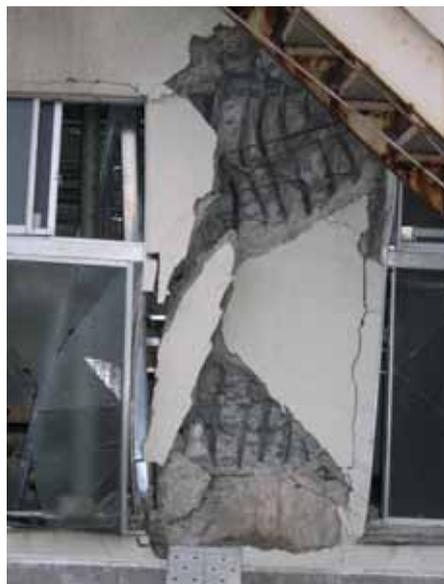
写真 6.8 昭和 43 年竣工棟の短柱のせん断破壊
