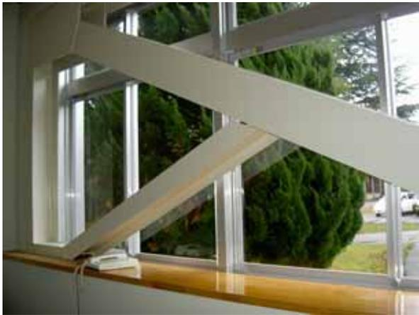
写真 6.13 耐震補強(鉄骨ブレース補強)
