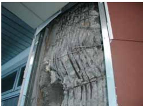
写真 6.33 建築物 J の柱のせん断破壊
