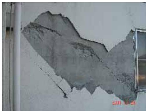
写真 6.12 昭和 55 年竣工棟の非構造壁部材の損傷
