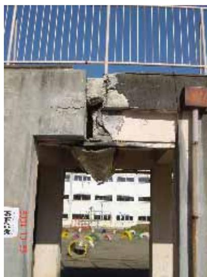
写真 6.37 渡り廊下接続部の衝突
