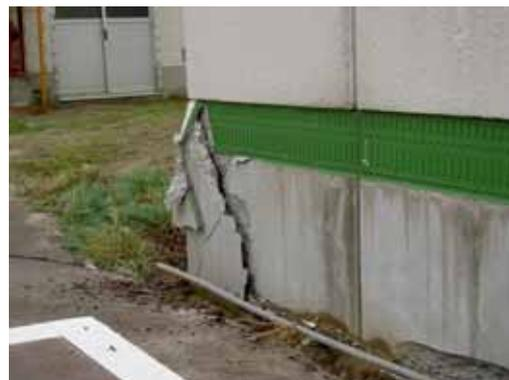
写真 6.34 基礎の破壊状況
