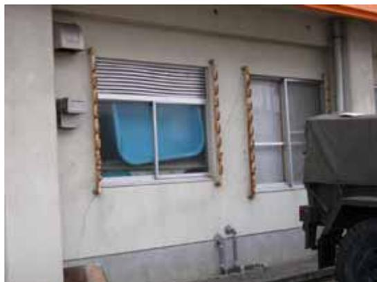
写真 6.42 外壁亀裂状況(雑壁)
