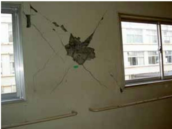
写真 6.15 壁柱のせん断破壊
