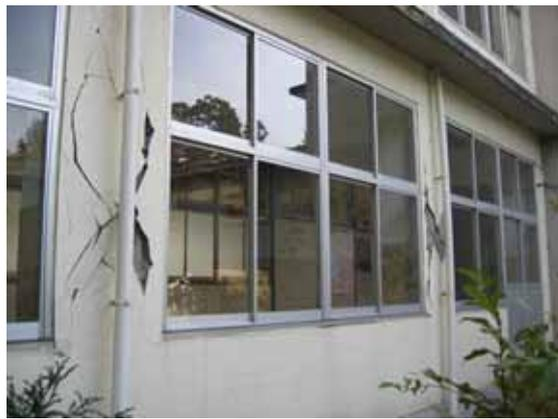
写真 6.2 特別教室棟の 1 階廊下側の被害
