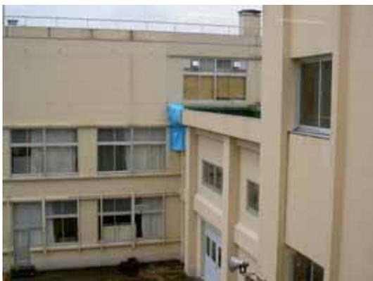
写真 6.17 EXP.J部の被害
