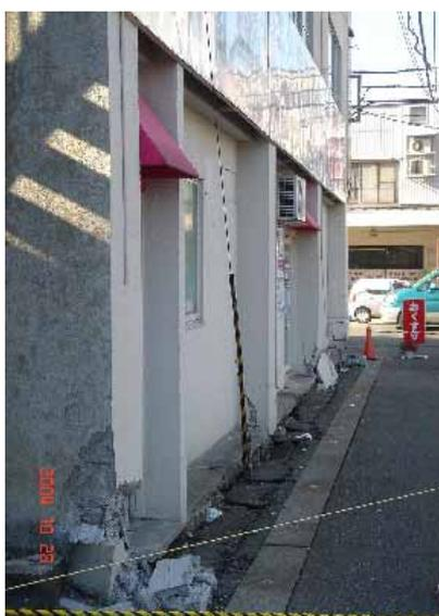
写真 6.25 長手方向の柱
