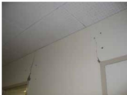
写真 6.10 昭和 44 年竣工棟の梁端の曲げひび割れ
