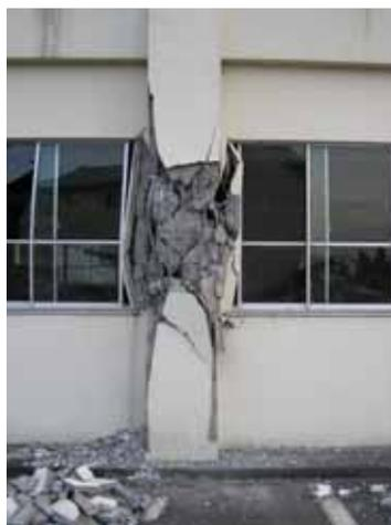
写真 6.5 短柱のせん断破壊
