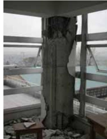
写真 6.29 柱のせん断破壊 (ペントハウス)
