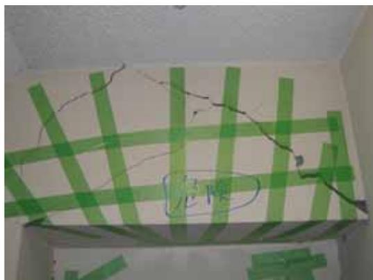
写真 6.9 昭和 44 年竣工棟の短スパン梁のせん断破壊
