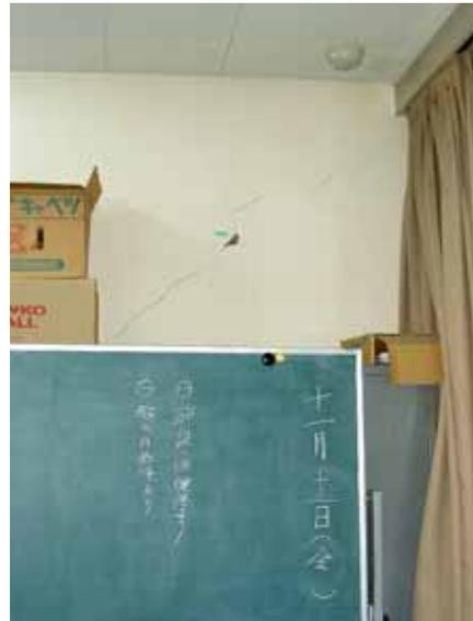
写真 6.16 耐力壁のせん断ひびわれ
