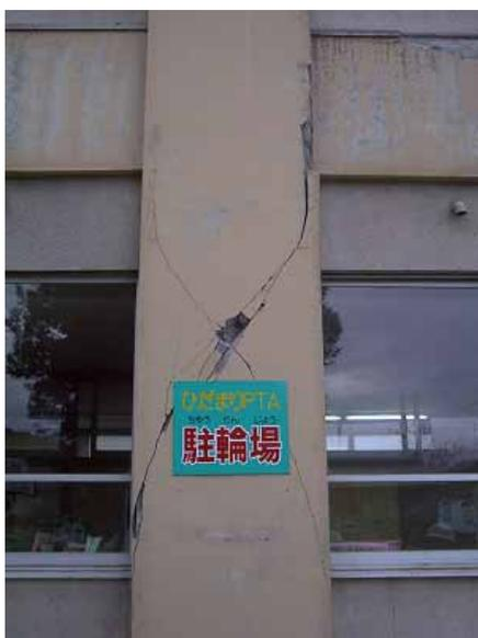
写真 6.38 1 階柱のせん断ひび割れ
