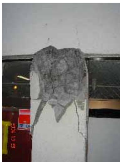
写真 6.24 柱頭部の損傷
