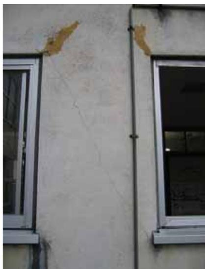
写真 6.36 柱のせん断ひび割れ
