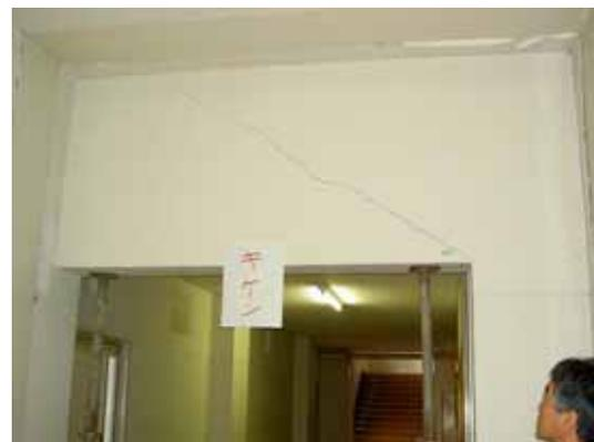
写真 6.18 短スパン梁のせん断ひびわれ
