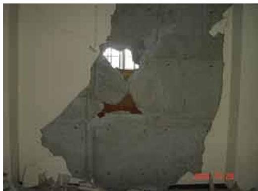
写真 6.11 昭和 44 年竣工棟の壁部材のせん断破壊
