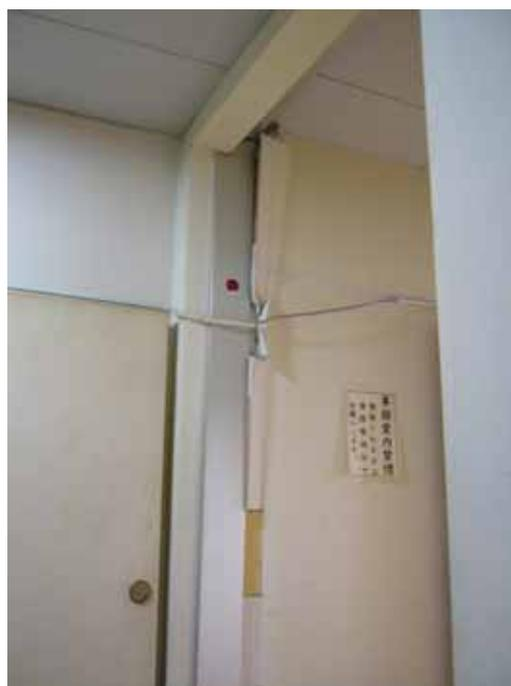
写真 6.41 エキスパンション損傷状況
