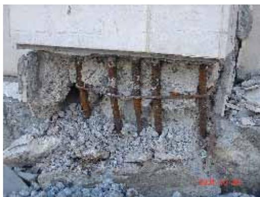
写真 6.26 柱脚ヒンジゾーンの主筋座屈
