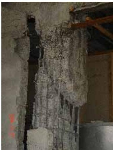
写真 6.23 柱のせん断破壊
