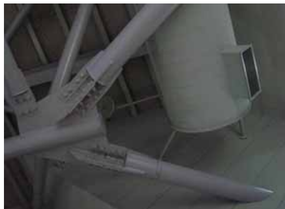
写真 11.8 屋根 壁の取合部分、吹出口
