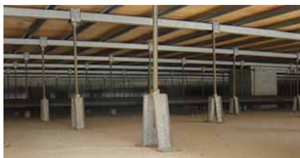
写真 11.4 A 高校小体育館床下
