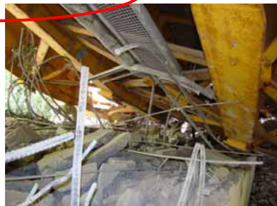
主げたの中間支点(P2)はP1～P2間で着地している状況
