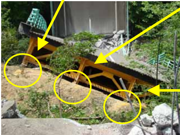
コンクリートとの衝突痕や著しい変形がみられるA2側主桁端部
