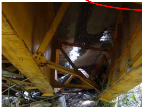
主げたの中間支点(P2)はP1～P2間で着地している状況
