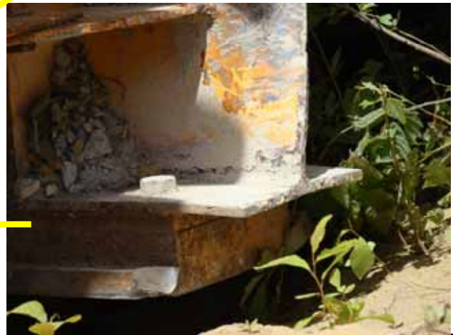
コンクリートとの衝突痕や著しい変形がみられるA2側主桁端部
