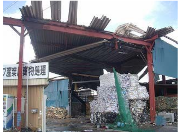
写真 22 折板の損傷
