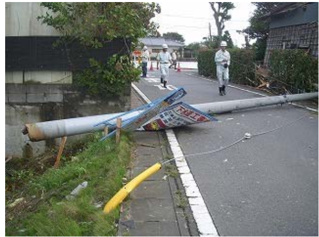
写真 42 電柱の折損
