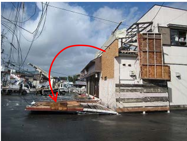
写真 19 外壁の脱落
