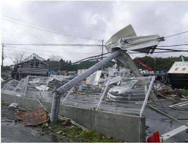
写真5 駐車場の被害状況
