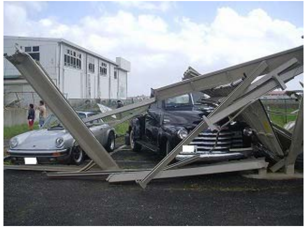
写真 40 ユニット型車庫の倒壊
