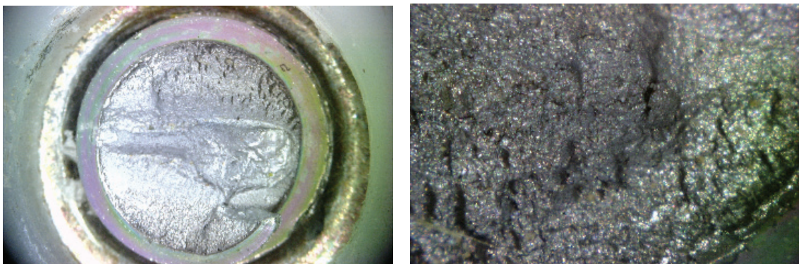
写真 2 ボルトの破断面（正常と考えられるボルト）
