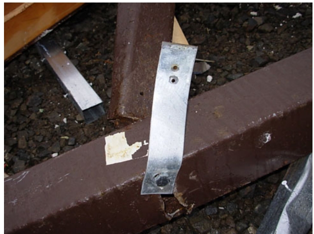
写真11 角型鋼管の土台と木ぐいとを固定した接合金物 (C棟)
