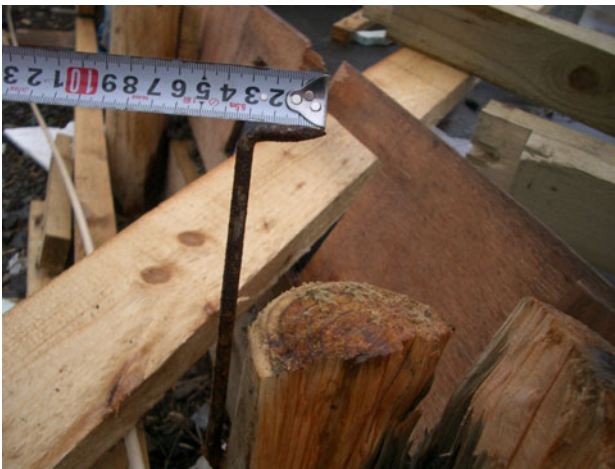
写真8 木ぐい側に残ったかすがい (A棟)
