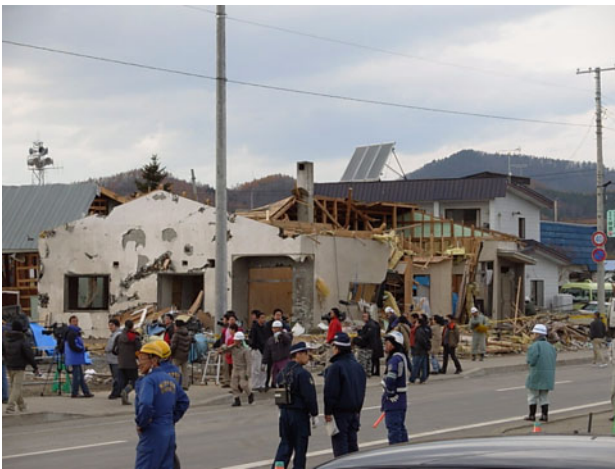
写真 14 事務所併用住宅の被害
