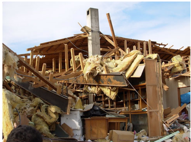
写真 15 事務所併用住宅の被害
