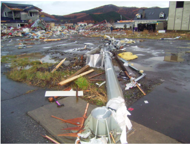
写真 30 道路標識の折損 (国土交通省北海道開発局提供)
