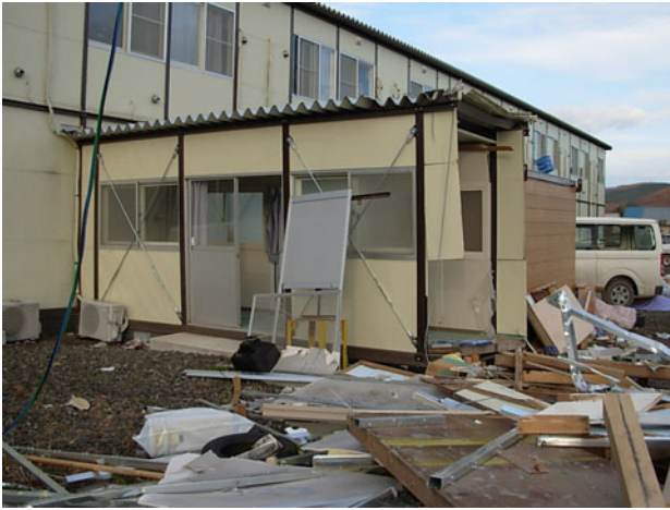
写真 12 B 棟と C 棟をつなぐ渡り廊下
