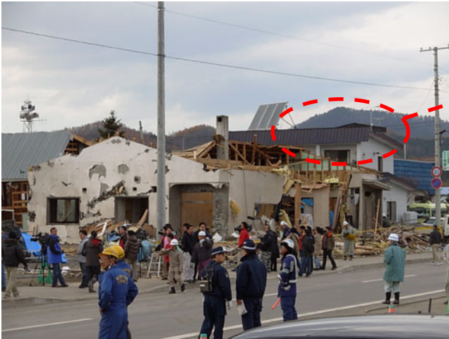
写真 32 全壊した事務所併用住宅
