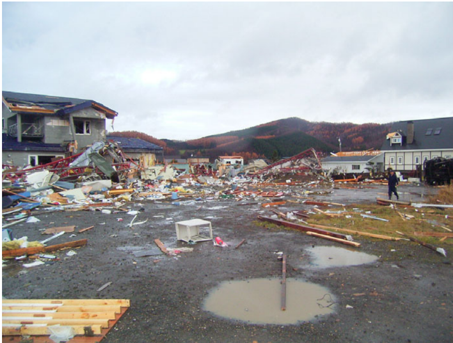
写真4 被災直後の新佐呂間トンネル作業事務所向いの状況（国土交通省北海道開発局提供）
