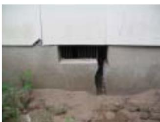
写真-3 基礎の破壊状況
