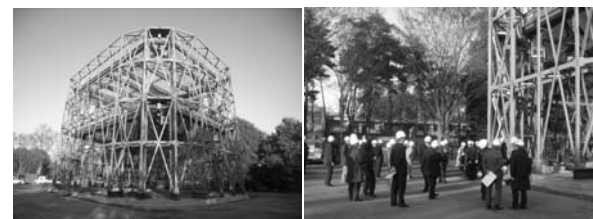
図 4 鉄骨造の実大建物を用いた検証実験
