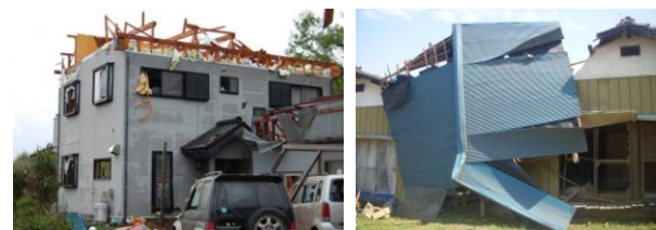
(a) 木造小屋組の倒壊 (b) 飛来物(屋根)の衝突 図 3 つくば竜巻の被害事例
