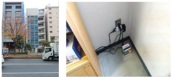
写真2 地震計設置建築物と各階の無線式地震計
