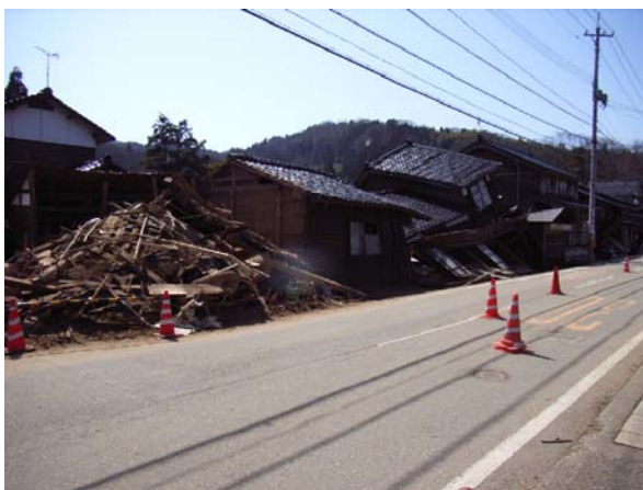
写真-4.13 倒壊家屋が建ち並ぶ門前地区
