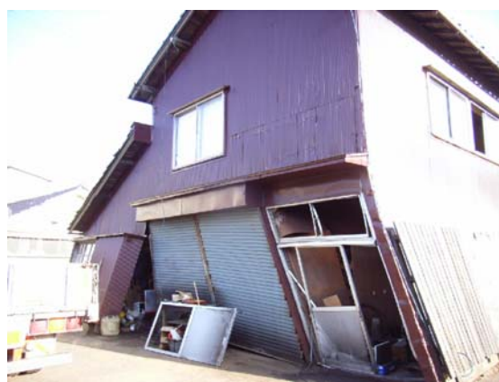
写真-4.2 倒壊寸前のチップ工場の倉庫
