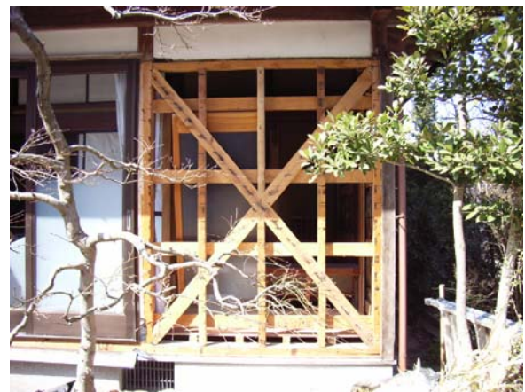
写真-4.24 左の民家の筋かい
