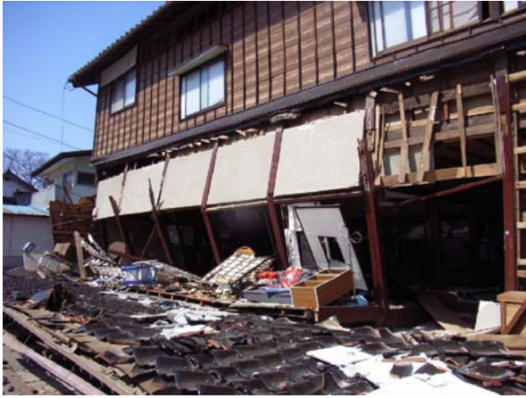
写真-4.15 倒壊は免れたが柱が折損した住宅
