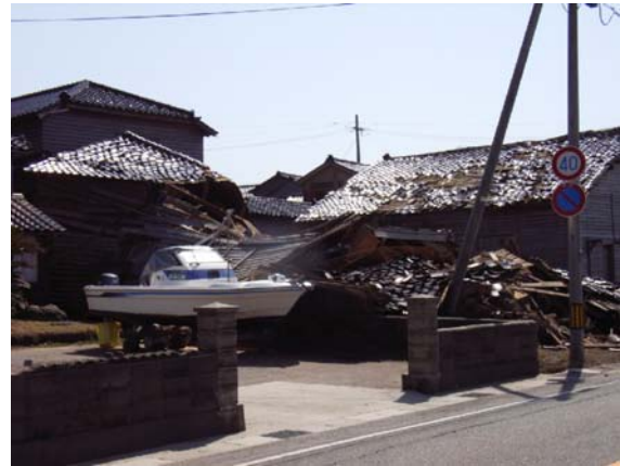
写真-4.34 倒壊した納屋又は倉庫
