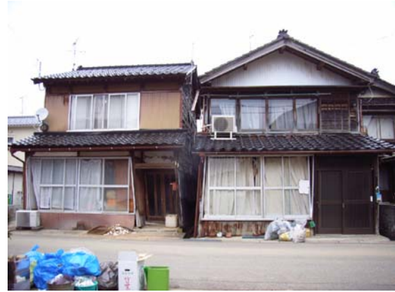
写真-4.46 衝突して外側へ傾いた建物
