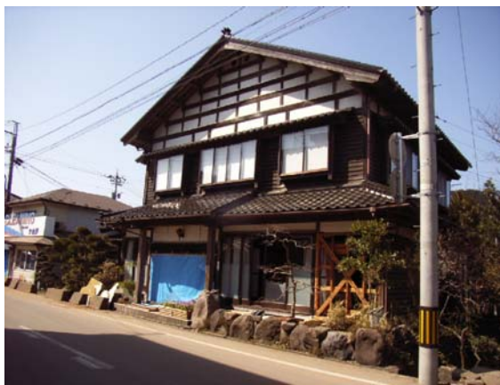
写真-4.23 被害は受けたが残留変形小の民家
