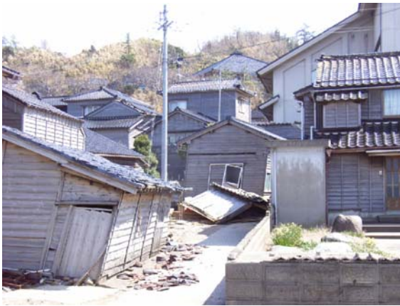
写真-4.33 黒島地区の海岸付近の町並みと倒壊建物
