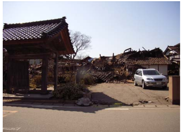
写真-4.20 倒壊して壊滅的な被害を受けた興禅寺
