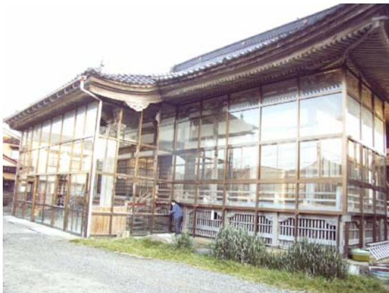
写真-4.9 カーテンウォールの被害
