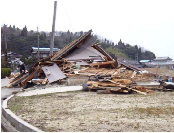
写真-4.53 倒壊した作業所または倉庫
