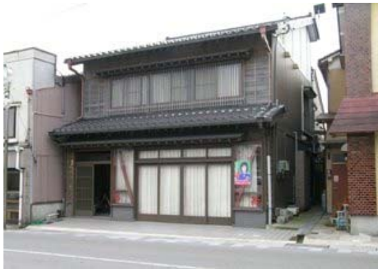
写真-4.62 外観、1階に筋かいが見える
