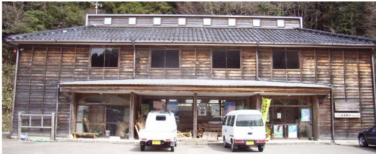
写真-4.165 輪島市門前林業センター外観
