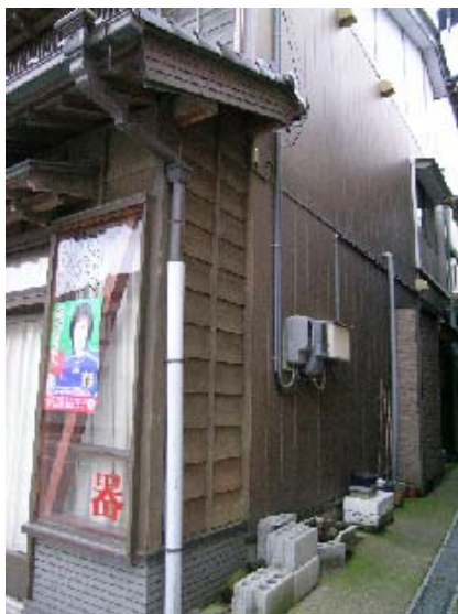
写真-4.64 筋かい部分詳細
