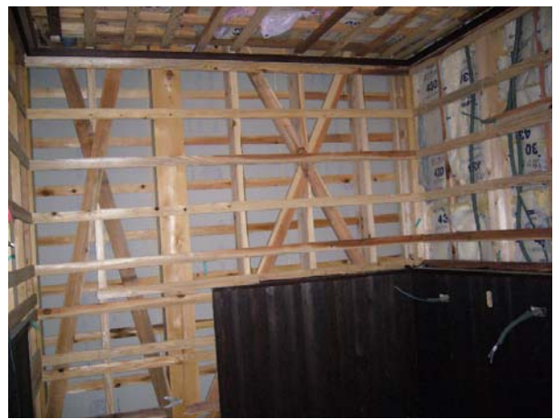
写真-4.113 通常と強弱軸の向きが異なる筋かい
