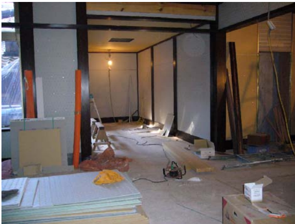
写真-4.112 施工中の内装
