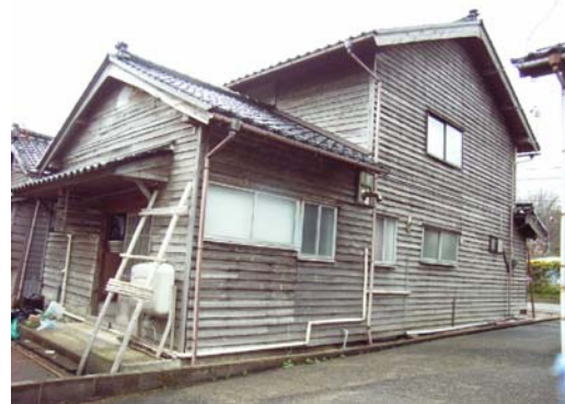
写真-4.132 北側外観
