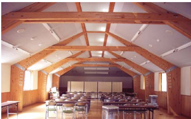
写真-4.167 2階の集成材アーチ
