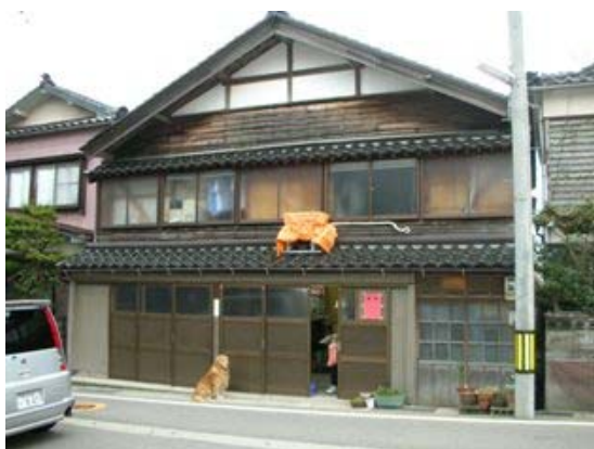
写真-4.66 全景 (2 階に筋かいが見える)
