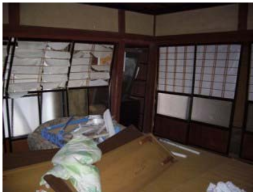
写真-4.133 筋かいが多数施工されている
