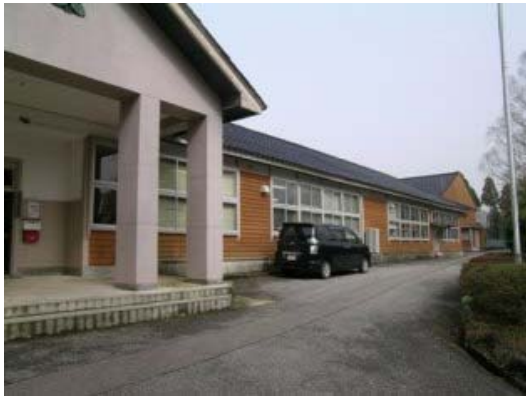
写真-4.153 教室棟の外観
