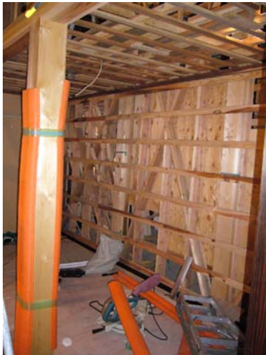
写真-4.110 筋かいが多数施工されている
