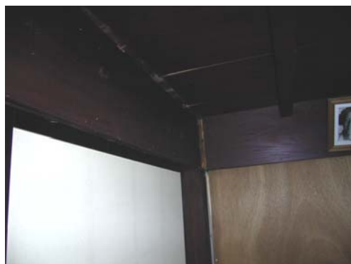
写真-4.68 改装時に設置された合板壁
