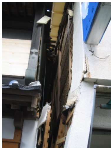
写真-4.100 北側壁面
