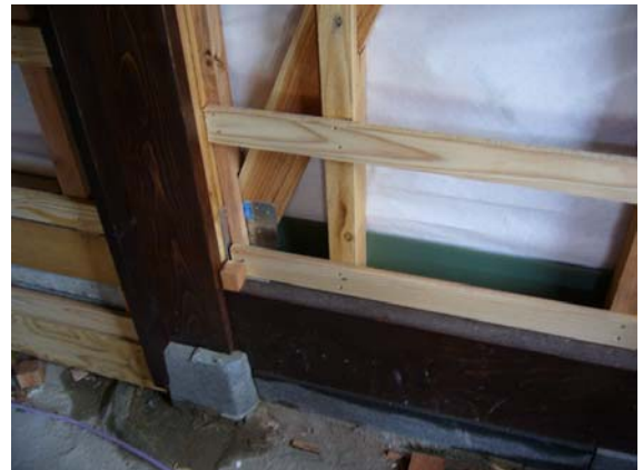
写真-4.111 筋かい端部には所定の金物
