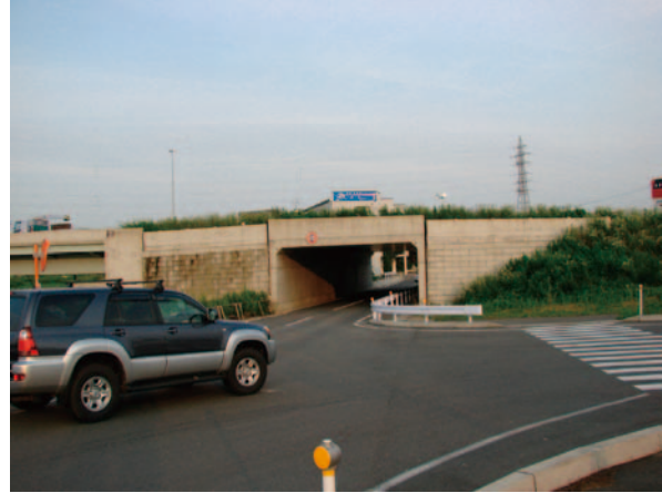
写真-7.17 隣接するボックスカルバート
