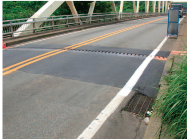
写真-7.7 橋台背面土の沈下による段差補修
