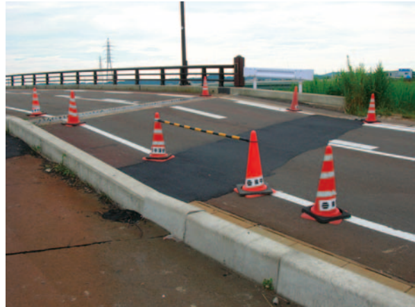
写真-7.26 背面土沈下による段差の補修
