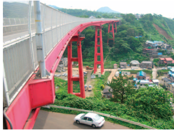
写真-7.9 米山大橋
