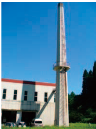
写真-9.5.4 長岡市小国町武石にある塔状工作物
