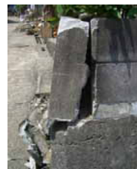
写真-9.7.6 間知ブロック擁壁の前面側への滑り出し
