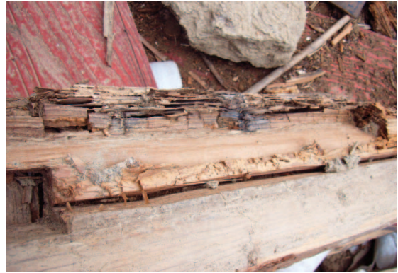
写真-9.4.5 土壁を有する古い構法の倒壊 写真-9.4.6 写真-9.4.5の部材の腐朽・蟻害
