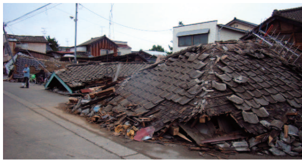
写真-9.4.2 軒並み倒壊した古い構法による家屋
