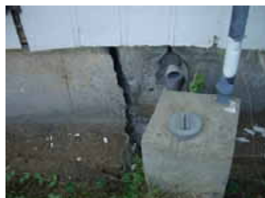
写真-9.7.8 住宅基礎の被害例
