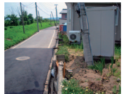
左：地盤変動による被害が甚大であった地点の状況 中：上記地点において建物の不同沈下を増大させたと考えられる擁壁の変形 右：川に沿った道路の変形に伴う電信柱の傾斜
