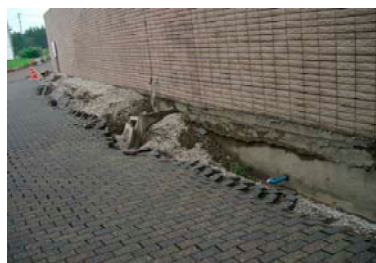
写真-9.7.9 建物周辺地盤の陥没
