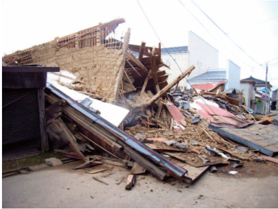
写真-9.4.5 土壁を有する古い構法の倒壊 写真-9.4.6 写真-9.4.5の部材の腐朽・蟻害
