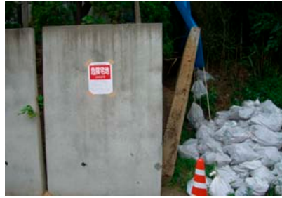
壁高 2m 程度の L 型擁壁
