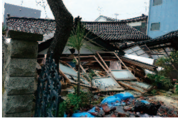
写真-9.4.11 写真-9.4.12 の近景（土壁の残骸が確認された）
