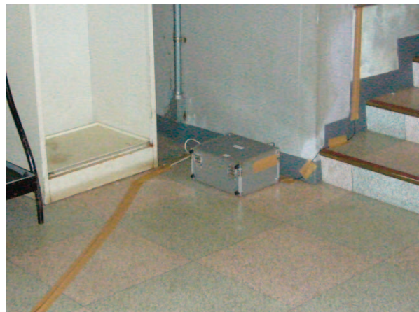
写真-9.3.6 柏崎市民会館大ホール 1FS 設置状況
