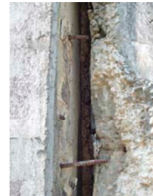
擁壁接合部の状況
