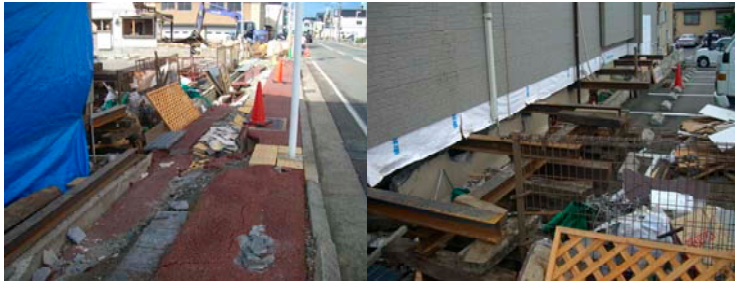
写真-9.7.20 西本町での地盤変動による被害
