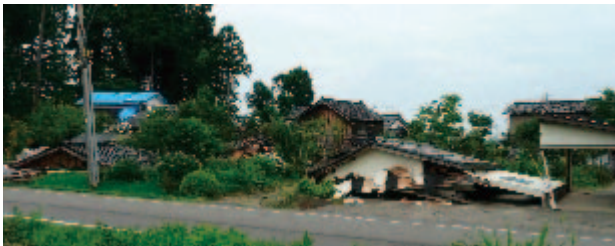
写真-9.4.12 多くの車庫、倉庫が倒壊
