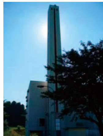
写真-9.5.5 小千谷市時水にある塔状工作物
