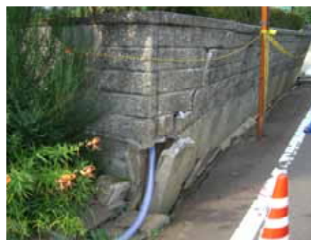
写真-9.7.7 擁壁の被害例
