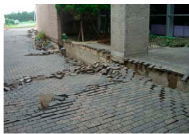
写真-9.7.9 建物周辺地盤の陥没
