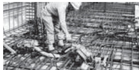
図5 鉄筋接合への適用事例
