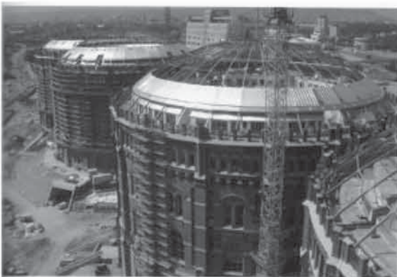
Fig. C 再利用 (屋根架構の施工例)
