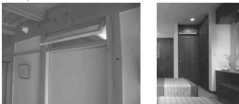
図4 欄間の例(有効開口面積約 0.1 m 2 )
