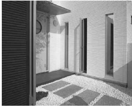
図 f 細幅縦すべり出し窓の例
