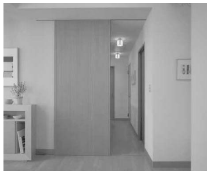
図3 引戸の例(有効開口面積約 1.3 m 2 )
