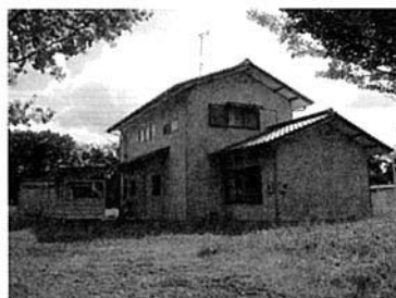
戸建て住宅外観
