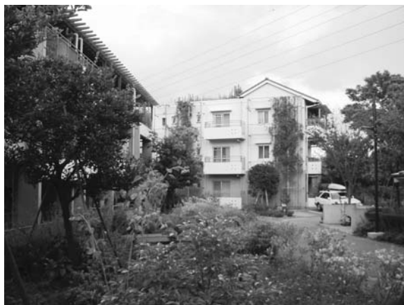
図25 庭木、壁面緑化を日射遮蔽に生かした住宅地の例
