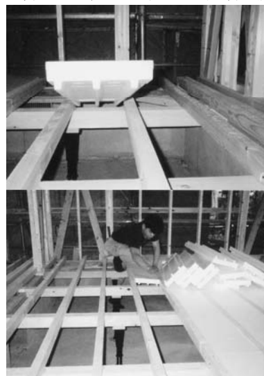
図 34 ボード状断熱材の施工状況
