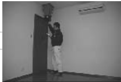
図10 風量測定器を用いた測定状況
