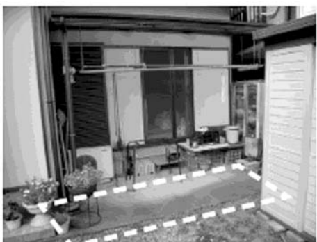
図8 夏期に蓄熱体となる窓先のコンクリートテラス
