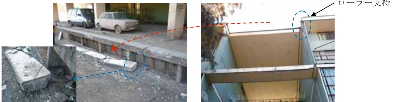
接続部の配筋状況
