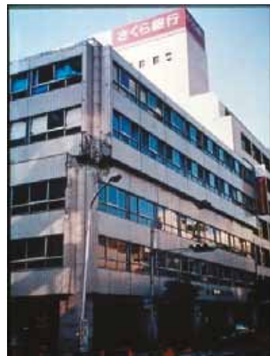
写真 5.5 中間層で崩壊した建築物（阪神・淡路大震災） 5-2)
