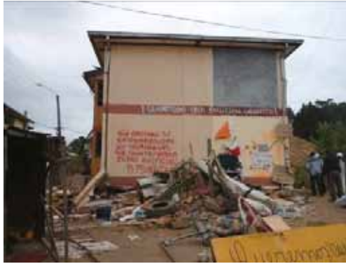
写真 5.10 1層部分で層崩壊したCM造（写真 4.14.3 を再掲）
