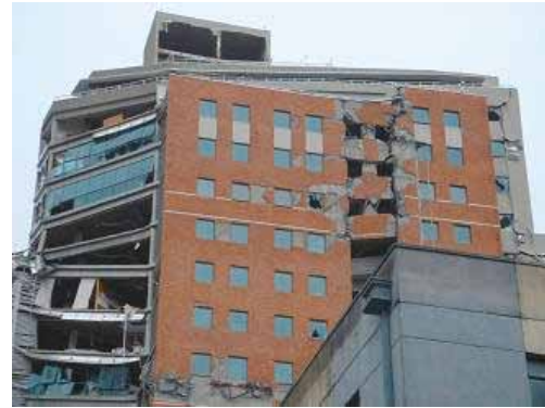
写真 5.4 層崩壊した 12 階付近（左は写真 4.23.3 を再掲）
