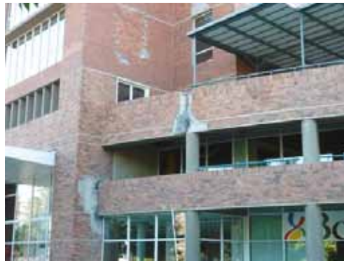
写真 5.28 2 棟の建築物の接続部分（写真 4.6.2 を再掲）
