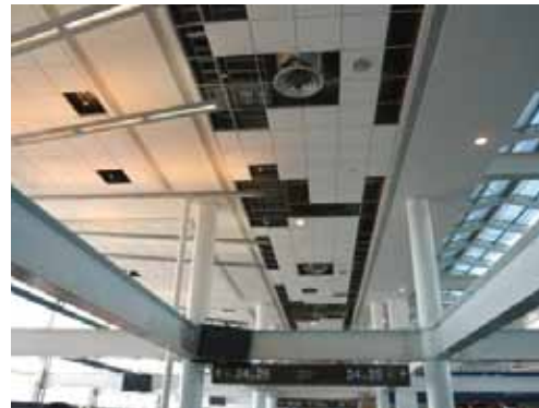
写真 5.38 サンティアゴ国際空港天井パネルの脱落
