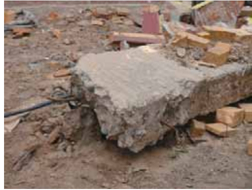
写真 5.23 継ぎ手位置が揃った梁主筋 (写真 4.15.4 を再掲)
