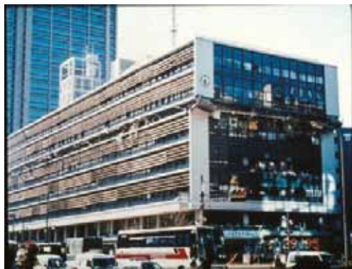
写真 5.5 中間層で崩壊した建築物（阪神・淡路大震災） 5-2)
