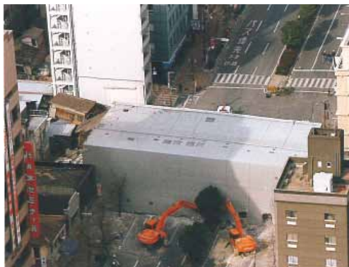
写真 5.2 転倒崩壊した建築物 (阪神・淡路大震災) 5-1)
