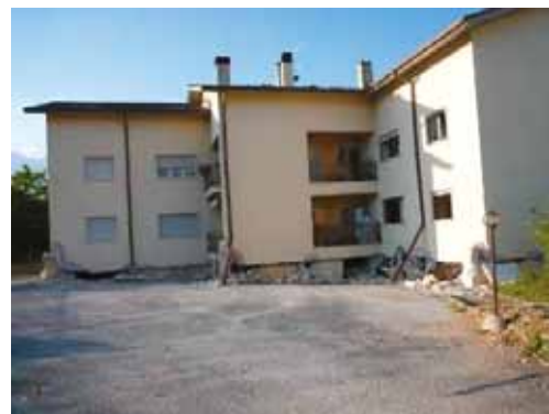
写真 5.9 ピロティ建築物の崩壊 (ラクイラ地震)
