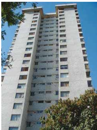
写真 5.29 れんが壁が破壊した高層 RC 建築物（写真 4.5.1 を再掲）
