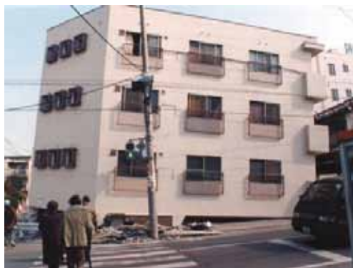
写真 5.8 ピロティ建築物の崩壊 (阪神・淡路大震災)
