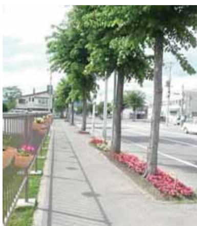
完成した街路樹下の植栽帯
