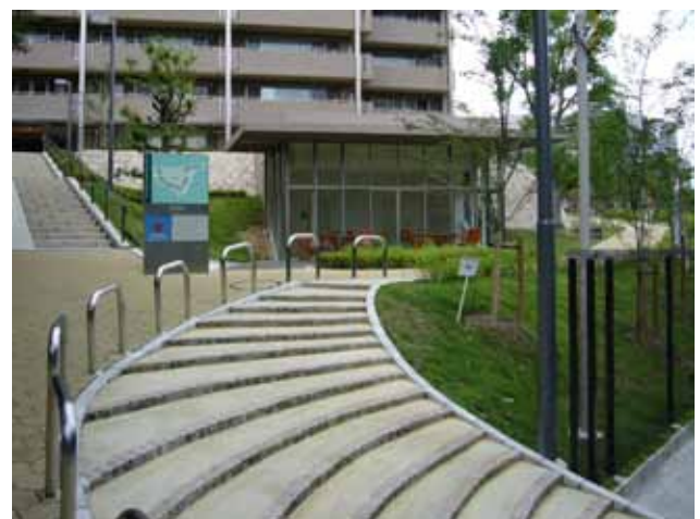
歩行者専用道路に面して設置されたマンション集会室 (大阪府豊中市)
