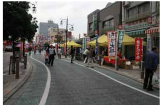
車道を蛇行させることで車の速度を抑制した歩行者優先の道路（埼玉県熊谷市）
