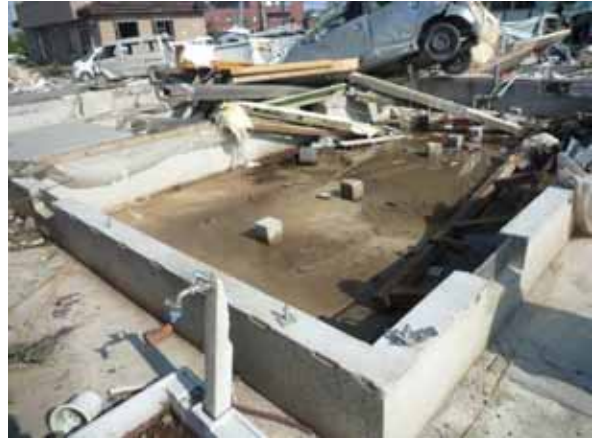
写真 3.1-10 写真 3.1-9 の基礎（隅角部）
