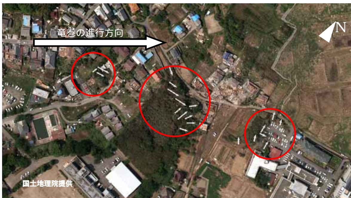
写真 3.5-19 樹木の折損状況（上空からの写真）
