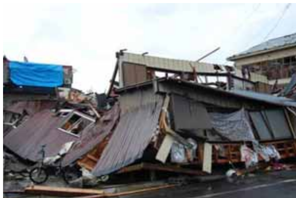
写真 3.1-22 倒壊した木造建築物
