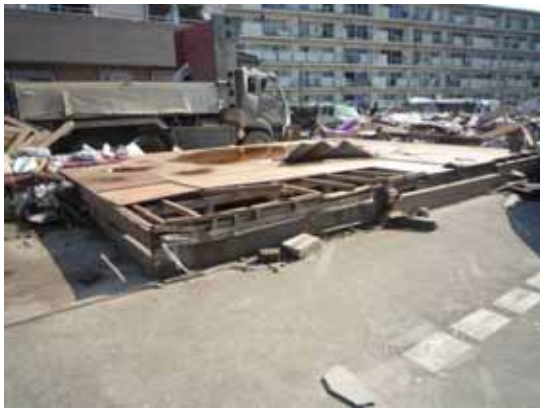
写真 3.1-13 土台を残し飛散した木造建築物
