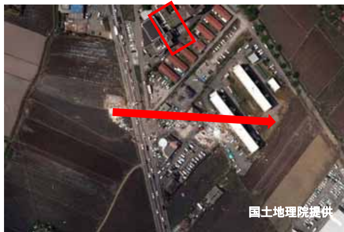
写真 3.3-3 鉄骨造建築物 B(線囲み)と調査建築物の被害中心線(矢印)との位置関係
