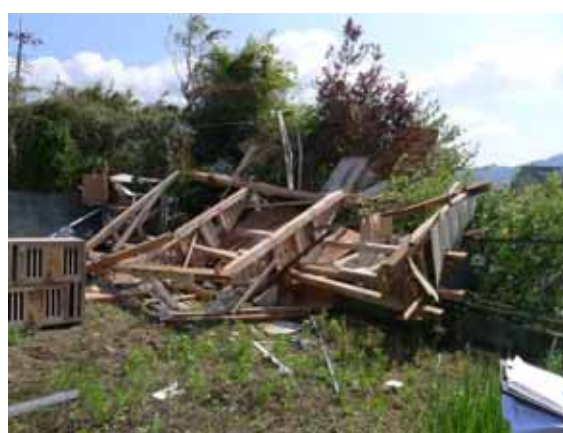
写真 3.1-27 倒壊した木造建築物
