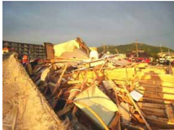
写真 3.1-2 写真 3.1-1 の 2 階床面
