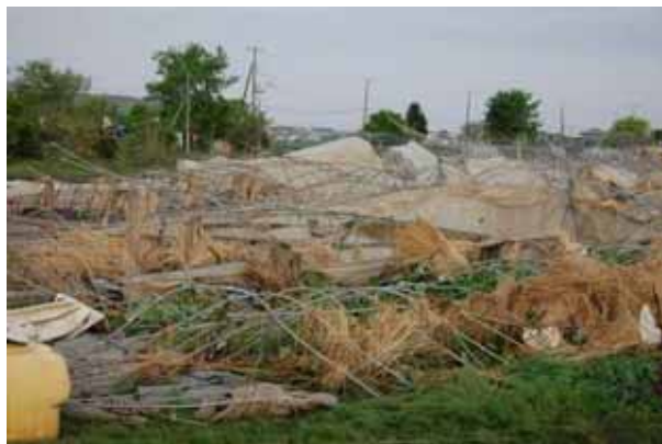
写真 3.5-9 パイプハウスの被害状況
