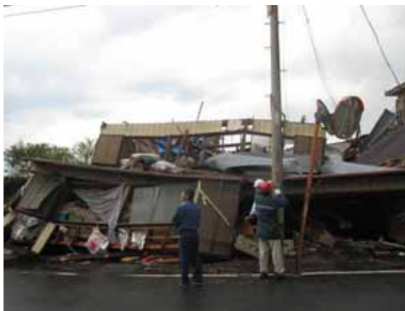
写真 3.1-29 傾斜した木造建築物
