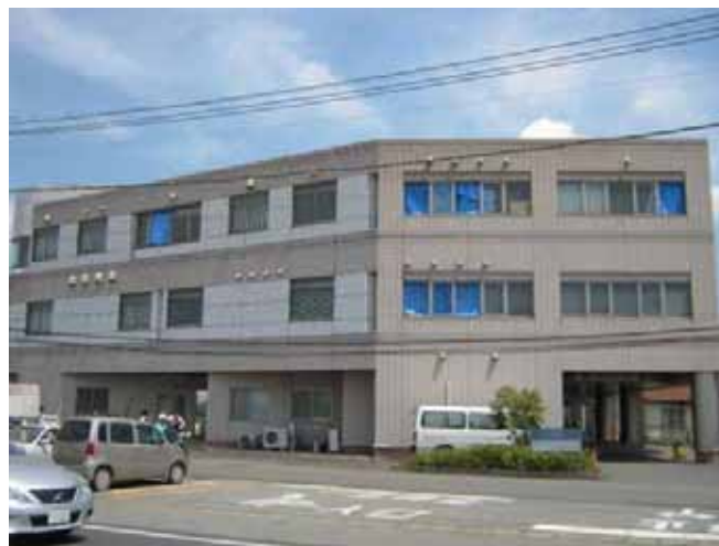
写真 3.3-4 鉄筋コンクリート造建築物 B
