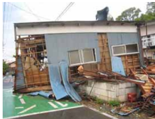
写真 3.1-31 移動した木造建築物の外観
