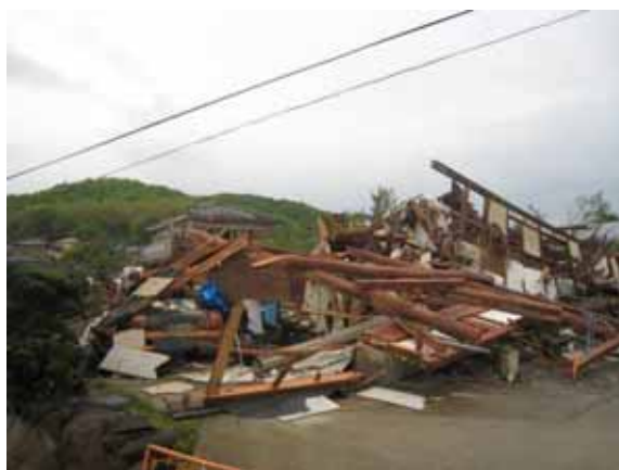
写真 3.1-26 倒壊した木造建築物
