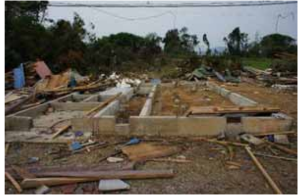
写真 3.1-18 写真 3.1-17 の基礎外観
