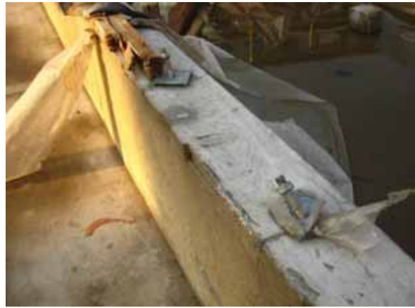
写真 3.1-12 写真 3.1-9 の残存する接合金物
