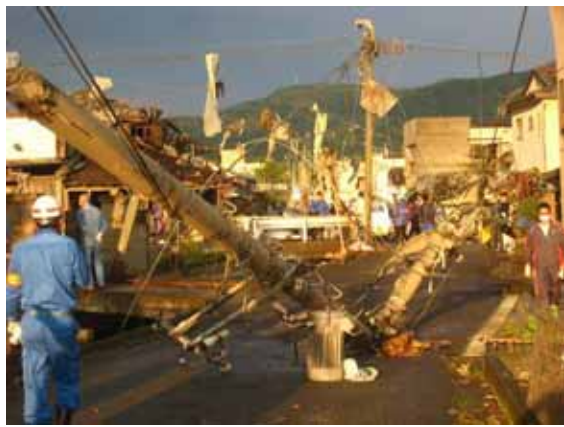
写真 3.5-7 電柱の折損・傾斜
