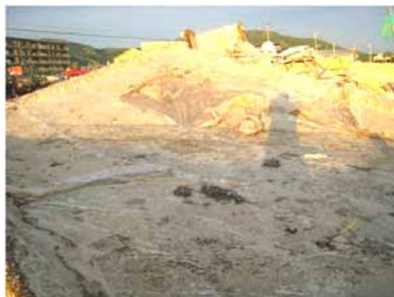
写真 3.1-4 写真 3.1-1 のべた基礎底面の防湿シート
