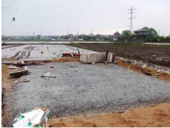
写真 3.1-5 基礎下の割栗石の状況
