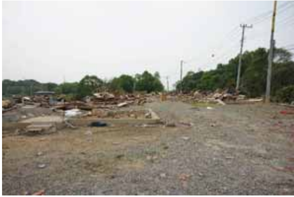
写真 3.1-17 飛散した木造建築物群
