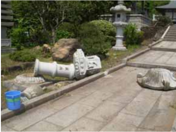
写真 3.5-5 石灯籠の倒壊
