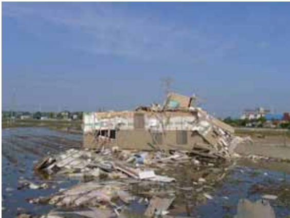
写真 3.1-1 基礎から転倒した木造建築物
