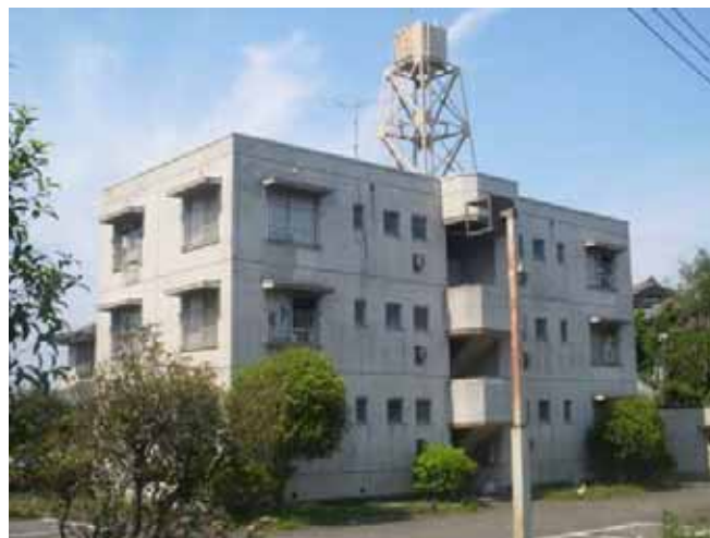
写真 3.3-2 鉄筋コンクリート造建築物 A
