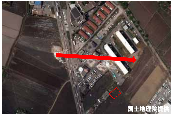
写真 3.2-4 鉄骨造建築物 B(点線)と調査建築物の被害中心線(矢印)との位置関係
