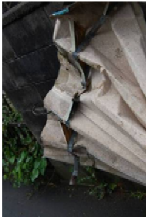
写真 3.4-6 飛来物（鋼板製屋根材）の衝突
