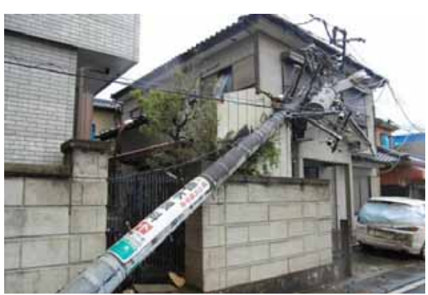
写真 3.5-8 電柱の折損・傾斜
