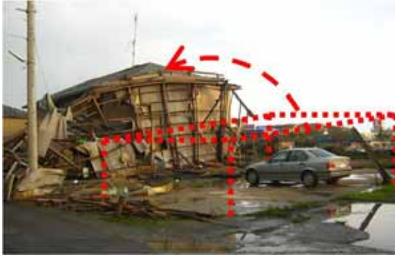
写真 3.2-8 鉄骨造建築物 C
