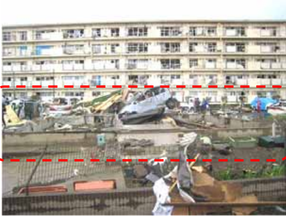
写真 3.1-9 飛散した木造建築物
