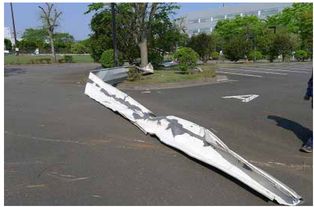
写真 3.4-10 飛散した鋼板製屋根材
