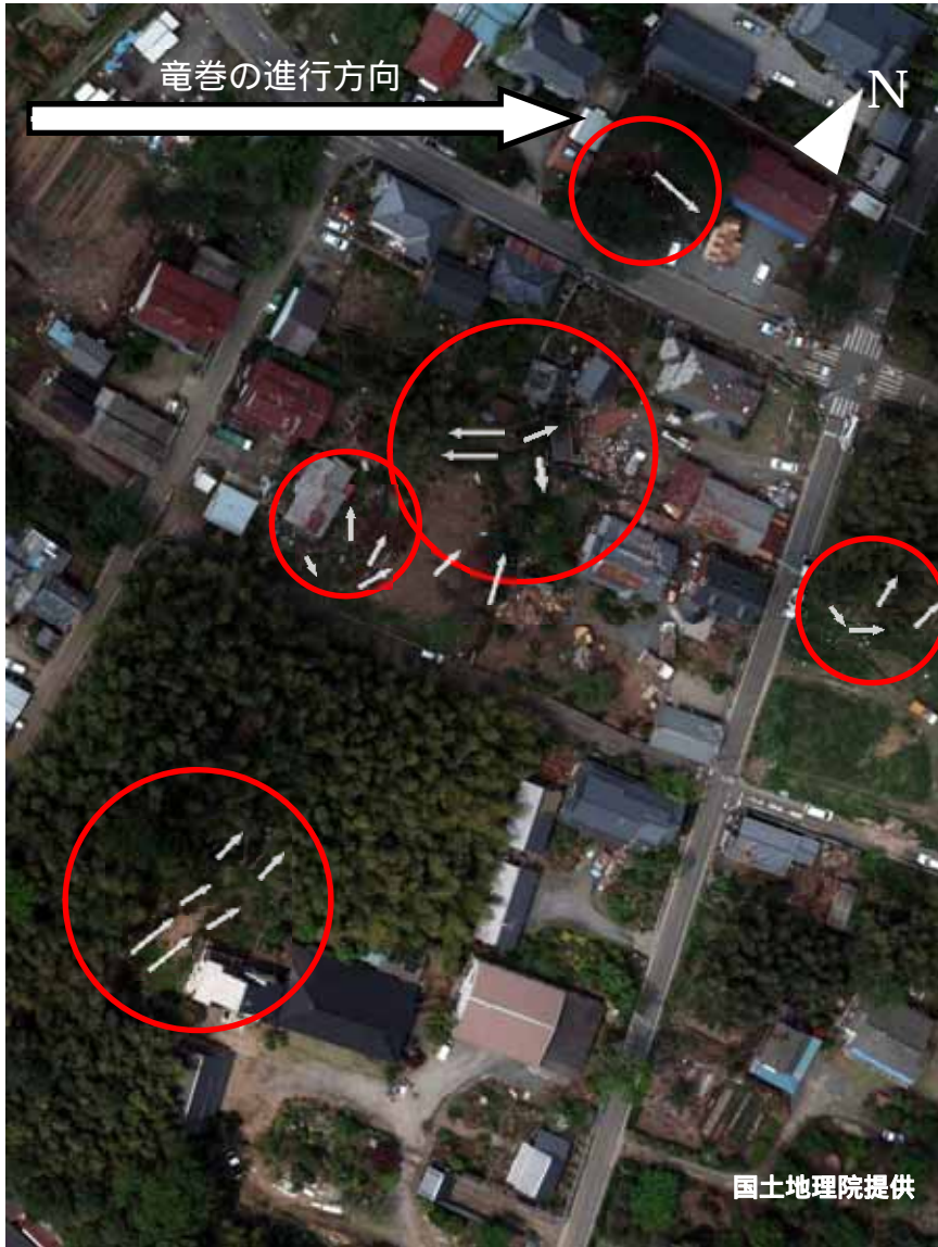
写真 3.5-20 樹木の折損状況（上空からの写真）
