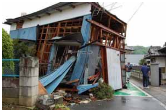
写真 3.1-30 移動した木造建築物の外観
