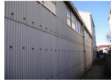
写真5 実験場所（外壁面）
