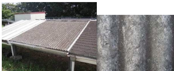
写真6 スレート小波板
