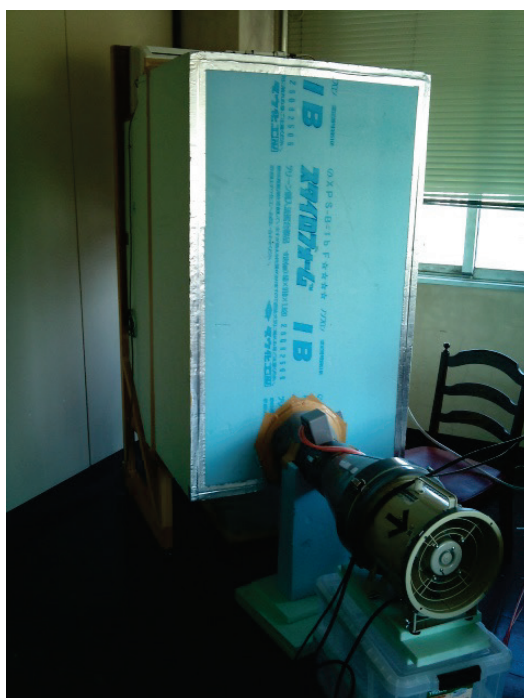
図 7.2.6.5 風量測定ボックスを吹き出し口に取り付け気密測定器により風量測定を実施しているところ
