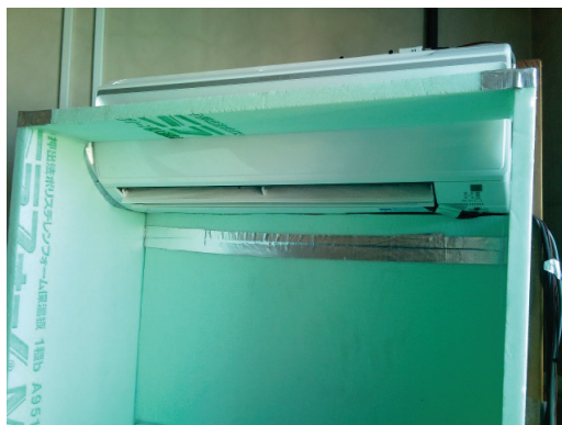
図 7.2.6.1 風量測定ボックスを吹き出し口に取り付けたところ
