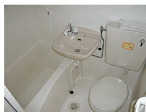
トイレ付ユニットバス
