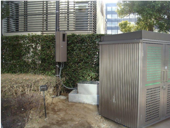
(2-1) 公園内強震観測装置カバー, 電源ポール (上部 GPS アンテナ設置)
