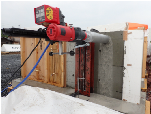
模擬壁部材からのコア採取の状況
