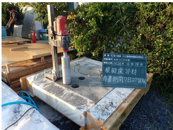
模擬床部材からのコア供試体の採取状況
