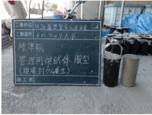
軽量型枠の脱型
