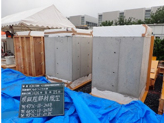
模擬柱部材の型枠の脱型
