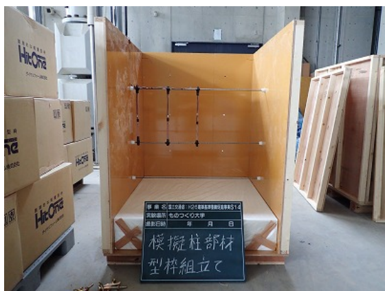
模擬柱部材の型枠の組立て状況
