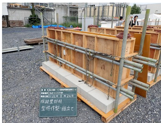
模擬壁部材の型枠の組立て状況
