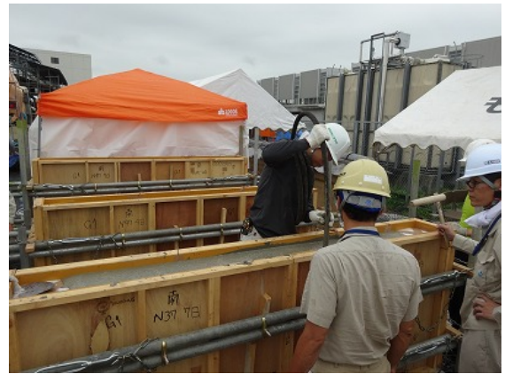
模擬壁部材の締固めの状況
