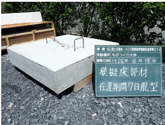
模擬床部材の型枠の脱型
