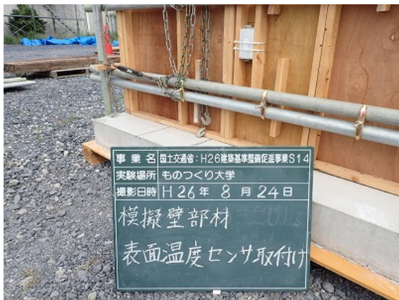
模擬壁部材の表面温度センサの取付け状況
