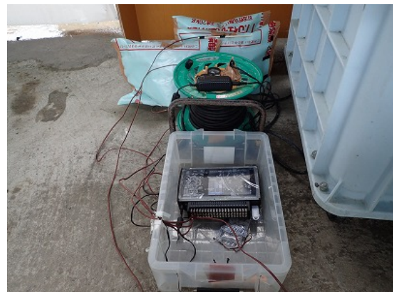
管理用供試体(現場封かん養生)の温度測定状況
