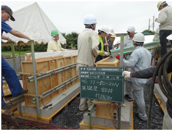
模擬壁部材への打込み
