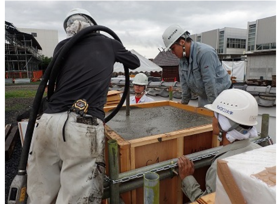
模擬柱部材の締固めの状況
