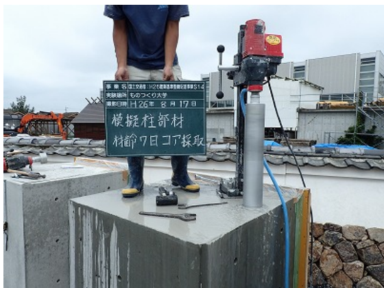
模擬柱部材からのコア供試体の採取状況
