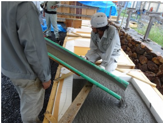
模擬床部材への打込み
