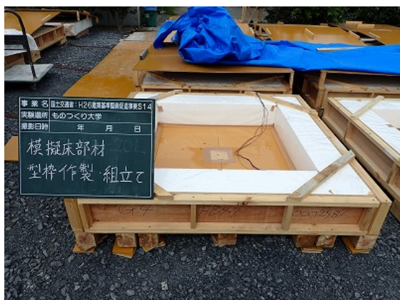
模擬床部材の型枠の組立て状況
