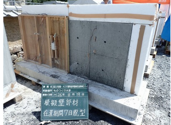
模擬壁部材の型枠の脱型
