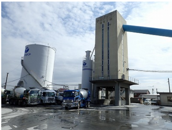
コンクリートの製造場所の全景
