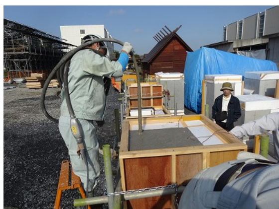
付写真 2-3 締固め状況
