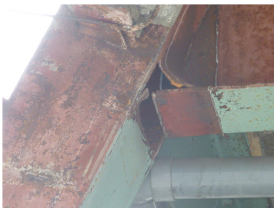
写真 5.4-5 梁端破断
