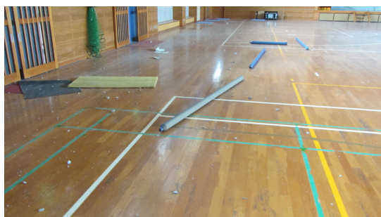
写真 5.4-142 落下した立体トラスの部材
