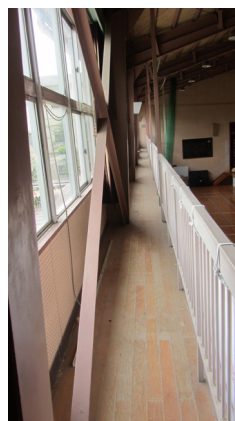
写真 5.4-64 2階（ギャラリーレベル）鉛直ブレース（被害なし）
