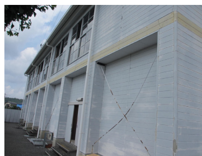
写真 5.4-123 1階のブレースの様子
