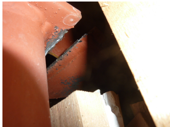
写真 5.4-19 梁端破断
