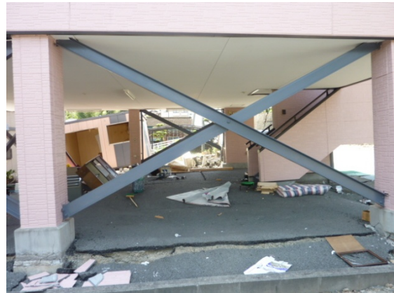
写真 5. 4-36 ブレースの状況 (ほぼ無損傷)
