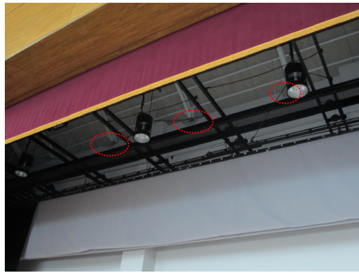
写真 5.4-160 ステージ上の下屋の支承部コンクリートの破損
