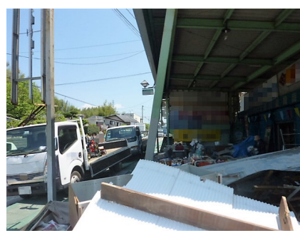
写真 5. 4-32 柱の傾斜
