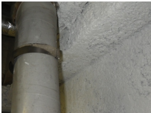
写真 5.8.2-77 1階旧ボイラー室内壁
