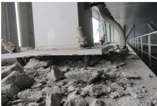
写真 5.8.2-44 屋根支承部の被害 (d ホール)
