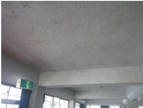
写真 5. 8. 2-81 2階ギャラリー天井(RC スラブ裏)
