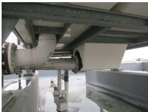
(a) 破断箇所の様子
