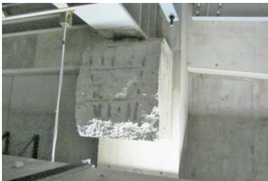
写真 5.8.2-44 屋根支承部の被害 (d ホール)
