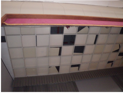
写真 5. 8. 2-89 ステージ天井板
