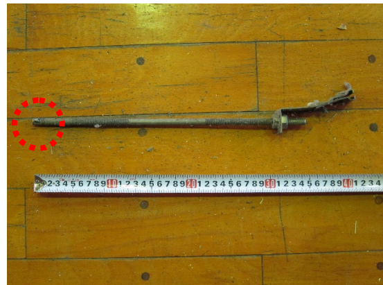
写真 5.8.2-18 吊り材(円内は溶接痕)
