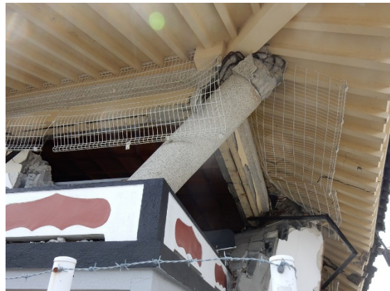
写真5.5-226 柱頭部の配筋
