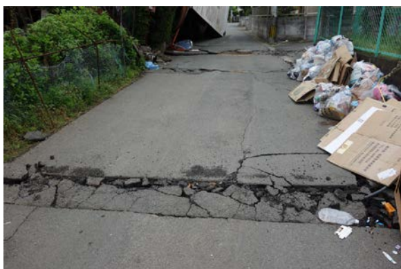
写真 5.6-1 A 通り・県道 28 号北側の道路の舗装の様子
