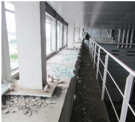
写真 5.8.2-29 屋根支承部及びガラス（建築物D dホール）
