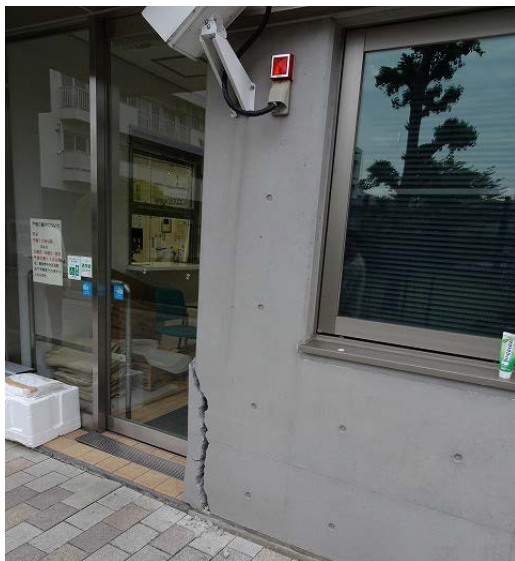
写真5.5-128 外壁端部のひび割れ
