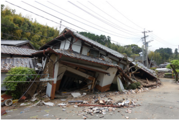
写真 5.3-36 倒壊した木造住宅
