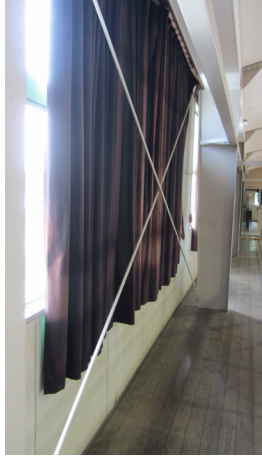
写真 5.4-111 2階鉛直ブレース
