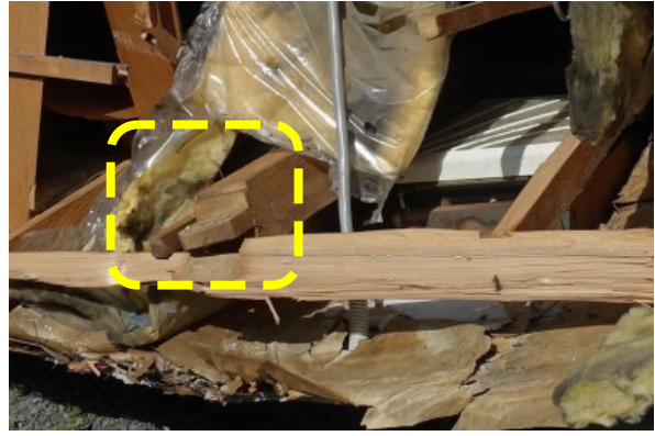
写真 5.3-15 写真 5.3-13 の住宅の柱頭部 (柱脚柱頭金物確認できず)
