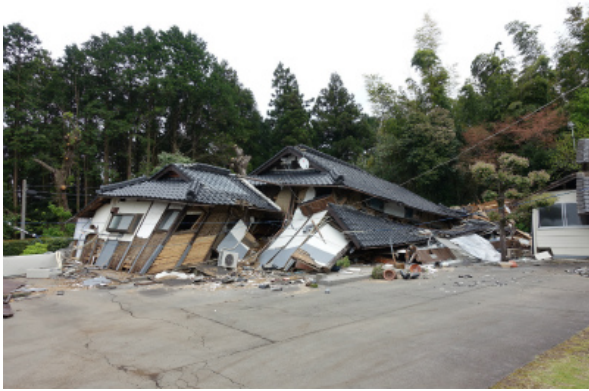
写真 5.3-38 倒壊した木造住宅
