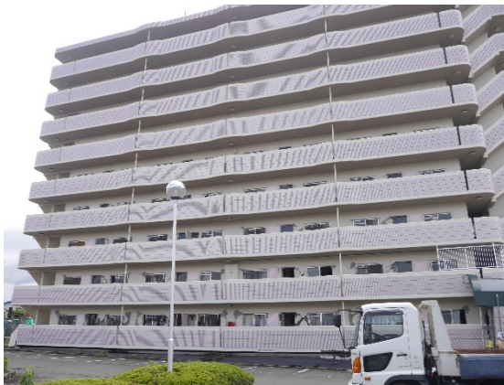
(a) 北側から見た全景
