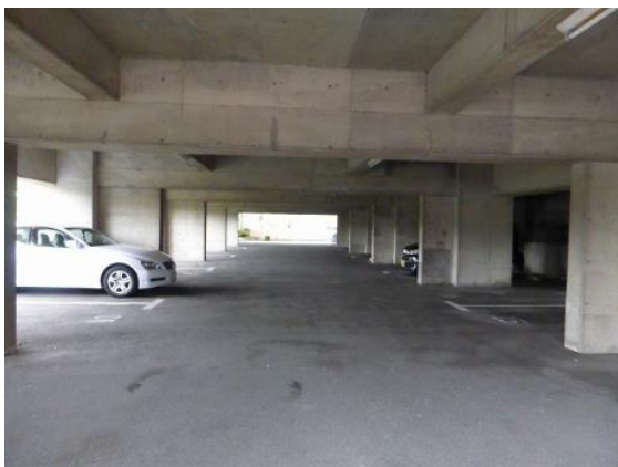
写真5.5-71 駐車場階（1階）全景
