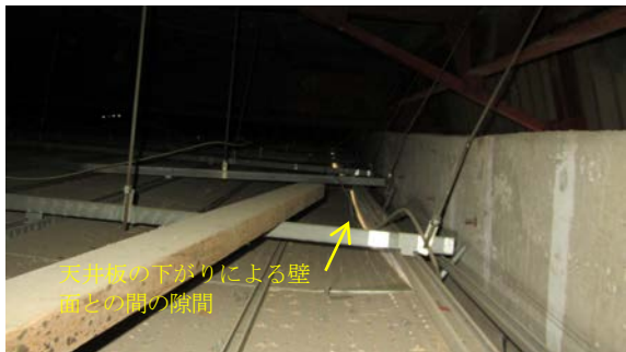
写真 5. 8. 2-86 アリーナ上部吊り天井裏
