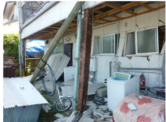
写真 5.4-30 柱の傾斜
