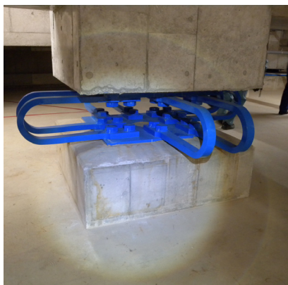
写真 5. 7. 2-26 U形鋼材ダンパーの状況
