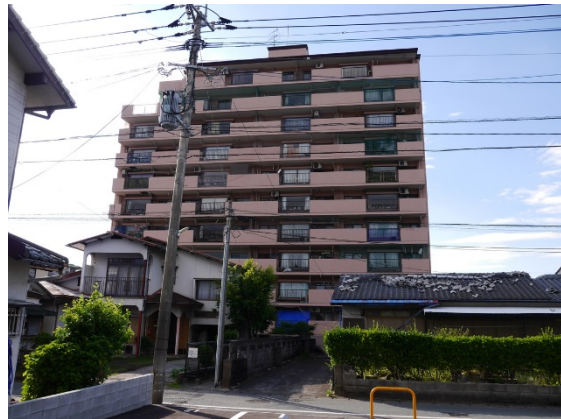
写真5.5-98 建築物南東側
