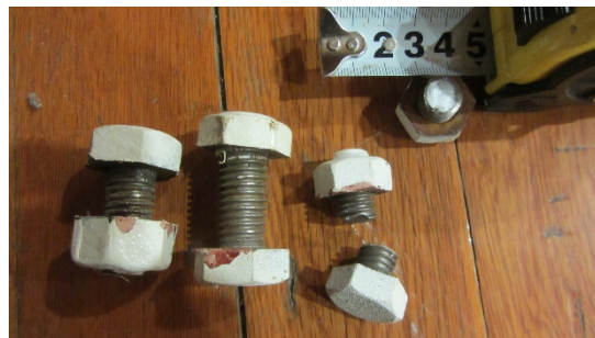
写真 5.4-179 体育館Gの屋根面水平ブレースのボルト
