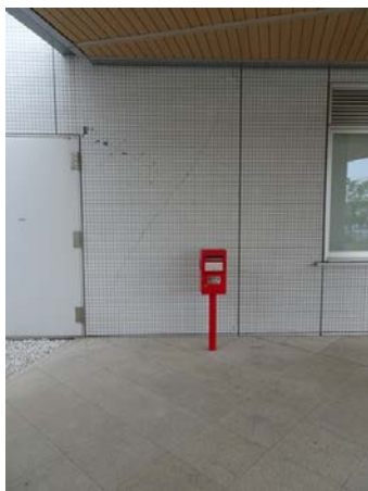
写真5.5-111 耐力壁のせん断ひび割れ
