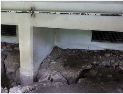
写真5.5-94 建築部外周部の地盤の亀裂
