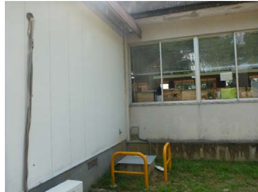
写真5.5-278 地震計設置状況
