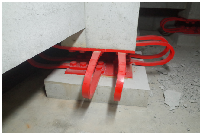
写真 5. 7. 2-52 無被害と見られる鋼材ダンパー及び 取付け基部（北東部）
