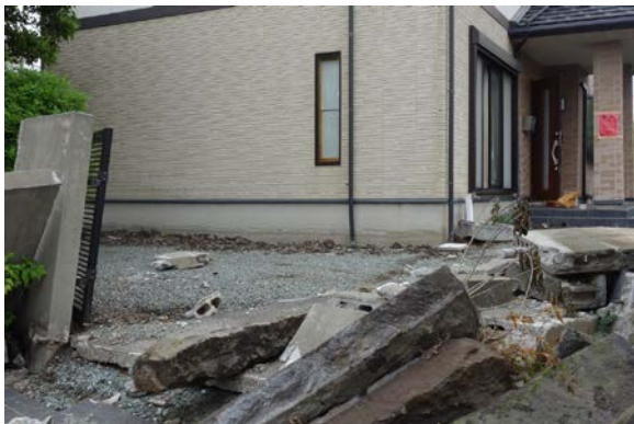
写真 5.6-12 写真 5.6-11 の建築物の基礎と周辺地盤。地盤変状が認められるが、基礎は無被害
