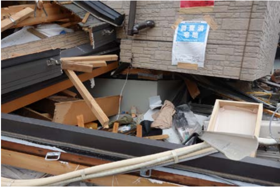
写真 5.6-30 写真 5.6-29 の建築物で辛うじて確認できる基礎。地盤変状はなく、基礎にも損傷は見当たらない。
