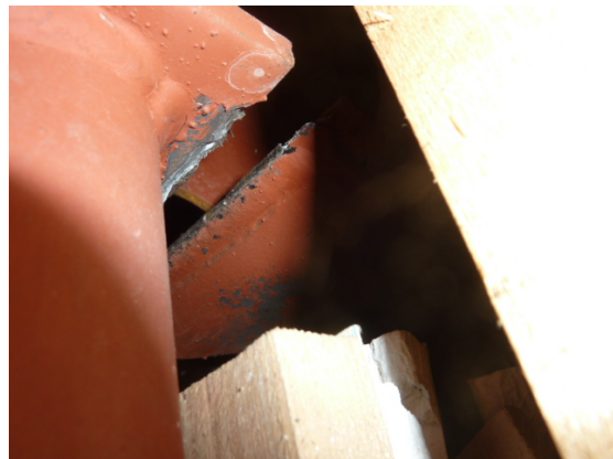
写真 5.4-19 梁端破断
