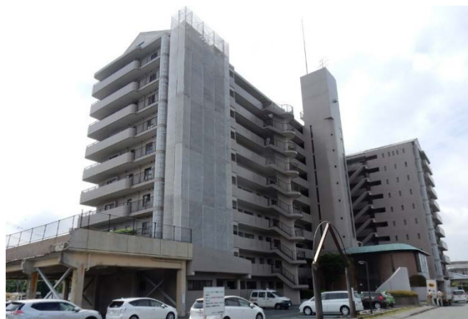
写真5.5-59 建築物（北西側）
