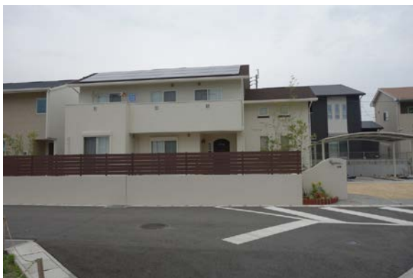
写真 5.6-9 新興住宅地と思われる建築物群。建築物は無被害に見える。道路舗装も健全
