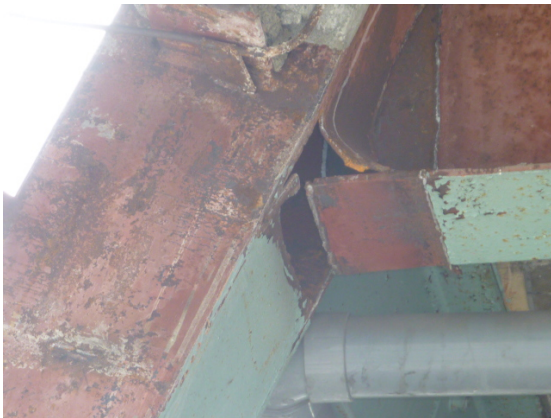
写真 5.4-5 梁端破断
