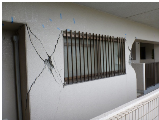
写真5.5-61 桁行き方向の共用廊下側の構面における被害
