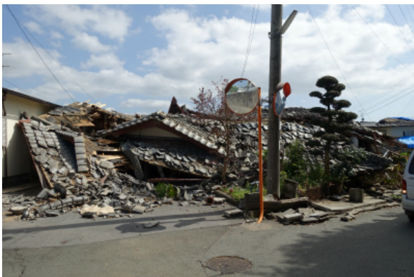
写真5.3-2 倒壊した木造住宅
