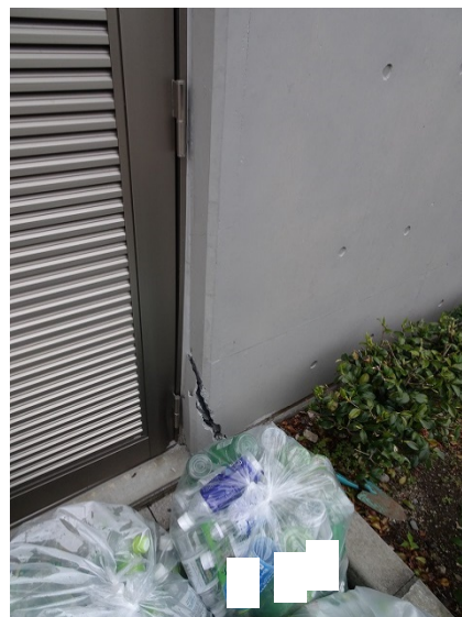
写真5.5-128 外壁端部のひび割れ
