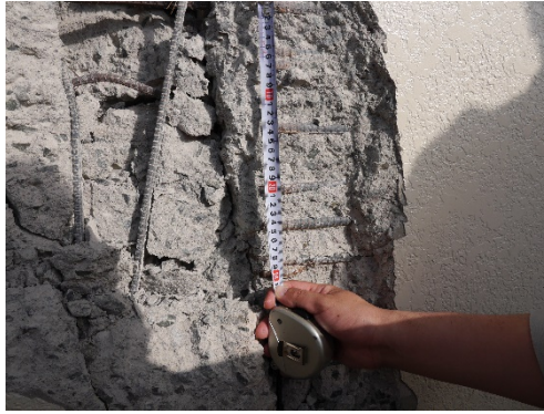
写真5.5-26 柱帯筋の配筋
