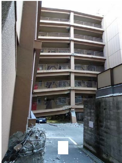
写真5.5-207 東西軸住棟の北側
