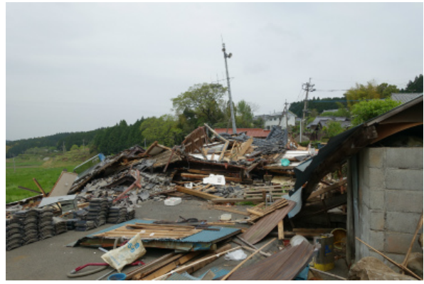
写真 5.3-37 倒壊した木造住宅
