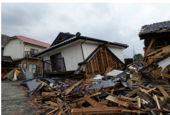
写真 5.3-66 倒壊した木造住宅
