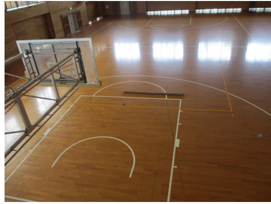
写真 5.4-152 落下したトラス下弦材
