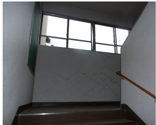
写真5. 5-297 方立壁の被害
