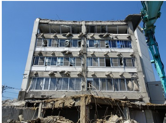
写真5.5-200 一部解体後の外観（南東側）
