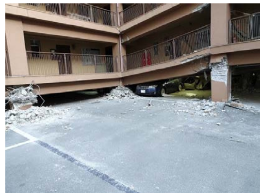
写真5.5-206 L字型平面形状の入り隅部
