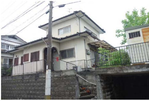
写真 5.6-23 軽微・無被害に見える建築物。擁壁に損傷あり。
