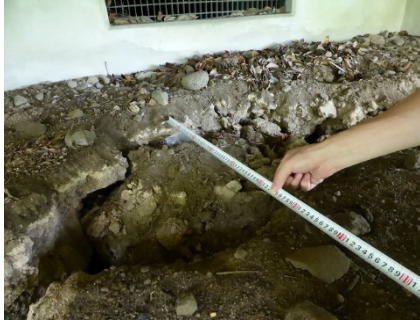
写真5.5-94 建築部外周部の地盤の亀裂
