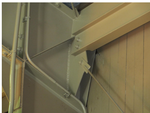
写真 5.4-134 改修で取り替えられたブレース（被害無し）
