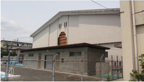
写真 5.4-61 外観（外壁の被害は写真 5.4-69, 5.4-70 参照）
