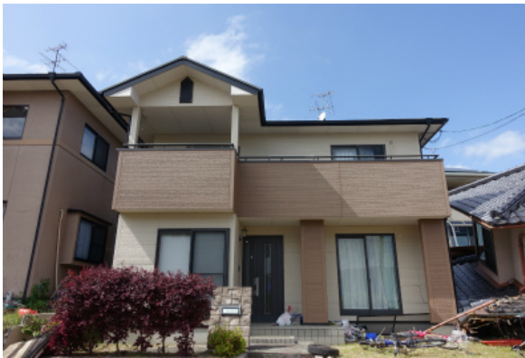
写真5.3-22 外観上無被害の木造住宅
