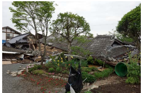
写真 5.6-13 倒壊した建築物。県道 28 号南側は古く見える建築物が多数倒壊
