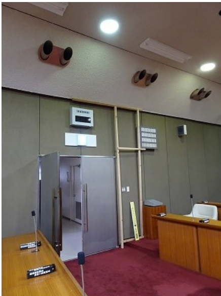
写真5.5-166 斜めに配置された天井材脱落 に対する応急措置
