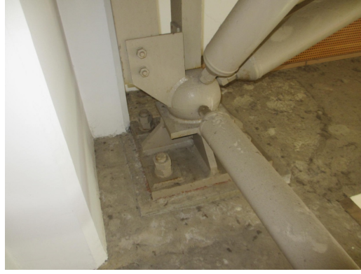
写真 5.4-158 建物の4隅はピン支承部であり無被害
