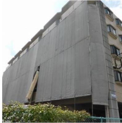
写真5.5-30 建築物南東面
