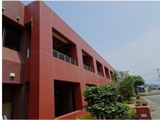
写真5.5-165 外付けフレーム側面
