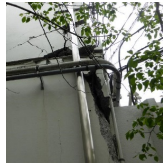
写真5.5-198 北東側2階脚部
