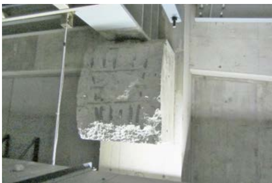
写真 5.8.2-44 屋根支承部の被害 (d ホール)
