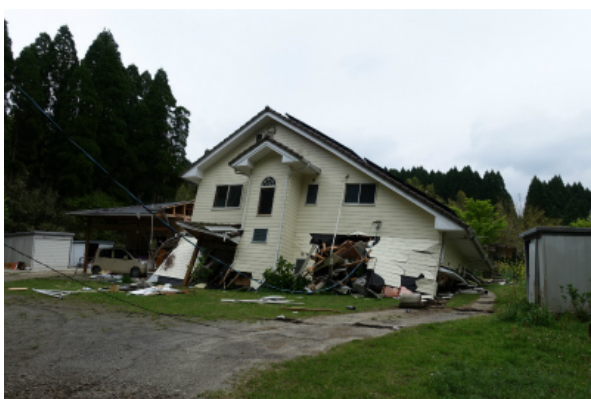
写真 5.3-68 倒壊した木造住宅（金物あり）
