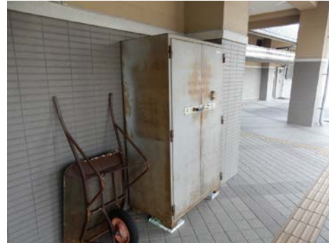
写真5.5-148 転倒した金庫
