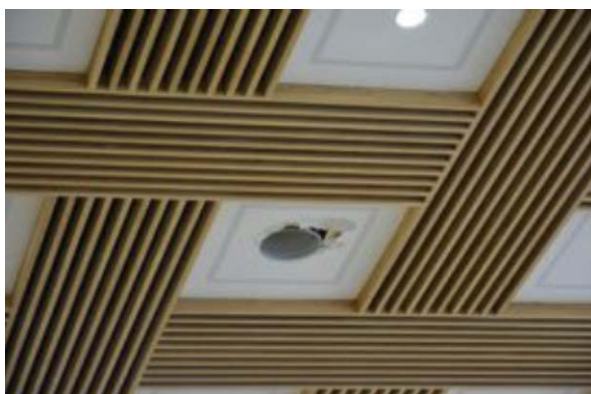
(a) 空港旅客ターミナルにおける アネモスタットの脱落
