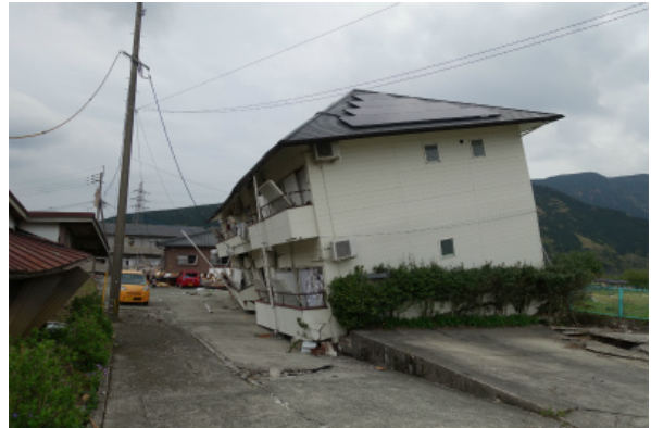
写真 5.3-59 横ずれした木造アパート
