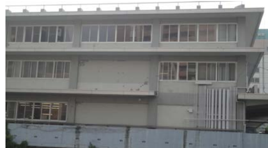
写真5.5-183 建築物外観 (東側)
