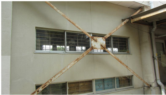
写真 5.4-63 1階鉛直ブレース（被害なし）
