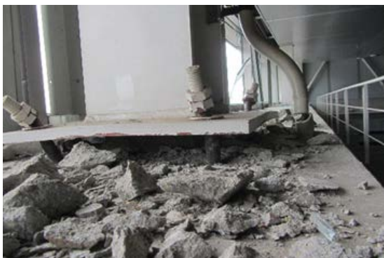
写真 5.8.2-44 屋根支承部の被害 (d ホール)
