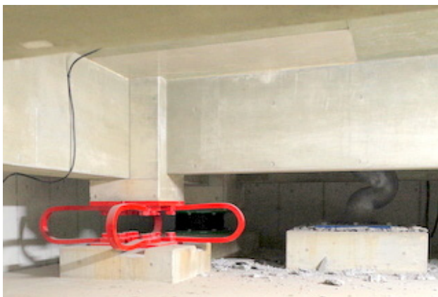
写真 5.7.2-18 鋼材ダンパーと鉛ダンパーの比較
