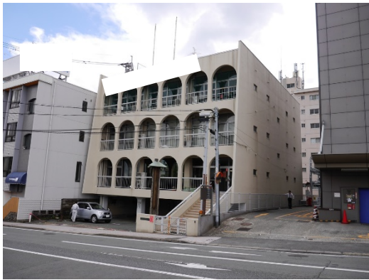
写真5.5-307 建築物北西側
