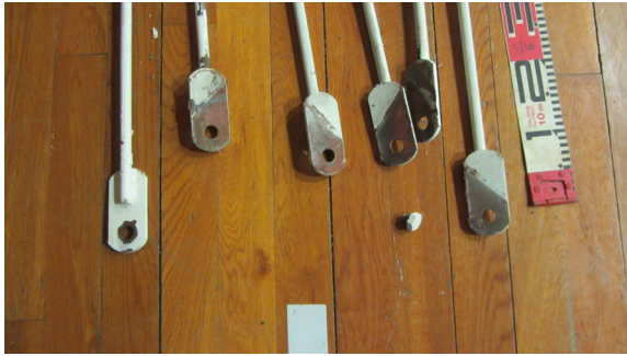
写真 5.4-101 撤去された屋根面の水平ブレースの羽子板部分（ボルト孔は健全）
