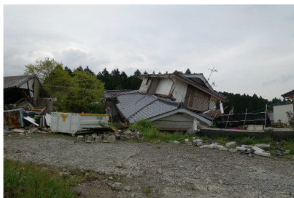
写真 5.3-67 倒壊した木造住宅
