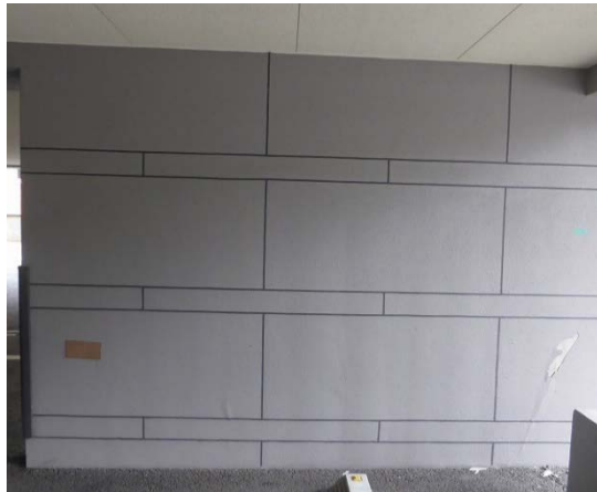
写真5.5-43 1階柱の張間方向に取付く袖壁
