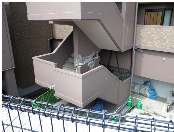
写真 5. 7. 2-40 外付け階段の被害状況② (階段北側)
