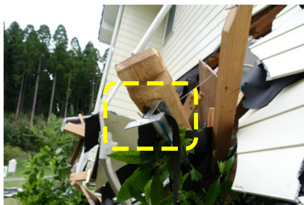
写真 5.3-69 写真 5.3-68 の住宅の柱頭部 （柱脚柱頭は金物あり）
