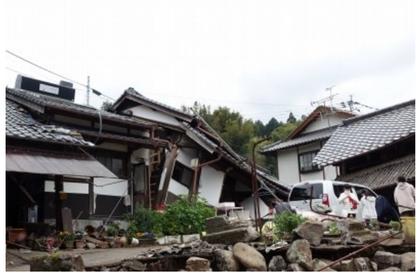
写真 5.3-39 倒壊した木造住宅
