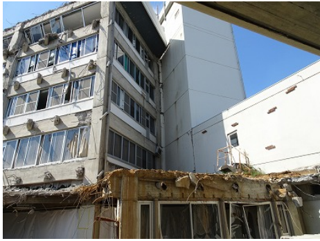
写真5.5-203 一部解体後の外観（東側）
