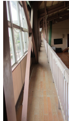
写真 5.4-64 2階（ギャラリーレベル）鉛直ブレース（被害なし）
