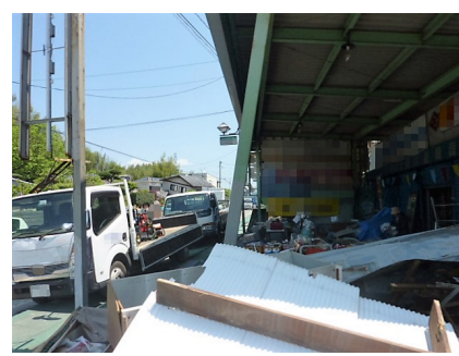
写真 5.4-32 柱の傾斜
