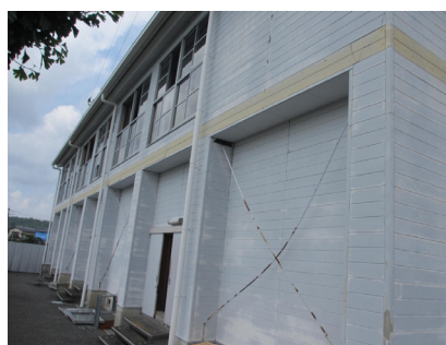
写真 5.4-123 1階のブレースの様子
