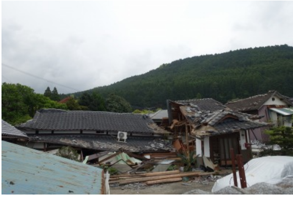
写真 5.3-28 分離した木造住宅
