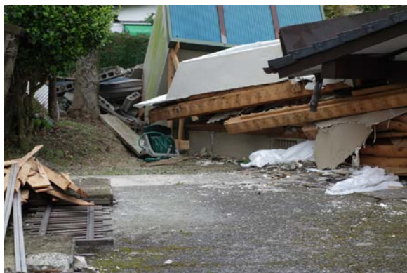
写真 5.6-3 写真 5.6-2 の基礎のひび割れを確認。地盤変状は確認できなかった。
