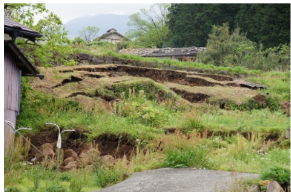
写真 5.3-35 地盤に生じた亀裂
