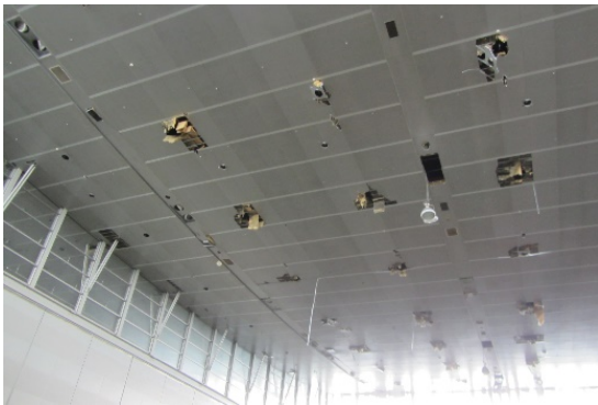
写真 5.8.2-9 天井（bホール）
