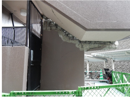
写真 5. 7. 2-39 外付け階段の被害状況① (階段南側)
