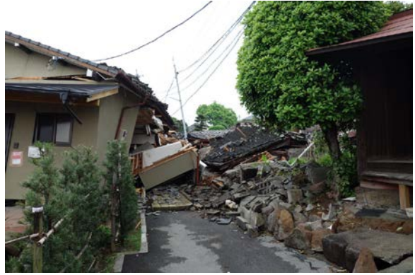
写真 5.6-31 倒壊した建築物。A 通りと同様に、県道 28 号南側は古く見える建築物が多数倒壊
