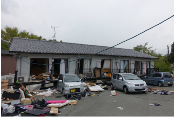
写真 5.3-46 倒壊したアパート A
