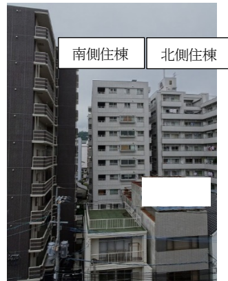
写真5.5-74 隣接建築物から撮影した外観
