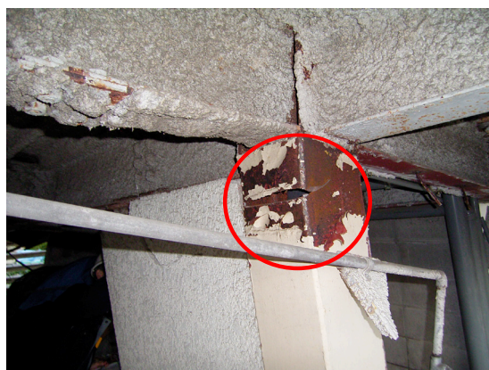
写真 5.4-26 柱の破断
