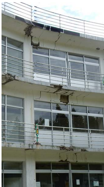
写真5.5-185 大梁の破壊
