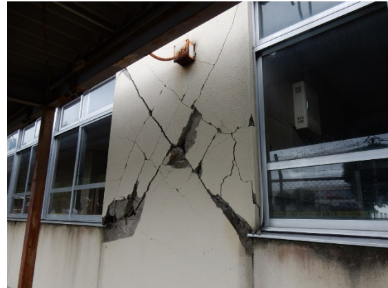
写真5. 5-297 方立壁の被害
