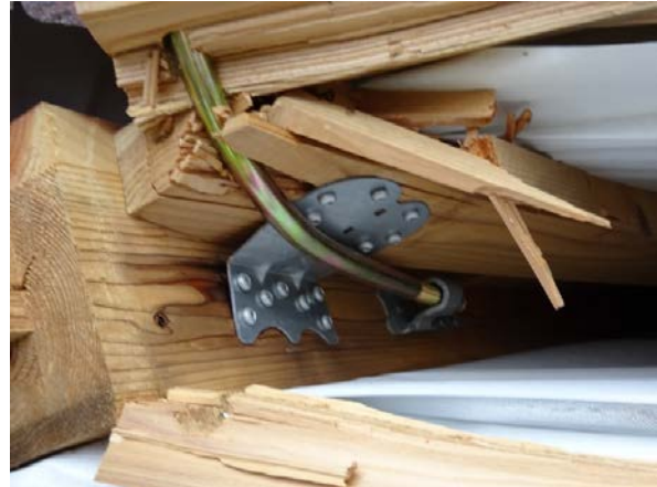
写真 5.3-19 写真 5.3-18 の建物の筋かい端部、 柱脚接合部 (金物を確認)
