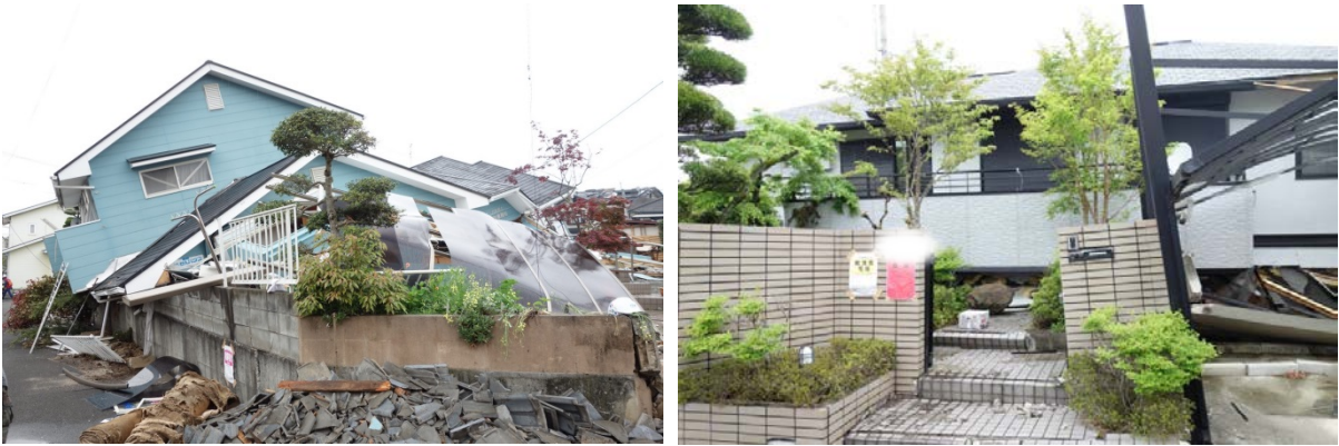
写真 5. 6-43 建築物の倒壊により基礎もしくは敷地地盤全体の状況確認が困難な事例（2例）
