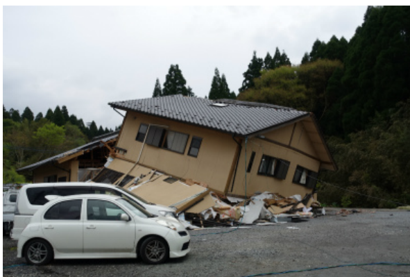
写真 5.3-64 倒壊した木造住宅
