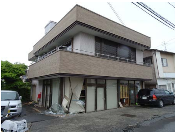
写真 5.6-51 地盤の液状化により沈下・傾斜したと思われる2階建て店舗併用住宅
