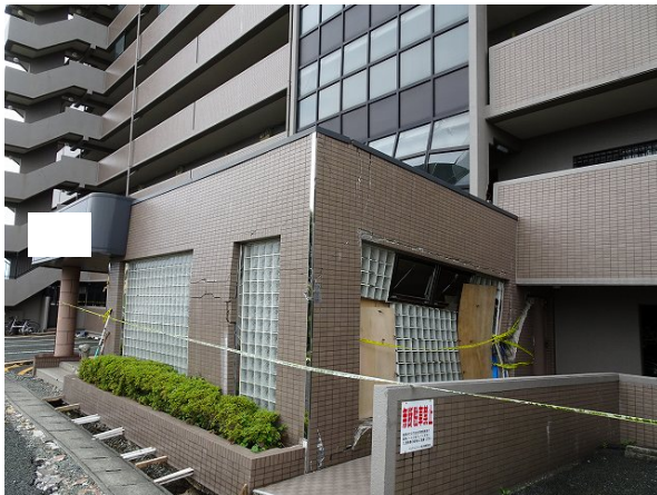
写真5.5-80 1階エントランスホールの外観
