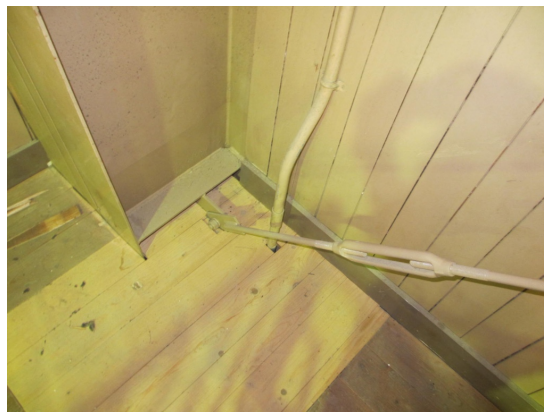
写真 5.4-133 改修で取り替えられたブレース（被害無し）
