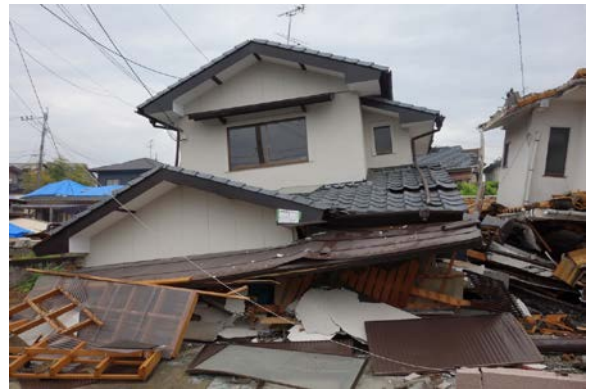
写真 5.6-26 倒壊した建築物
