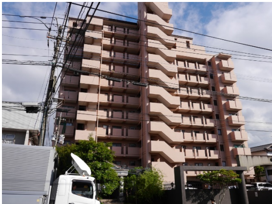
写真5.5-97 建築物北西側
