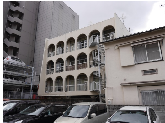
写真5.5-308 建築物南東側
