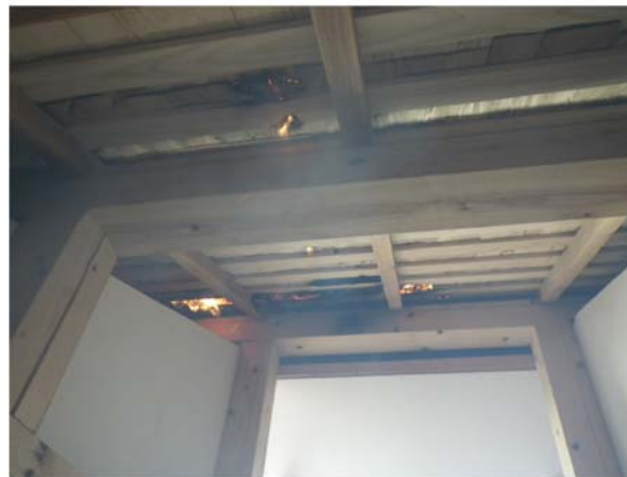
写真 5.3.4 実験中の屋内側の状況
