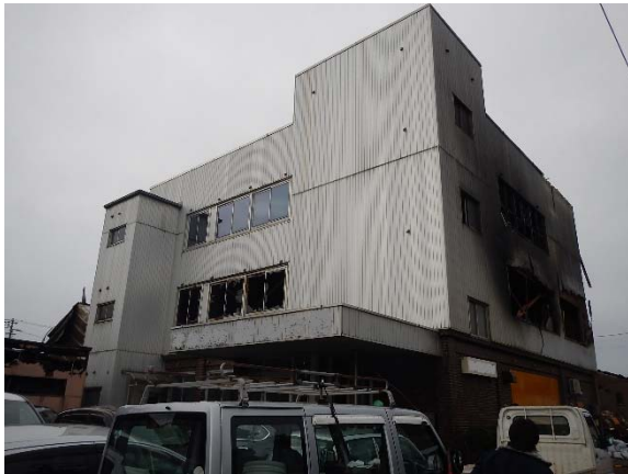
写真 3.3.13.1 事務所建物南東側の状況
