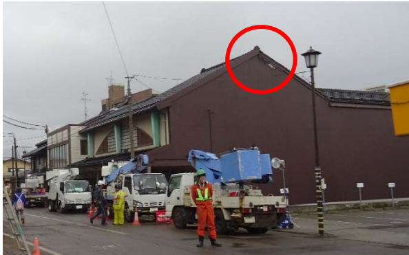
写真 3.3.6.1 北西から見た外観
