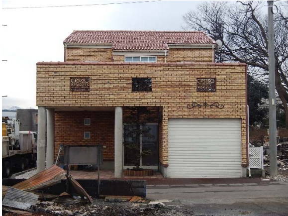
写真 3.3.12.5 戸建住宅北側の状況
