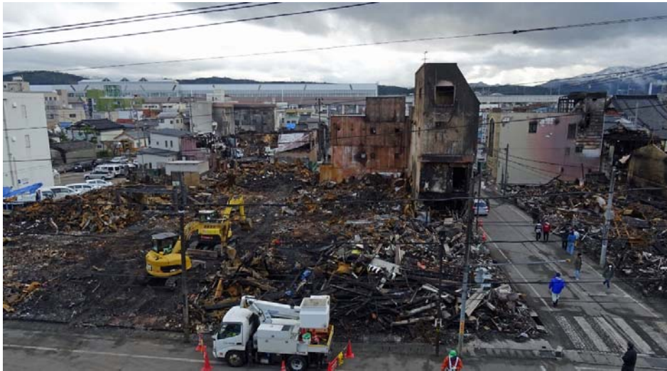
写真 3.1.5 県道西中・糸魚川線以南の焼損状況 (写真右側は仲道線。全焼建物が多く見られる)
