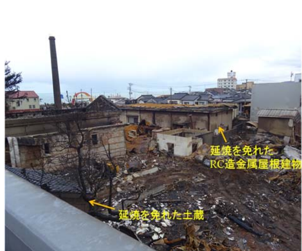
写真 3.3.11.2 延焼後の敷地の様子
