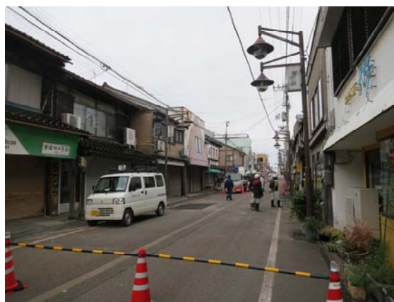
写真 3.2.1.2 南 1 焼け止まり線の様子 (南→北)
