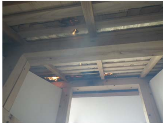
写真 5.3.4 実験中の屋内側の状況
