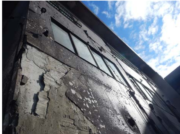
写真 3.2.1.7 南 4 焼け止まり線の RC 造建物 (西面)
