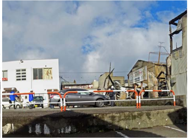
写真 3.2.2.6 西3焼け止まり線の様子
