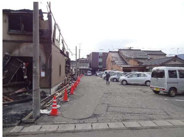
写真 3.2.2.10 西5焼け止まり線（北→南）
