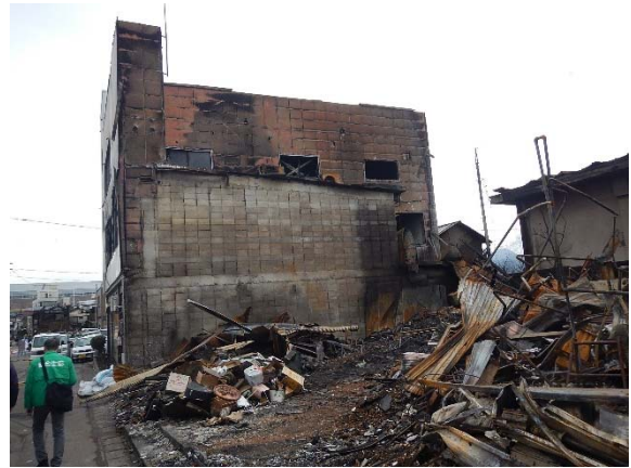
写真 3.3.13.2 事務所建物北側の状況
