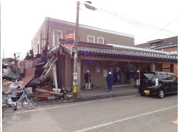
写真 3.2.2.8 西4焼け止まり線 (④金融機関建物 北壁面)
