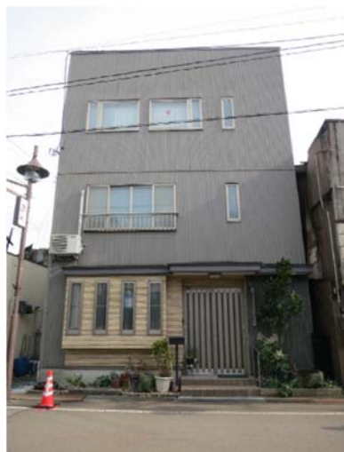
写真 3.3.2.1 仲道線側外観（西側）
