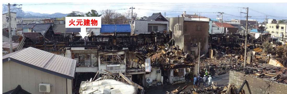
写真 3.1.2 火元建物背後の様子
