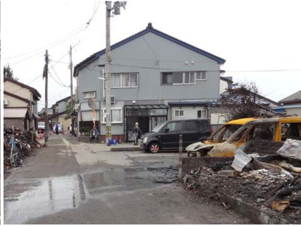
写真 3.2.2.14 浜町通線から見た西 7 焼け止まり線南端の様子（東→西）
