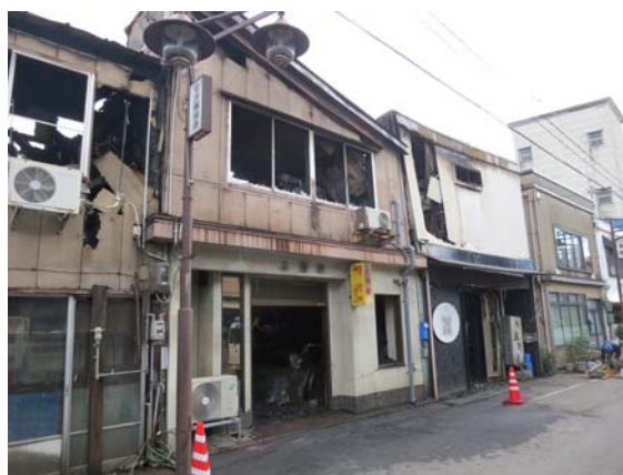
写真 3.2.1.1 火元建物と隣接建物
