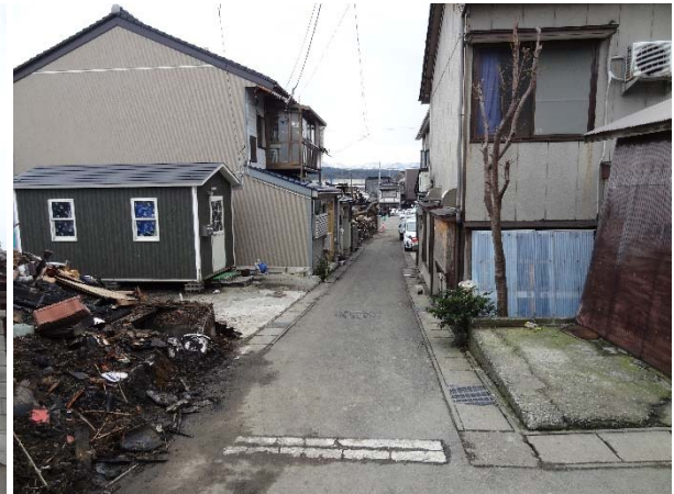
写真 3.2.2.12 西 6 焼け止まり線 (北→南)
