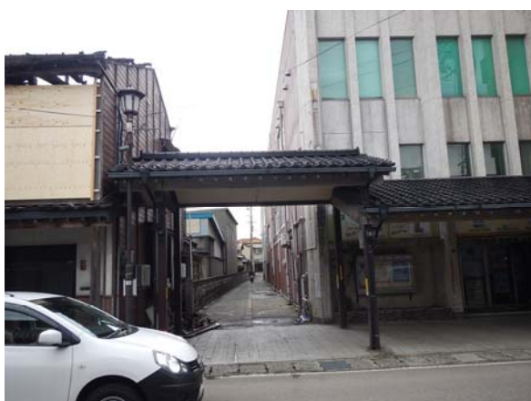
写真 3.2.3.3 東 3 焼け止まり線 (北側に向かって撮影。写真左側が焼損区域)
