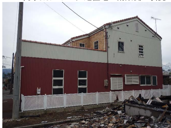
写真 3.3.12.4 戸建住宅西側の状況
