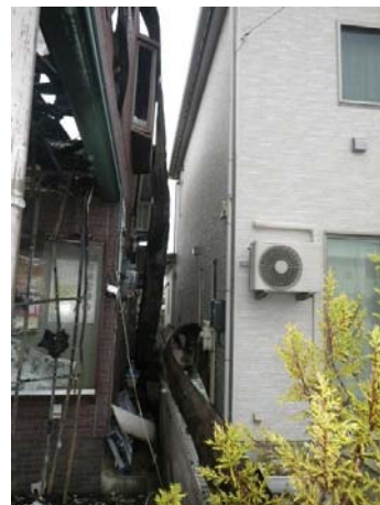
写真 3.3.5.2 西壁の状況（開口部が少ない）
