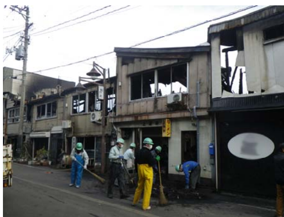
写真 3.3.1.1 火元建物の西面の様子
