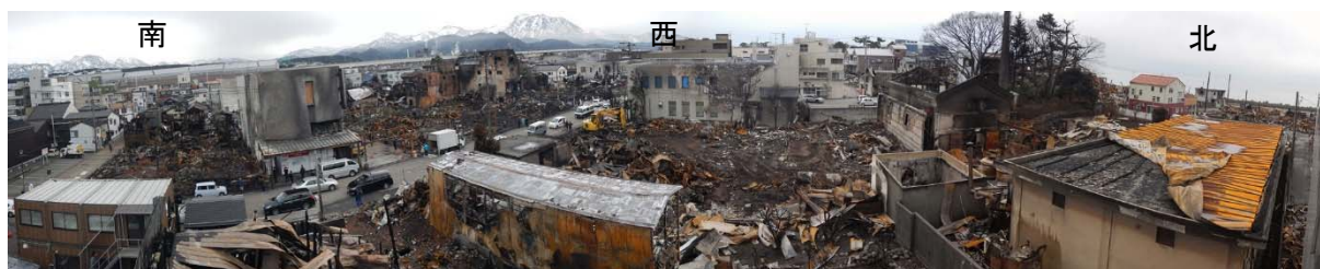
写真 3.1.7 南側・西側及び北側の焼損状況
