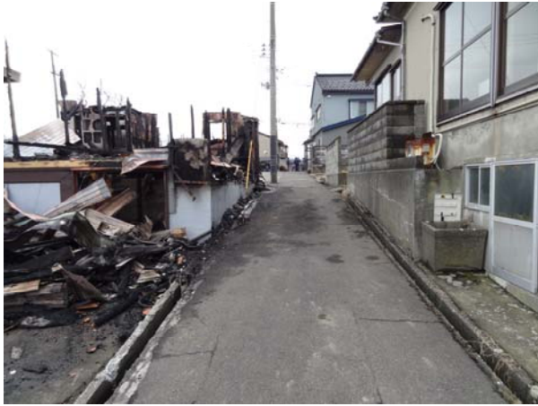
写真 3.2.2.13 西 7 焼け止まり線（北→南）
