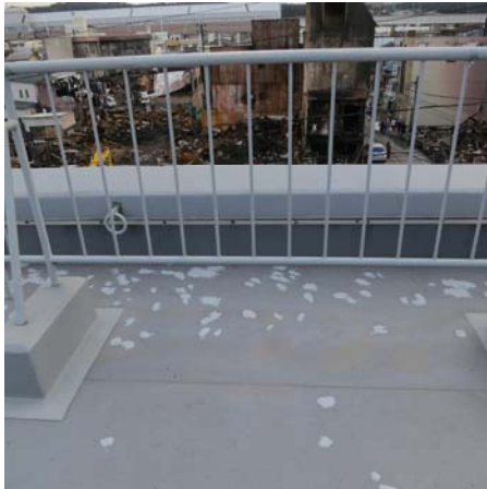
写真 3.3.10.3 屋上パラペット付近の様子
