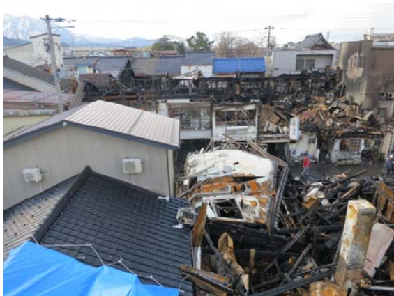
写真 3.2.1.4 南 3 焼け止まり線の様子 (東→西)
