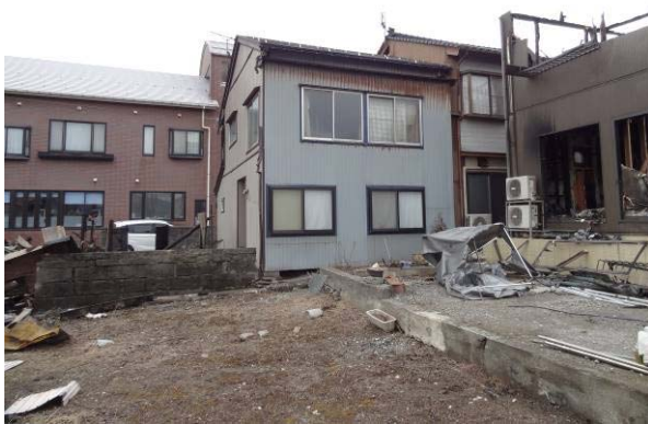
写真 3.3.9.1 建物 a の南東から見た外観
