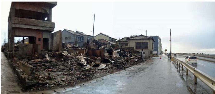
写真 3.1.10 国道8号沿いの様子
