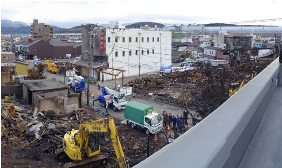
写真 3.1.6 県道西中・糸魚川線の北側及び南側の焼損状況 (写真左前が北側。全焼建物が多く見られる)
