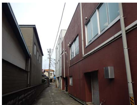
写真 3.2.3.4 東 3 焼け止まり線 (写真 3.2.3.3 中央の通路奥から北側に向かって撮影。写真左側が焼損区域)
