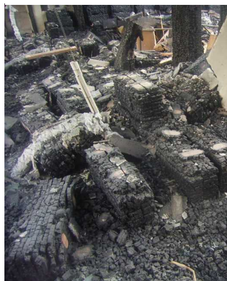
写真 3.7.7-13 1階クリブの燃え残り
