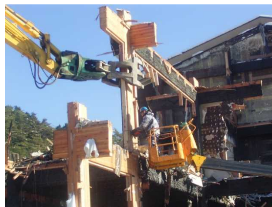
写真 3.7.7-2 構造部材解体・採取の様子
