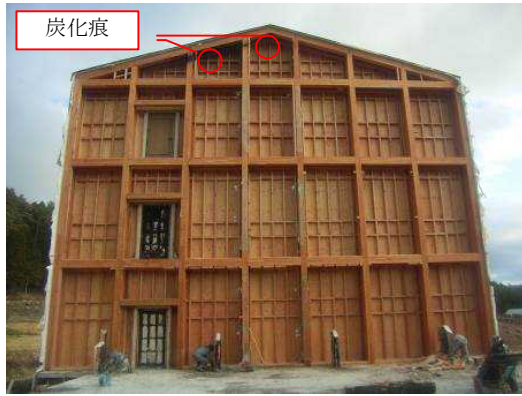
写真 3.7.7-27 合板撤去後の防火壁の状況
