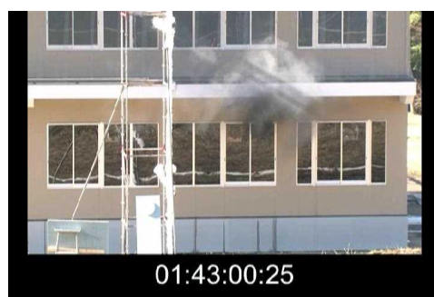
写真 3.7.2-9 北側窓ガラスの破損
