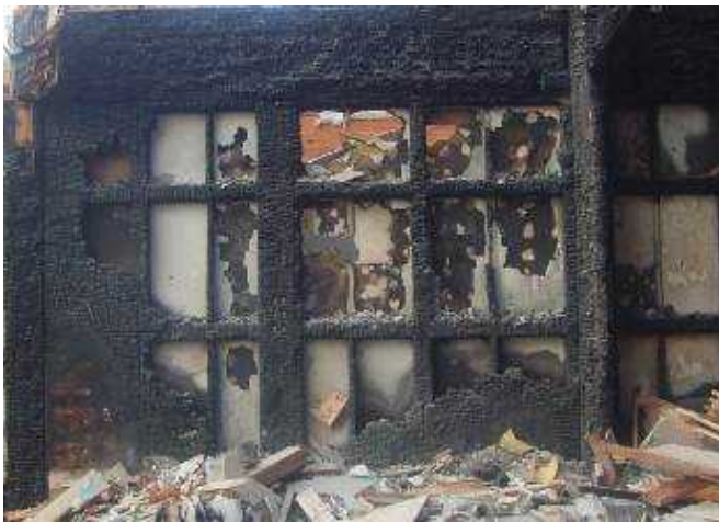
写真 3.7.7-10 1階階段室側耐力壁の様子
