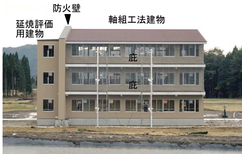
写真 3.2.8-1 準備実験の実験建物 北側立面
