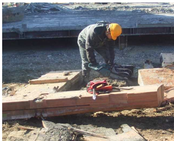
写真 3.7.7-4 解体部材からの断面サンプル採取
