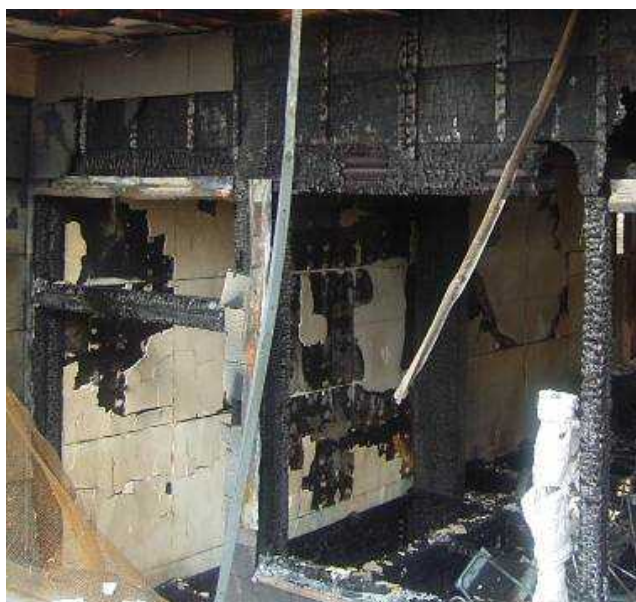
写真 3.7.7-16 2階階段室側耐力壁の様子
