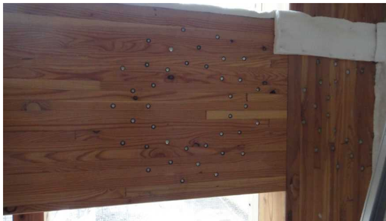
写真 3.7.7-30 ドリフトピンの施工状況
