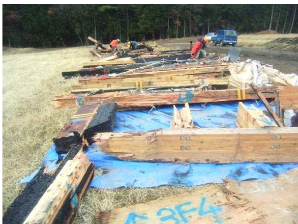
写真 3.7.7-3 解体部材のナンバリング
