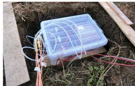
機器を収納して地中に埋設した
