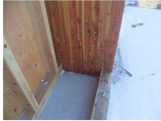
写真 3.7.7-28 柱脚接合部の状況
