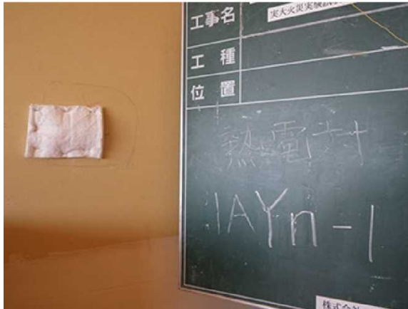
写真 3.5.3-3 壁表面熱電対の状況
