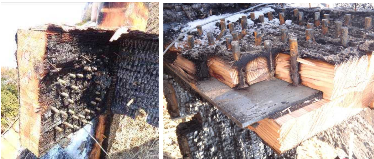
写真 3.7.7-31 1 階接合部の状況例
