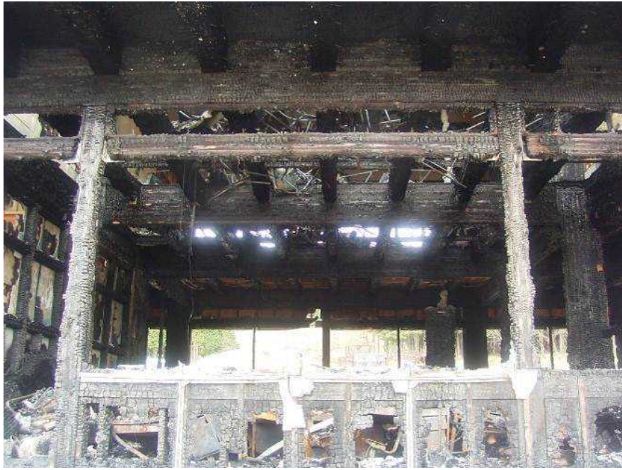
写真 3.7.7-8 1階 B・Cブロック（職員室南側）内部の状況
