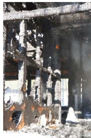
写真 3.7.7-11 1階中央耐力壁の様子
