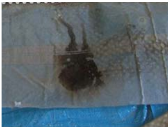
写真 3.4-2 透水マット水抜き穴位置のフィルター状況 (試験体 1, 透水マット(A))
