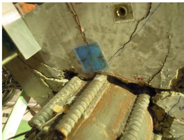
写真 5.4.8 杭頭部 最終写真 B-1
