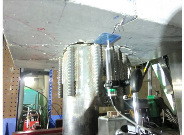
写真 5.4.4 杭頭部 最終写真 A-2
