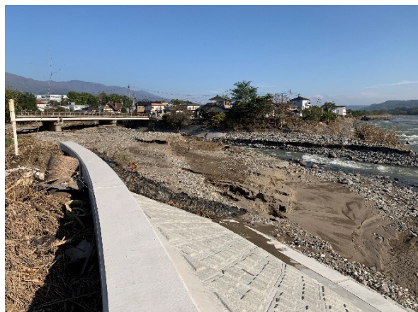
写真-5.2.13.21 千曲川右岸 107.0KP 神川合流点河道内堆砂状況
