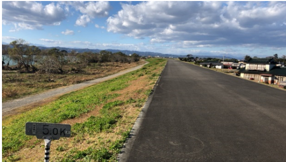
写真-5.2.18.1 阿武隈川下流左岸 5.0KP 天端から川表の状況
