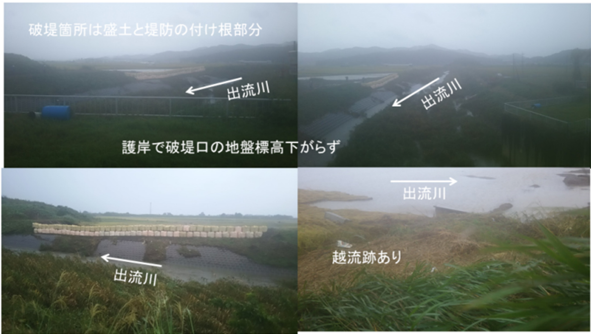
写真-5. 2. 8. 1 ①出流川右岸水門上被災状況
