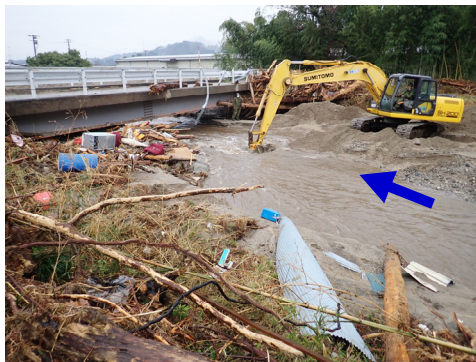
写真-5. 2. 10. 18 河道内の浚渫の様子
