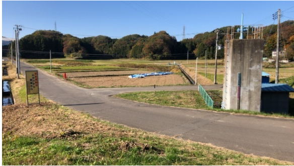
写真-5.2.18.15 阿武隈川下流左岸 18.0KP 釜段設置状況（堤防上から堤内地を望む）
