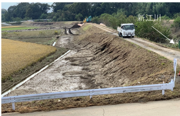
写真-5.2.3.17 市野川合流点から上流を撮影
