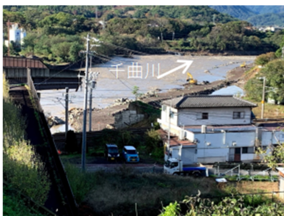
写真-5.2.9.1 決壊箇所を河岸段丘上から被災箇所を望む
