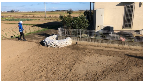
写真-5.2.18.3 阿武隈川下流左岸 5.0KP 釜段その 1
