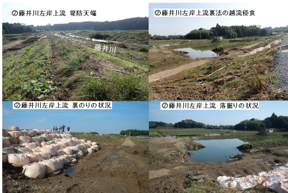
写真-5. 2. 14. 2 藤井川左岸上流の現地状況
