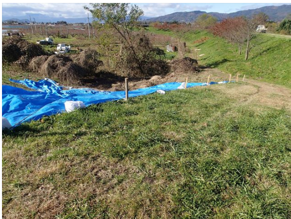
写真-5.2.18.34 阿武隈川上流左岸 10.7KP 合流点裏法尻の全景
