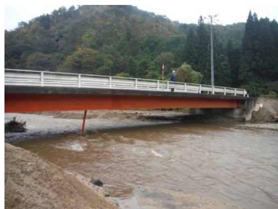
写真-5.2.10.15 岩下橋の桁下
