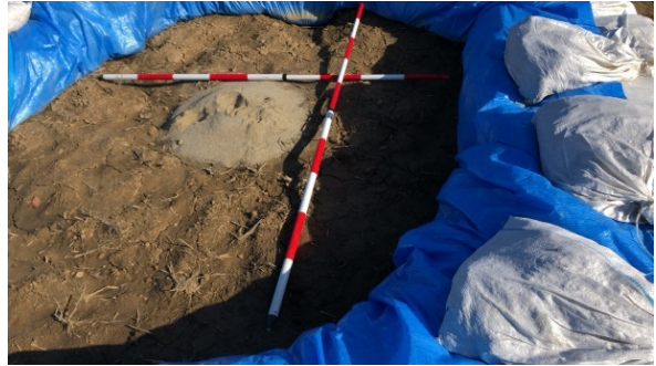
写真-5.2.18.16 阿武隈川下流左岸 18.0KP 釜段内部の噴砂その1
