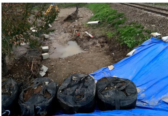
写真-5.2.9.9 応急復旧した堤防上から 堤内地を望む
