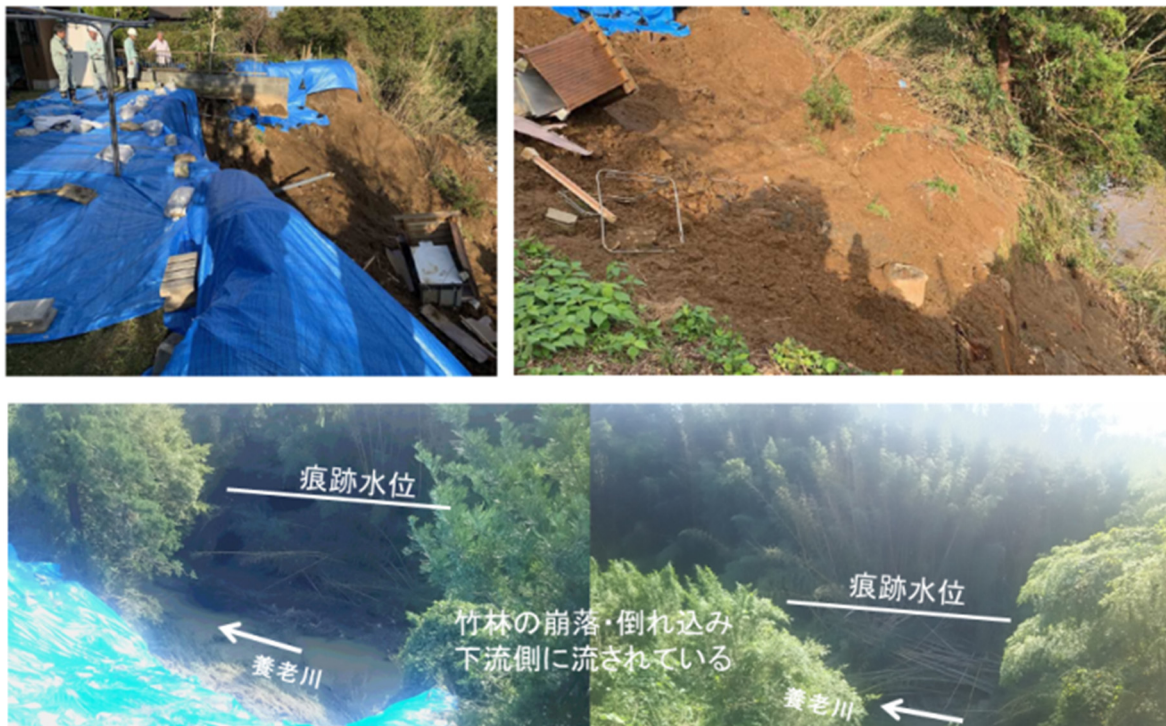
写真-5.2.15.4 養老川左岸駒込被災状況（上左右写真は千葉県提供）
