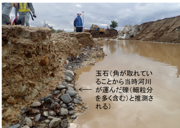
写真-5.2.1.2 堤防表法尻(礫層の状況)
