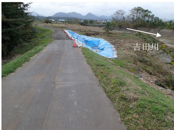
写真-5.2.5.17 吉田川右岸 31.0KP 付近 応急措置の状況
