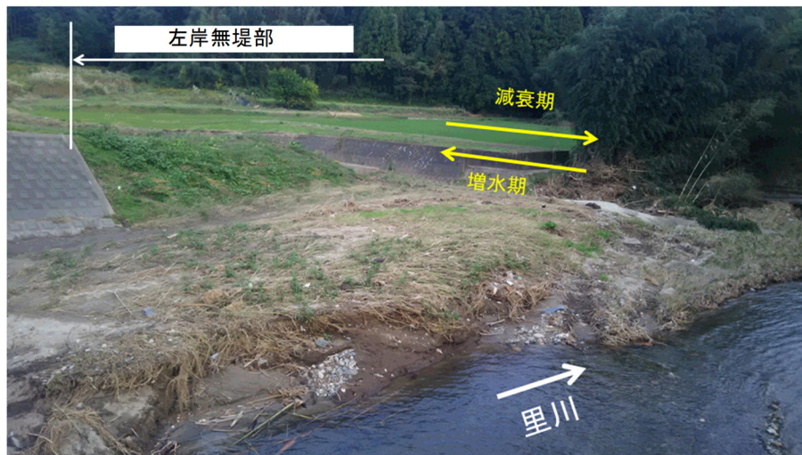
写真-5.2.6.12 左岸無堤部状況
