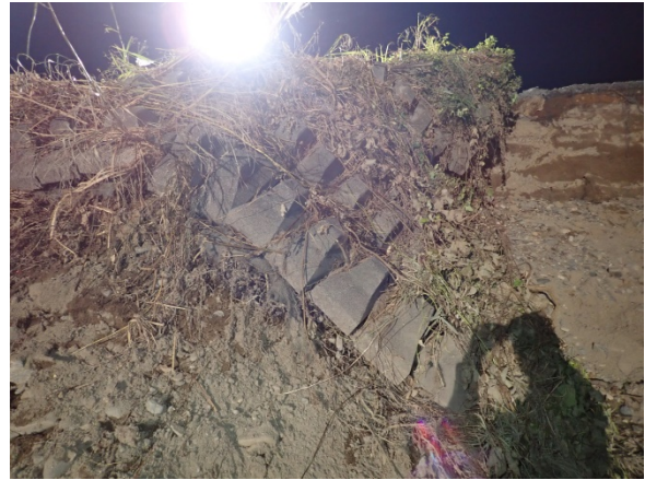
写真-5.2.4.26 裏法の連節ブロック
