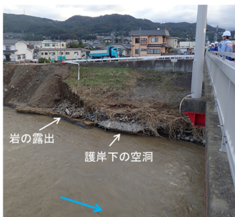
写真-5.2.1.16 上田橋左岸護岸
