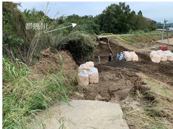
写真-5.2.3.15 決壊箇所応急復旧の状況
