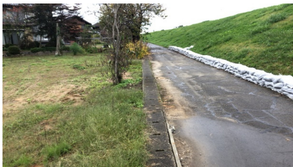
写真-5.2.11.1 信濃川左岸 12.6KP
