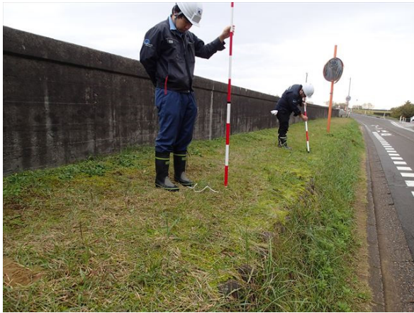
写真-5.2.11.3 信濃川右岸 15.3KP 特殊堤管理道
