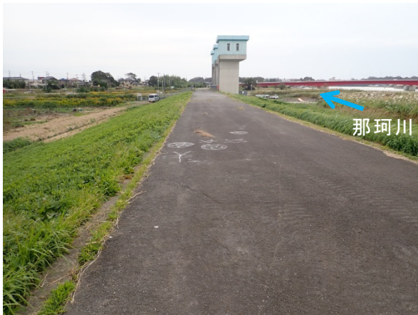
写真-5.2.7.1 フロンティア堤防天端部 那珂川左岸 2.1KP 上流から
