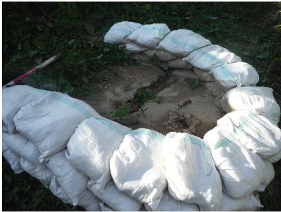
写真-5.2.17.12 阿武隈川下流右岸 32.4KP (法尻の漏水・噴砂)
