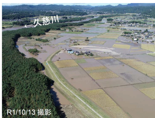
決壊後の状況
