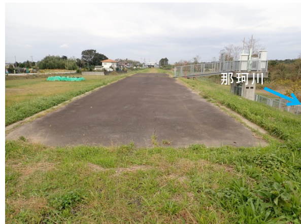
写真-5.2.7.2 フロンティア堤防天端部 那珂川右岸 4.1KP 下流から
