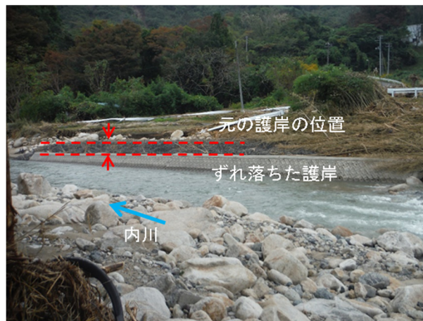
写真-5.2.10.5 馬越道大橋下流の護岸
