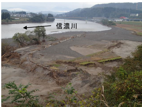
写真-5.2.11.7 信濃川左岸 35.0KP 護岸崩壊、土砂堆積
