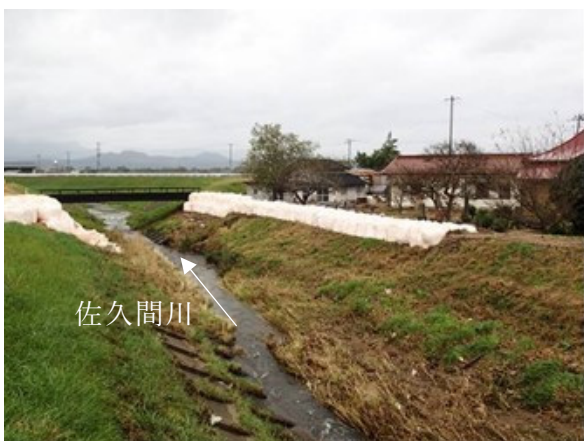
写真-5.2.5.29 佐久間川 決壊箇所
