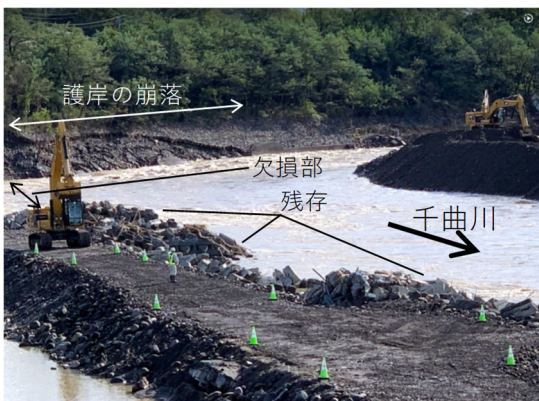
写真-5.2.9.5 仮設道路上流部分
