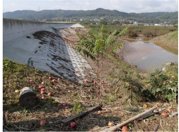
写真-5.2.13.6 千曲川右岸 49.0KP パラペット区間の川表の状況
