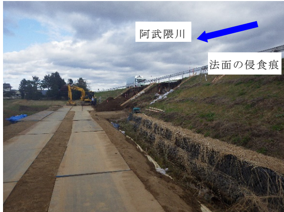
写真-5.2.17.4 阿武隈川下流左岸17.2KP (上流側のドレーン)
