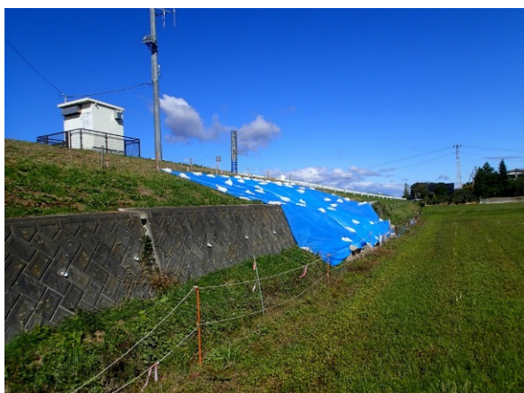
写真-5.2.5.1 新江合川左岸 4.6KP 応急復旧状況(下流から)
