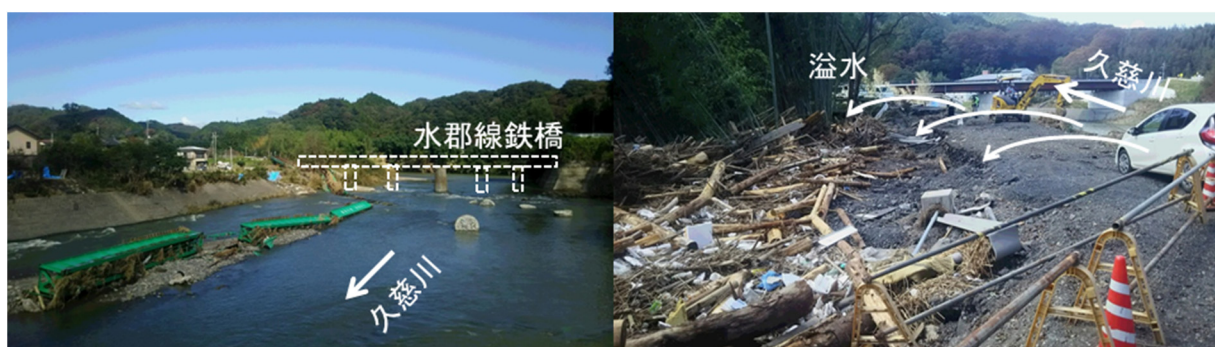
写真-5.2.6.1 南田気橋上流水郡線鉄橋の流失（左）と南田気橋下流左岸の溢水状況（右）
