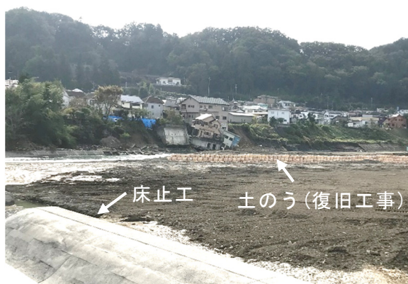
写真-5.2.16.1 秋川秋留橋下流左岸から
