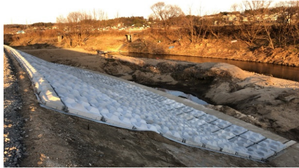
写真-5.2.19.10 谷田川左岸 川表復旧状況
