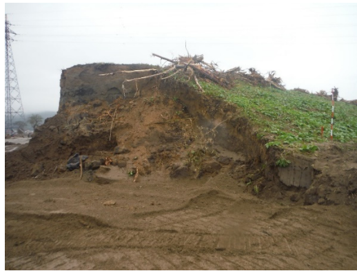
写真-5. 2. 10. 29 堤防の断面
