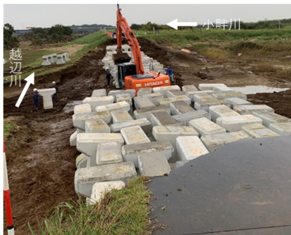
写真-5.2.3.3 応急復旧の様子
