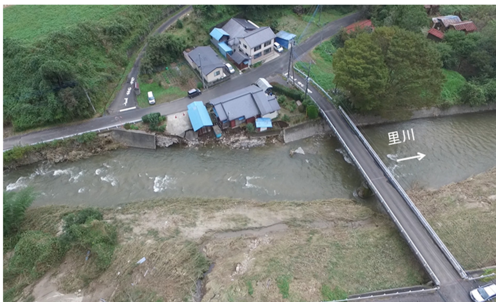
写真-5.2.6.5 被災状況（応急復旧前）（茨城県提供）
