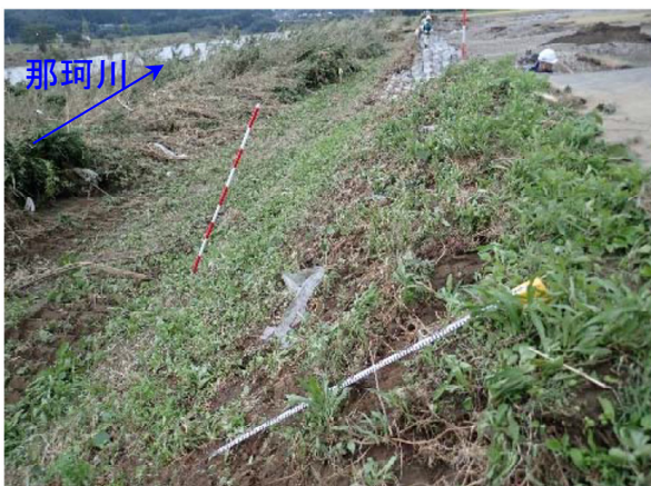
写真-5.2.4.14 那珂川右岸 41.2KP 決壊箇所堤防表法面の状況 上流(左) 下流(右) (関東地方整備局 13) )
