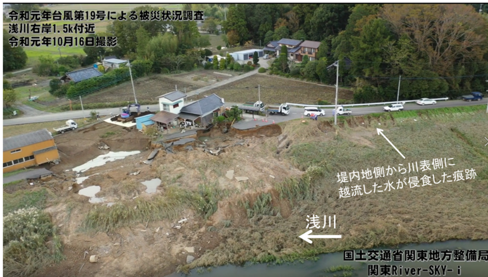
写真-5.2.6.10 浅川右岸 1.5KP 被災状況（関東地方整備局 17) ）
