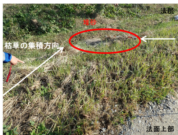
写真-5.2.13.13 千曲川右岸 56.5KP 越流水の流れと堆砂川裏法の関係
