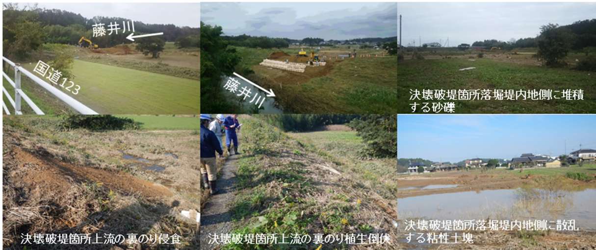
写真-5.2.14.1 藤井川左岸下流被災状況
