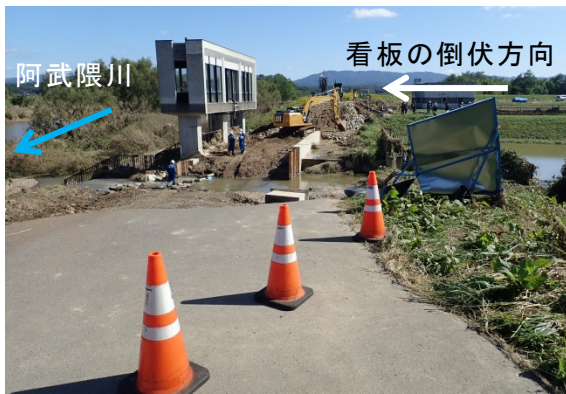
写真-5.2.2.5 堤防天端上の看板の倒伏
