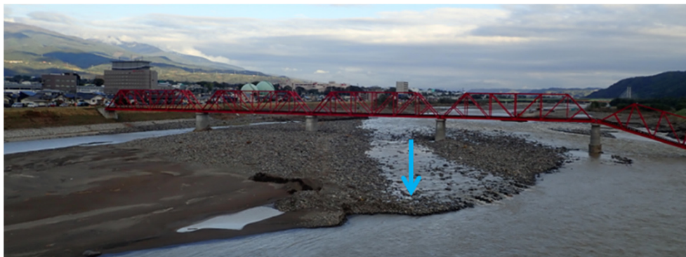
写真-5.2.1.15 上田橋から上流をのぞむ
