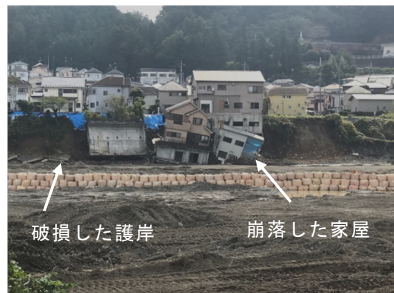
写真-5.2.16.2 秋川秋留橋下流左岸から
