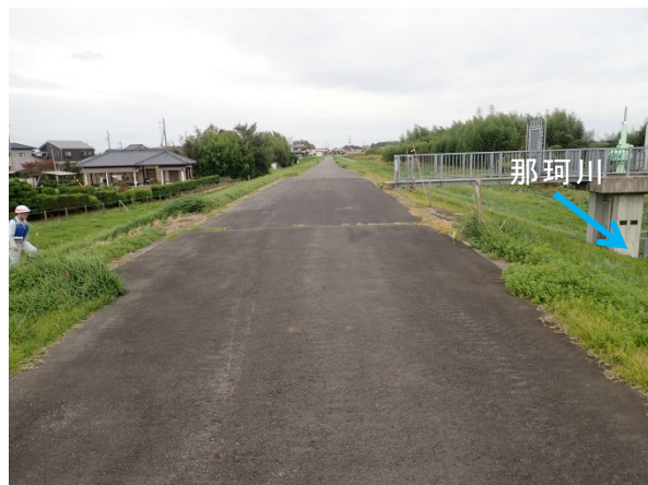
写真-5.2.7.4 フロンティア堤防天端部 那珂川右岸 7.7KP 下流から
