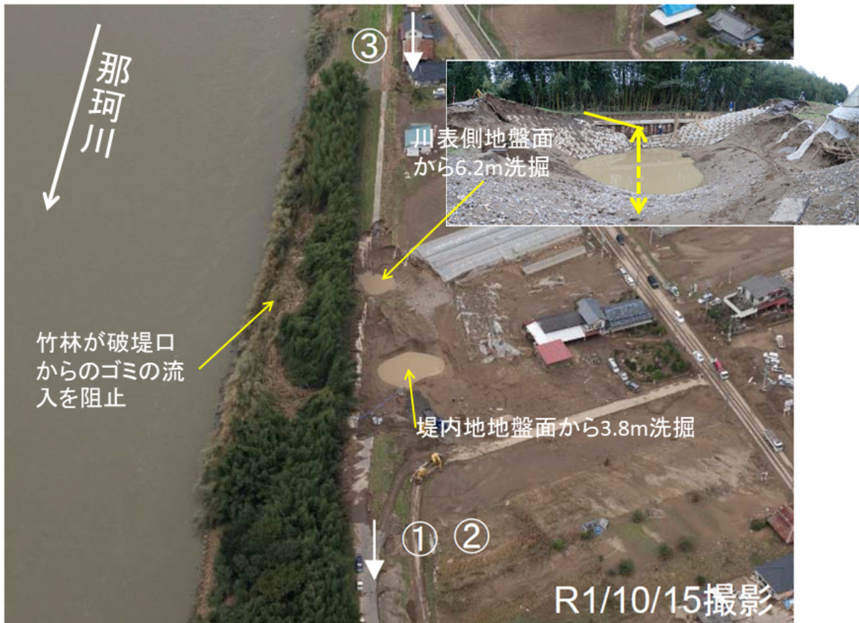
写真-5.2.4.8 那珂川左岸 40.0KP の被災状況（出典：関東地方整備局 13) に加筆）
