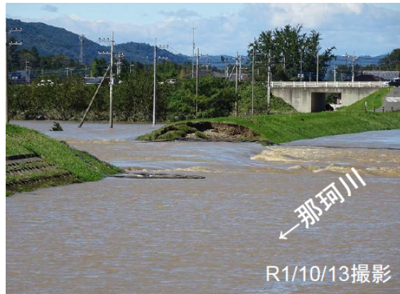
写真-5.2.4.2 決壊後の状況 （関東地方整備局 13) ）
