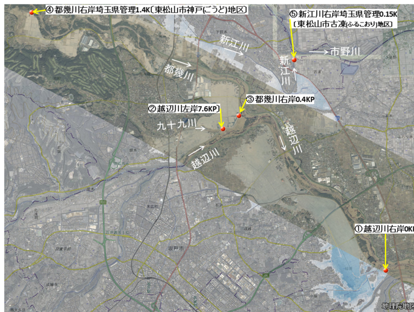
図-5.2.3.2 調査を行った堤防決壊箇所（荒川水系）
