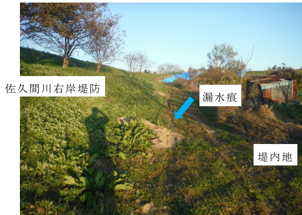
写真-5.2.17.14 阿武隈川上流左岸 10.7KP (佐久間川右岸側)
