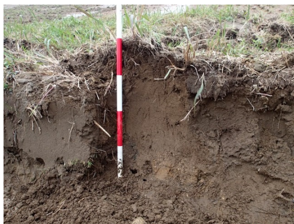
写真-5.2.5.14 鳴瀬川右岸 38.1、38.3KP 崩壊土の開削断面
