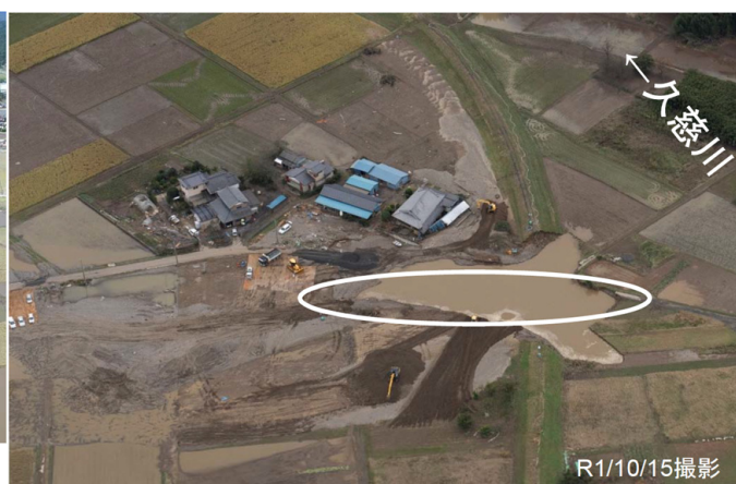
写真-5.2.4.20 特徴的な落堀の形状 (関東地方整備局 12) )
