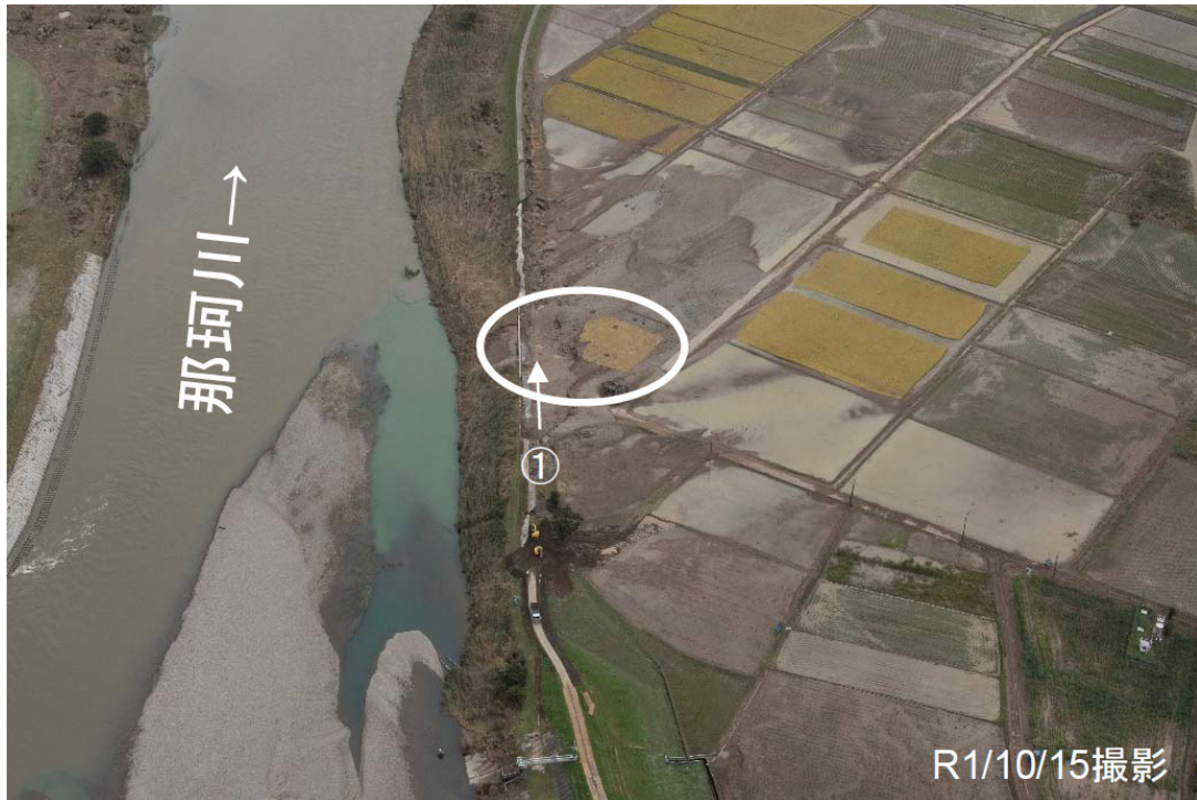
写真-5.2.4.11 那珂川右岸 41.2KP 応急復旧前の斜め写真（関東地方整備局 13) ）
