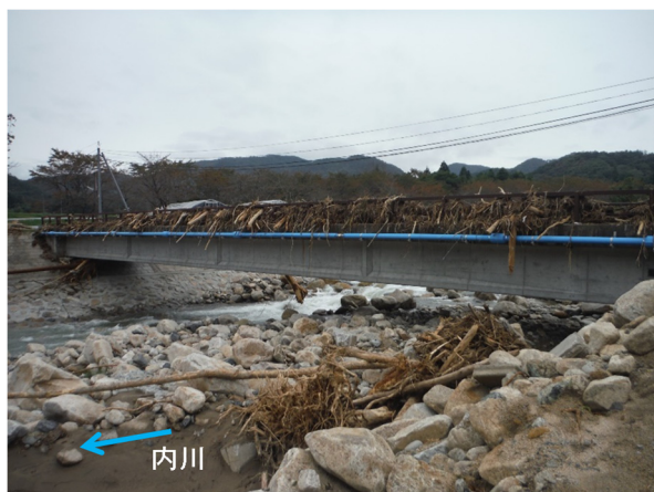
写真-5.2.10.4 馬越道大橋
