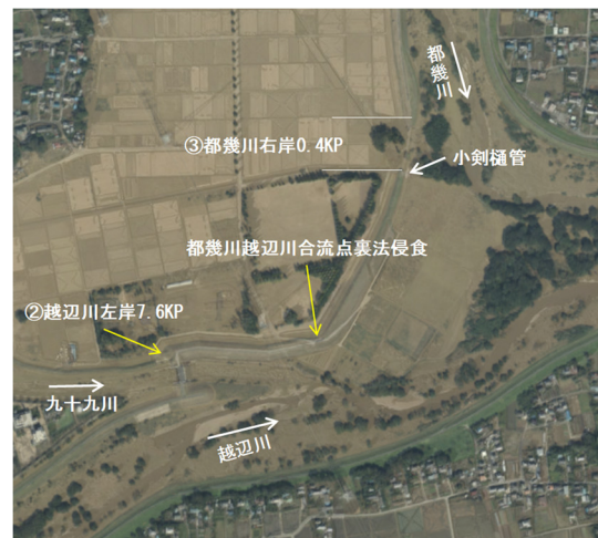
写真-5.2.3.9 越辺川都幾川合流点の裏法侵食 (背景地図出典：国土地理院電子国土 Web)
