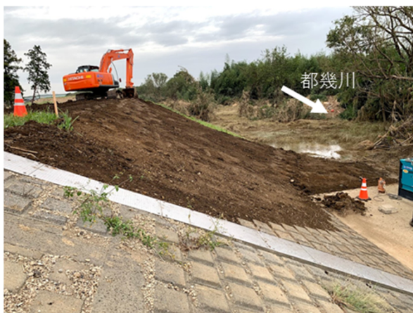
写真-5.2.3.12 残存する樋管周囲の護岸
