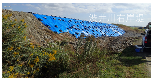
写真-5.2.12.1 渋井川 a 地点右岸堤防決壊箇所 の応急復旧状況
