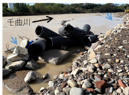
写真-5.2.9.6 仮設道路下流部分
