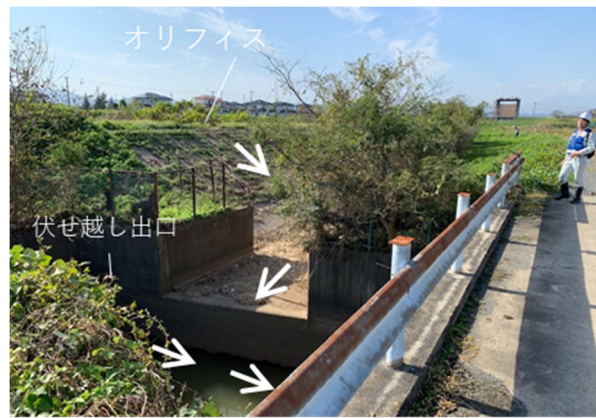
写真-5.2.12.24 決壊箇所より約 200m 上流 右岸堤にあるオリフィス
