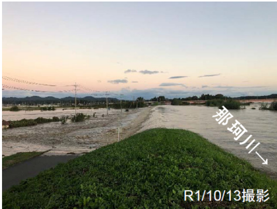
写真-5.2.4.1 越流状況 （関東地方整備局 13) ）
