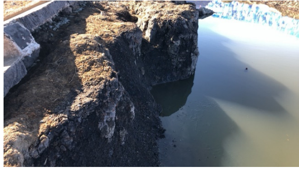
写真-5.2.19.4 高倉川左岸 護岸の基礎地盤
