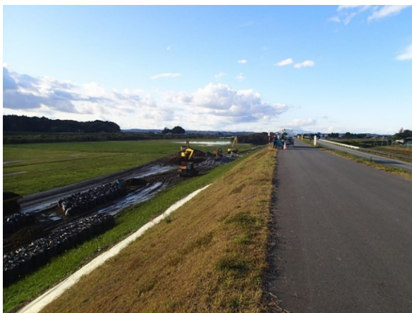
写真-5.2.5.9 鳴瀬川左岸 8.4～8.8KP 上流端
