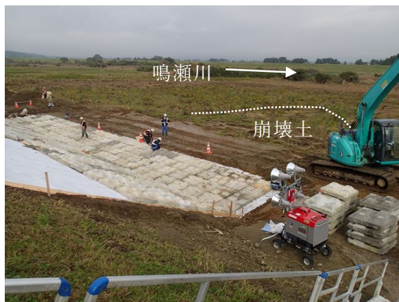
写真-5.2.5.12 鳴瀬川右岸 38.1、38.3KP 崩壊箇所の復旧工事状況
