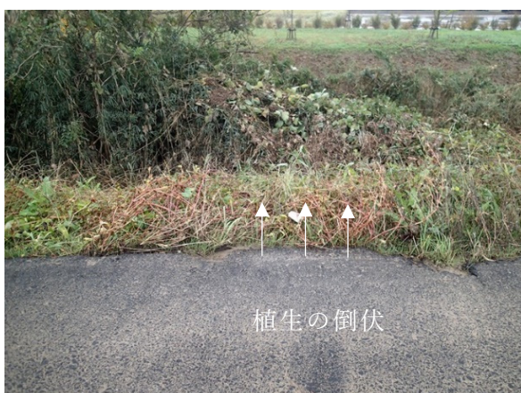
写真-5.2.5.26 滝川 直上流
