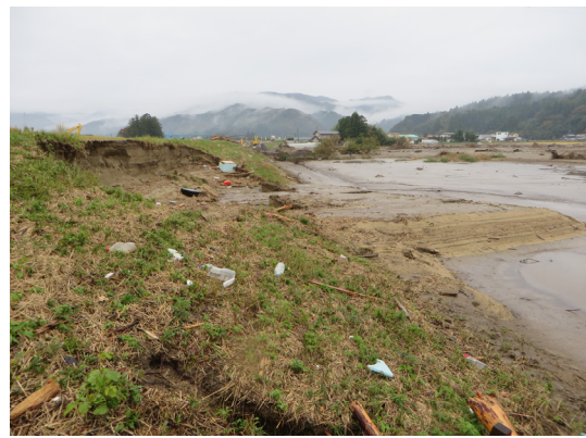
写真-5. 2. 10. 28 法尻の砂の堆積
