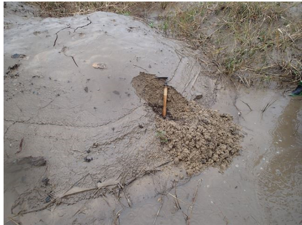
写真-5.2.5.36 谷田川土の盛り上がり
