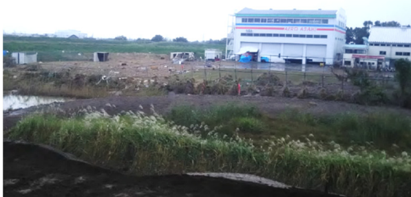
写真-5.2.3.2 決壊箇所堤内地側の状況
