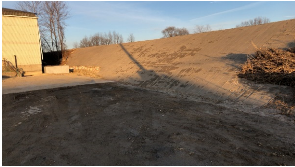
写真-5.2.19.9 谷田川左岸川裏復旧状況
