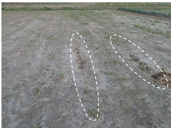
写真-5.2.18.22 阿武隈川下流右岸 30.0KP 堤内地水田面の列状窪み
