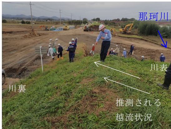
写真-5.2.4.3 決壊箇所下流部状況
