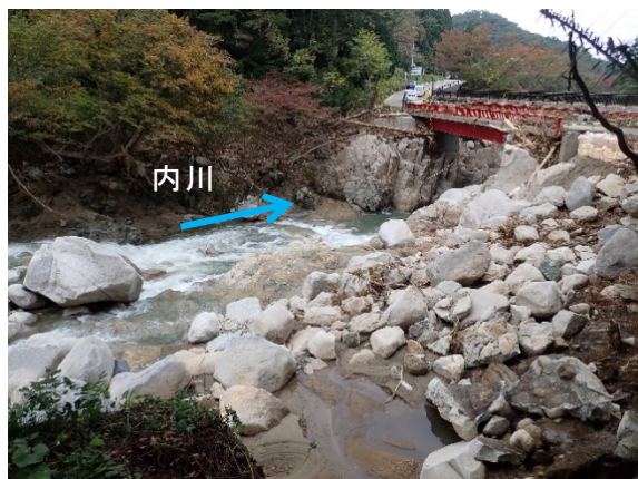
写真-5.2.10.1 細流橋の上流側
