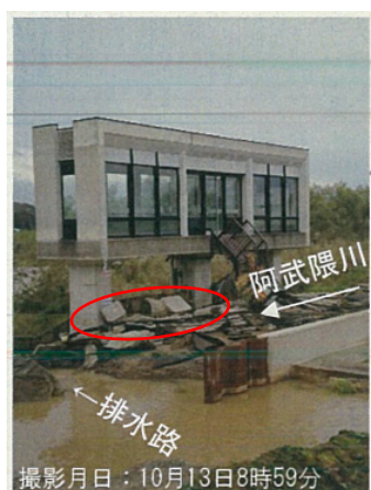
写真-5.2.2.1 護岸ブロック （出典：東北地方整備局 4) ）
