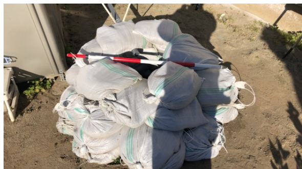
写真-5.2.18.4 阿武隈川下流左岸 5.0KP 釜段その 2
