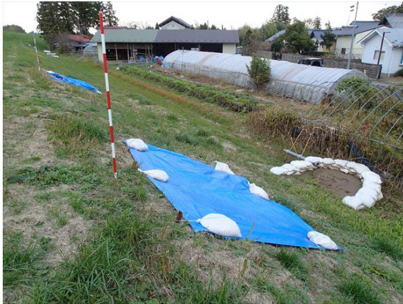
写真-5. 2. 18. 24 阿武隈川下流右岸 32. 4KP 被災箇所全景
