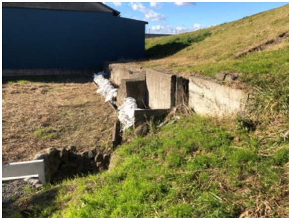
写真-5.2.18.40 荒川右岸 0.2KP 川裏腰留め擁壁
