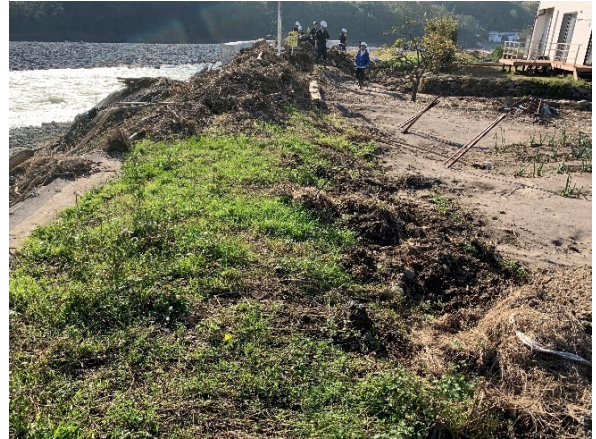
写真-5.2.13.23 千曲川右岸 107.0KP 神川合流点越流痕跡
