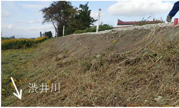
写真-5.2.12.7 渋井川 c 地点左岸の堤外地から堤防欠損復旧状況を望む
