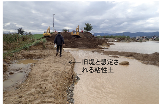
写真-5.2.1.3 堤防表法尻(基盤粘性土の状況)
