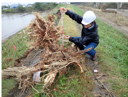
写真-5. 2. 10. 26 決壊箇所付近の痕跡水位
