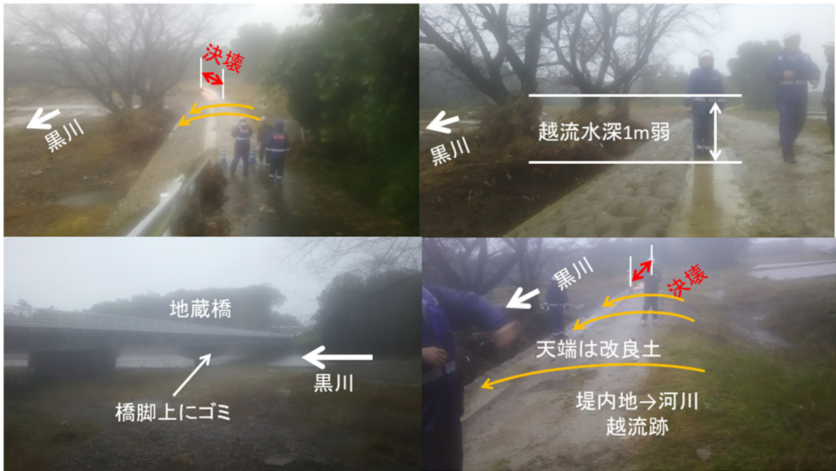
写真-5.2.8.8(1) 黒川左岸地藏橋上流被災状況
