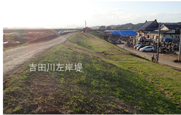
写真-5.2.12.14 下流側から決壊箇所を望む
