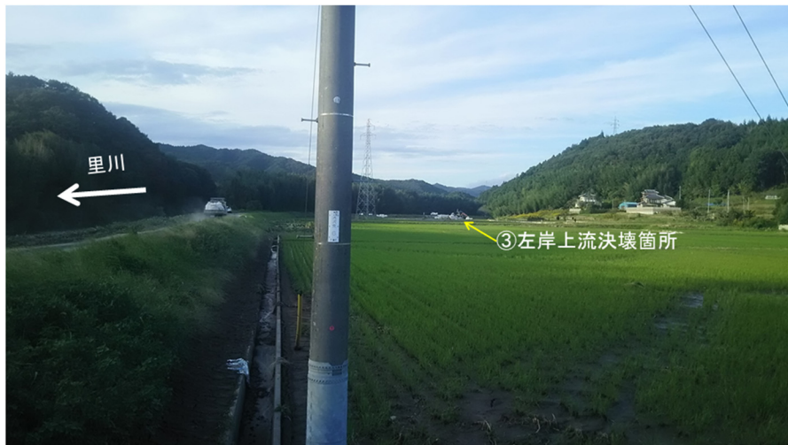
写真-5.2.6.11 ③左岸上流決壊箇所 下流より遠望
