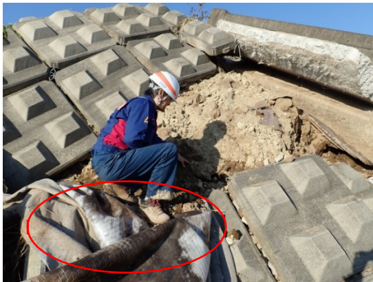
写真-5. 2. 2. 8 護岸と遮水シート
