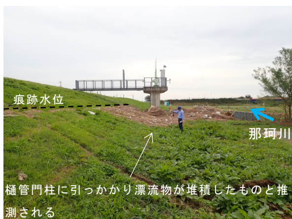
写真-5.2.7.6 樋管門柱の漂流物堆積状況 那珂川左岸 8.2KP 上流から
