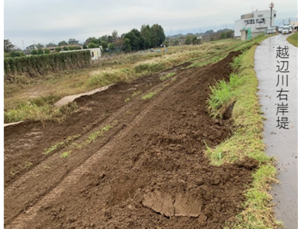
写真-5.2.3.1 決壊箇所上流の裏法侵食
