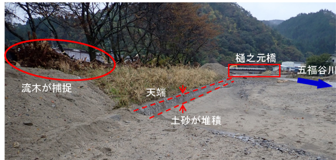
写真-5. 2. 10. 19 樋之元橋下流
