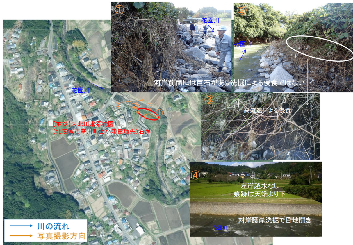
写真-5.2.6.3 被災箇所周辺の状況（背景地図出典：国土地理院電子国土 Web）
