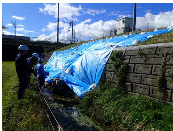
写真-5.2.5.2 新江合川左岸 4.6KP 応急復旧状況(上流から)
