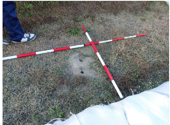
写真-5.2.18.14 阿武隈川下流右岸 13.3KP 月の輪内部の噴砂
