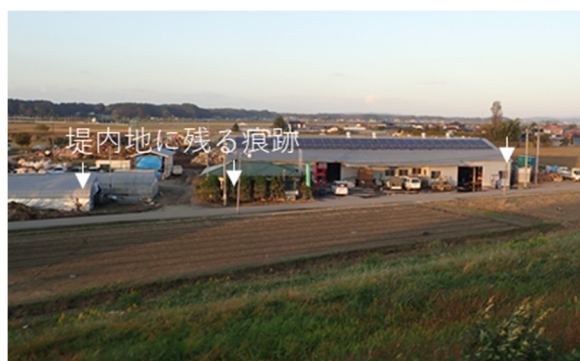
写真-5.2.12.16 堤防欠損箇所天端から堤内地側を望む
