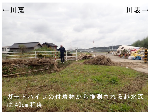
写真-5.2.7.21 越水深確認状況 那珂川左岸 19.8KP 上流から
