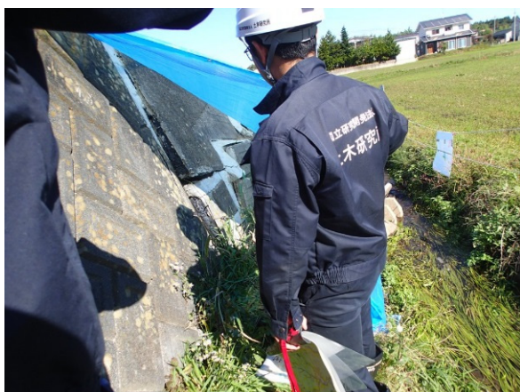
写真-5.2.5.3 新江合川左岸 4.6KP 応急復旧状況(下流から)
