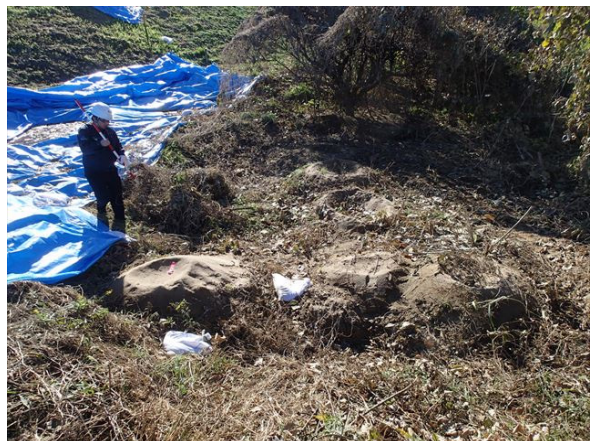
写真-5.2.18.35 阿武隈川上流左岸 10.7KP 合流点直近の噴砂
