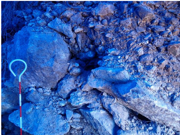
写真-5.2.19.5 高倉川左岸堤体土質
