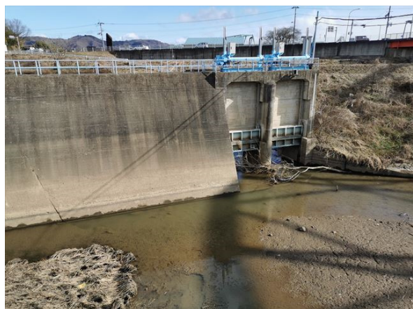
写真-5.2.19.2 高倉川に設置された水門
