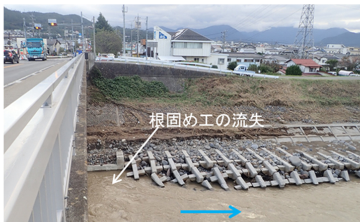
写真-5.2.1.17 上田橋左岸根固め
