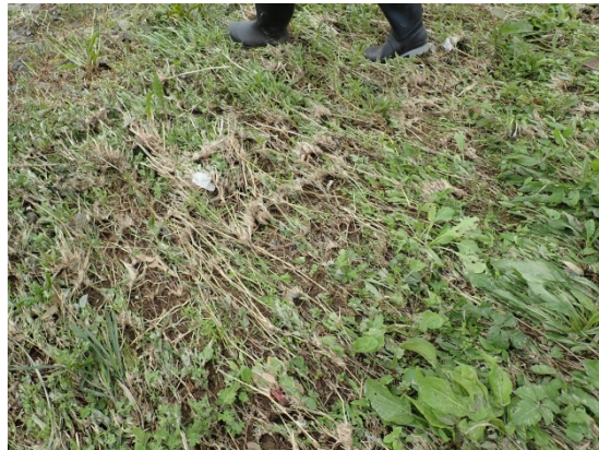
写真-5.2.4.9 決壊箇所近傍の裏法侵食状況 写真-5.2.4.10 堤防川裏法面の植生倒伏
