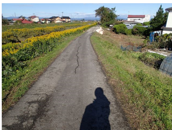
写真-5.2.5.22 渋井川右岸堤 天端高さ
