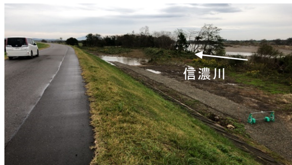
写真-5.2.11.2 信濃川左岸 12.6KP
