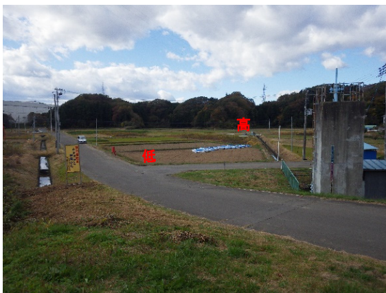
写真-5.2.17.8 阿武隈川下流左岸 18.0KP (漏水箇所全景)
