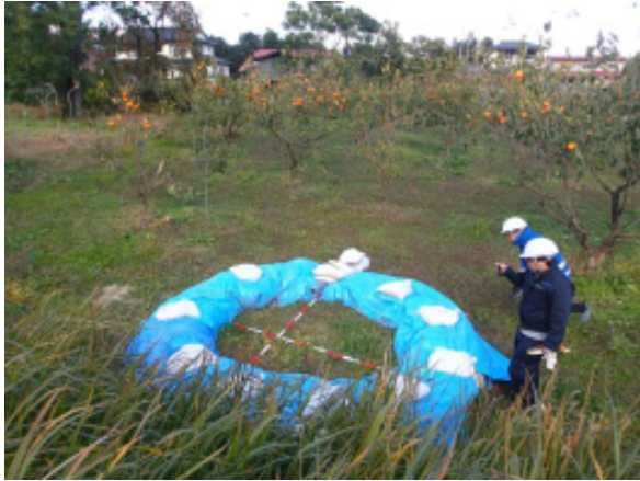
写真-5.2.18.32 阿武隈川下流左岸 37.0KP 釜段
