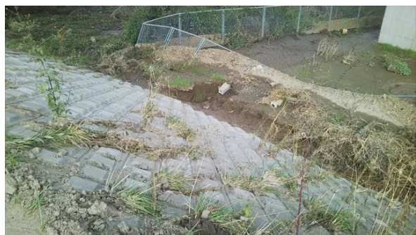
写真-5.2.13.15 千曲川左岸 79.0KP 条件護岸の状況
