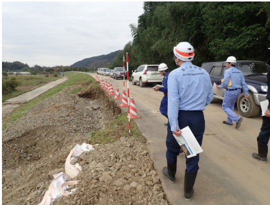
写真-5.2.4.9 決壊箇所近傍の裏法侵食状況 写真-5.2.4.10 堤防川裏法面の植生倒伏
