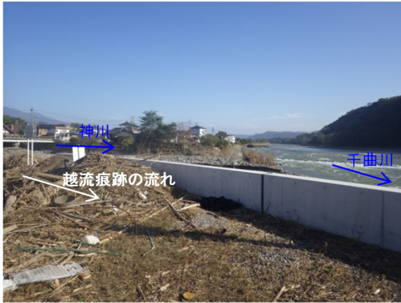
写真-5.2.13.22 千曲川右岸 107.0KP 神川合流点越流痕跡
