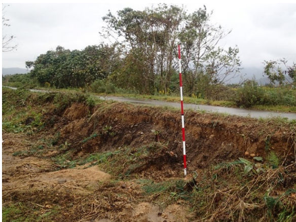
写真-5.2.5.27 滝川 約 100m 上流越流痕跡
