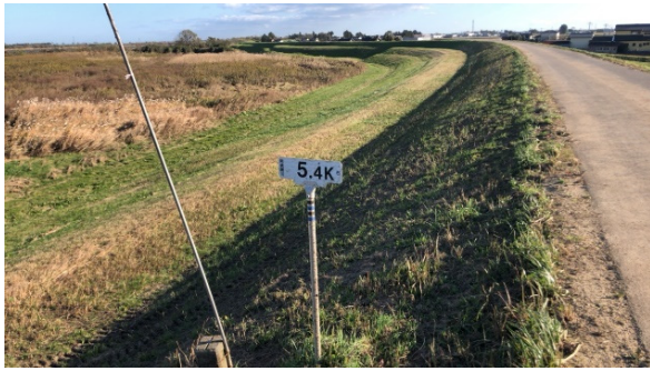
写真-5.2.18.5 阿武隈川下流右岸 5.4KP 天端から川表の状況
