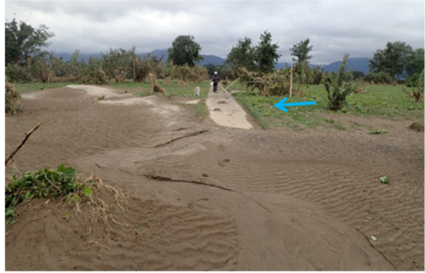
写真-5.2.1.7 決壊地点前面高水敷
