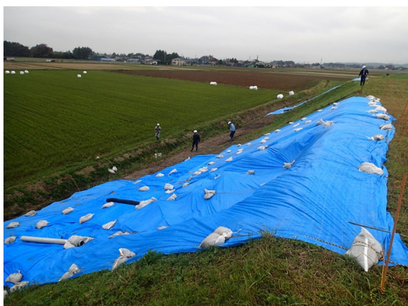
写真-5.2.5.11 鳴瀬川左岸 40.7KP 上流端
