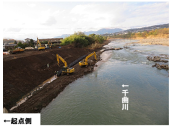
(右) 下流左岸側 (復旧工事中)
