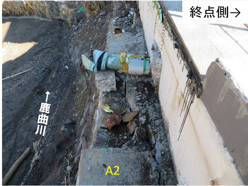
写真-7.2.54 A2 橋台橋座部
