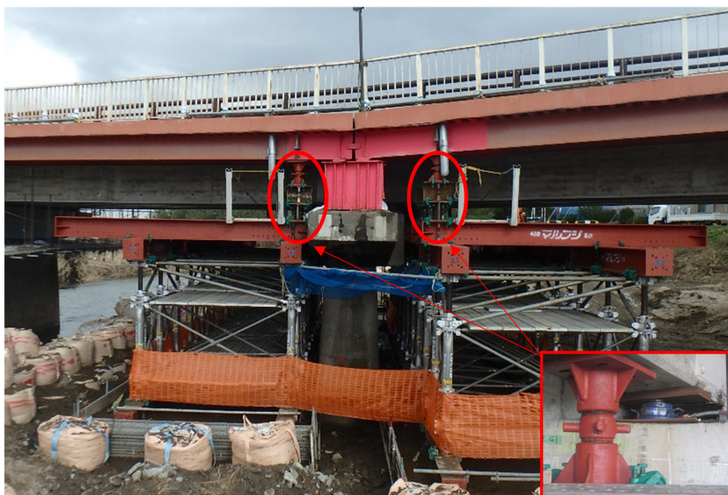
写真-7.2.11 ベントによる桁の仮受け状況
