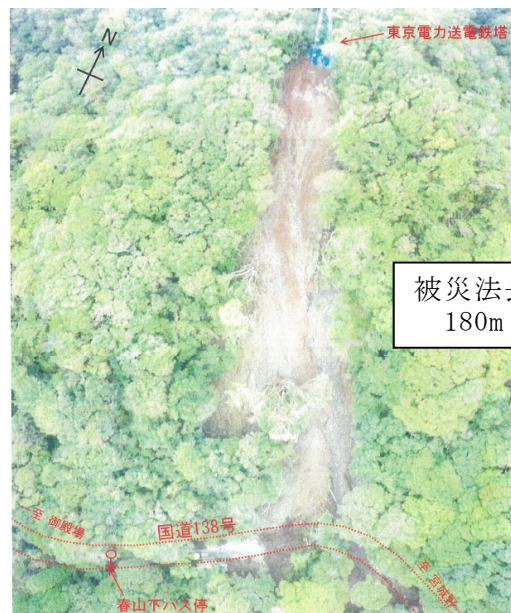
写真-7.3.2 国道138号（神奈川県提供 写真）10月16日撮影
