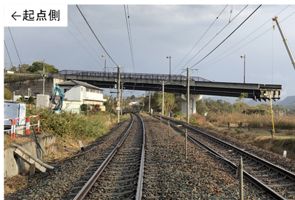
写真-7.2.35 海野宿橋全景
