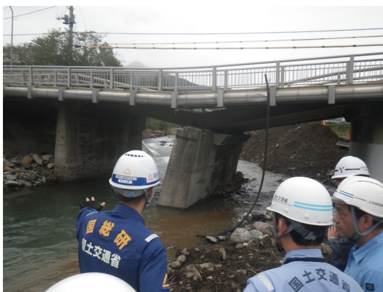
写真-7.1.1 調査状況
