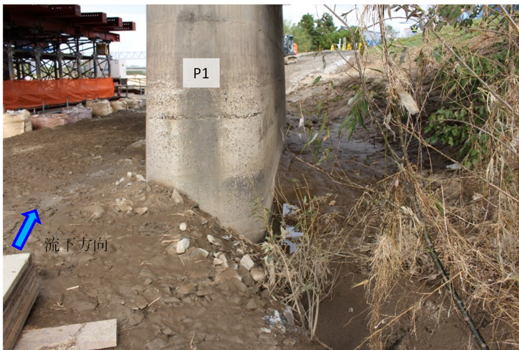
写真-7.2.13 P1 橋脚の状態 (10月30日)
