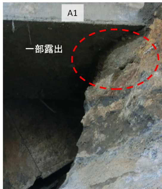
写真-7.2.20 深礎杭の露出状況（その2）（11月2日）
