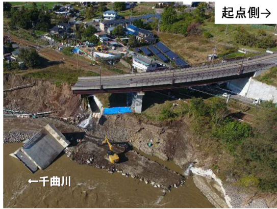
写真-7.2.36 被災直後の周辺状況
