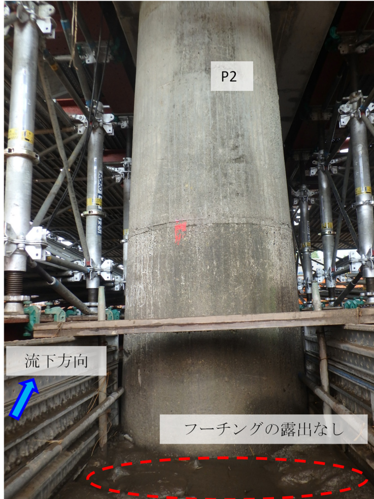
写真-7.2.12 P2 橋脚の状態 (10月30日)
