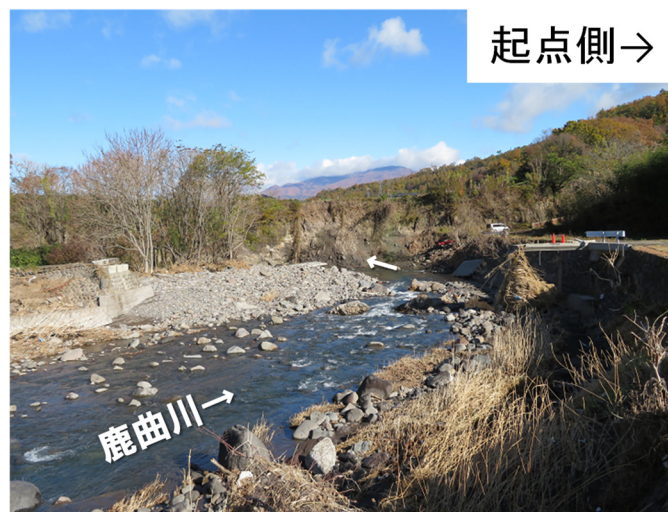
写真-7.2.48 鹿曲川の湾曲と堤防の洗掘
