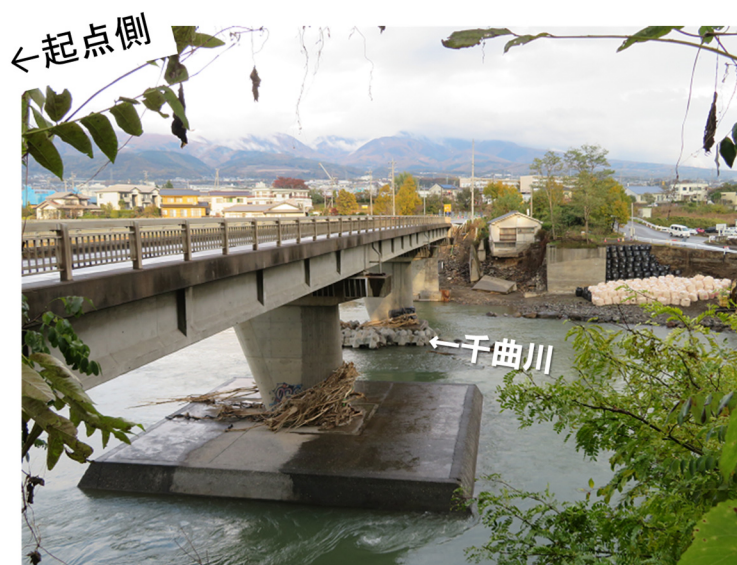
写真-7.2.23 田中橋全景（左岸側から右岸側を望む）
