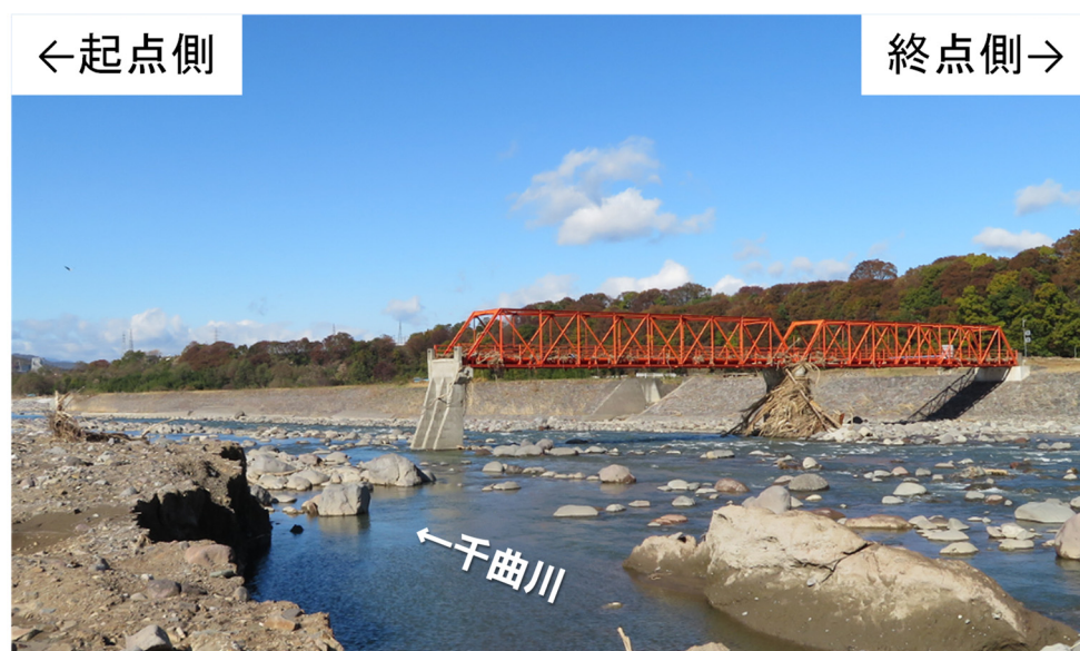
写真-7.2.42 布下橋全景
