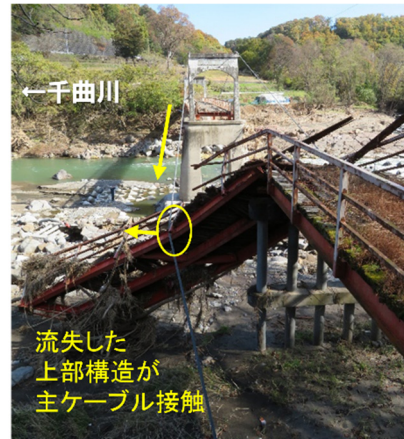
(右) 側径間上部構造とケーブルの接触
