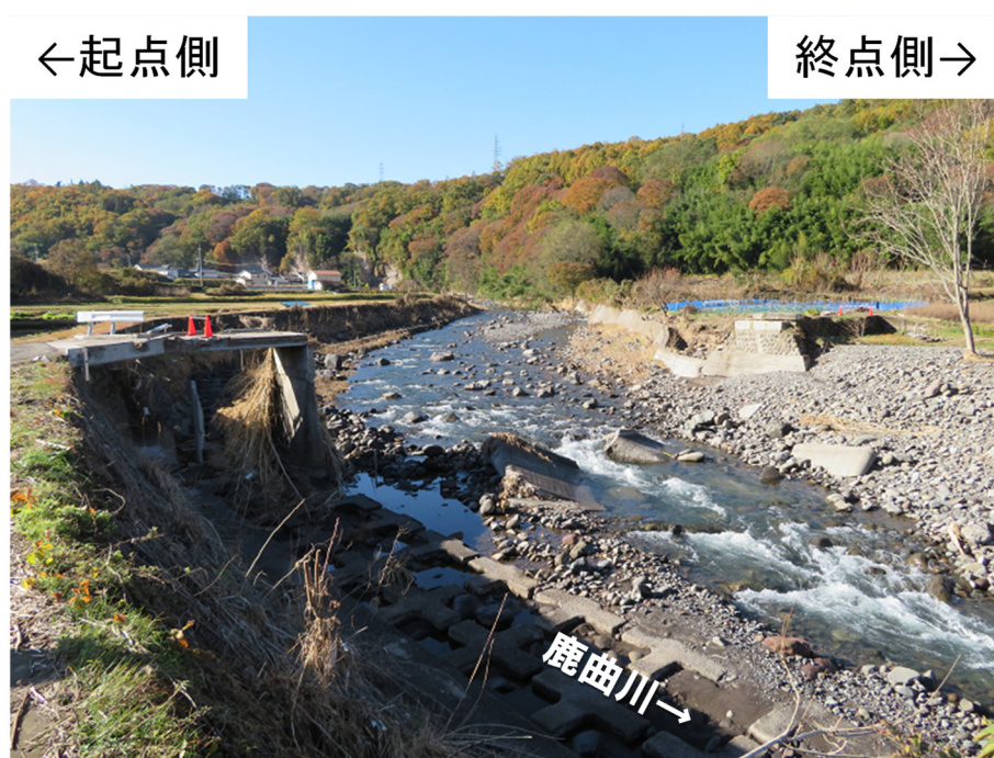
写真-7.2.45 本下之城橋全景
