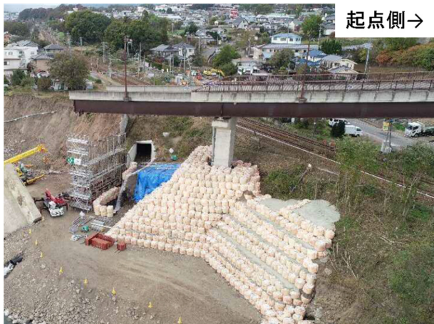
写真-7.2.40 P1橋脚基礎側面の法面保護工
