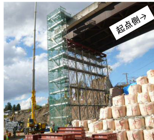
写真-7.2.41 桁を支持するためのベント
