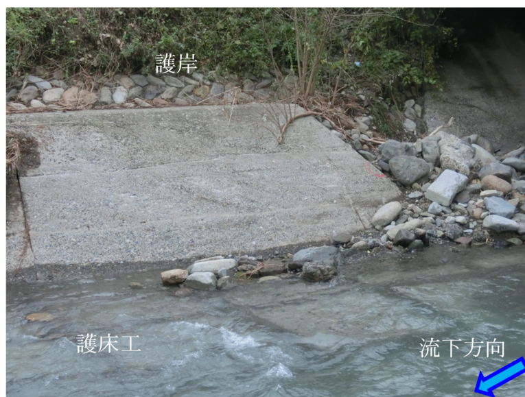
写真-7.2.5 下流側右岸の護岸の状況（10月21日）
