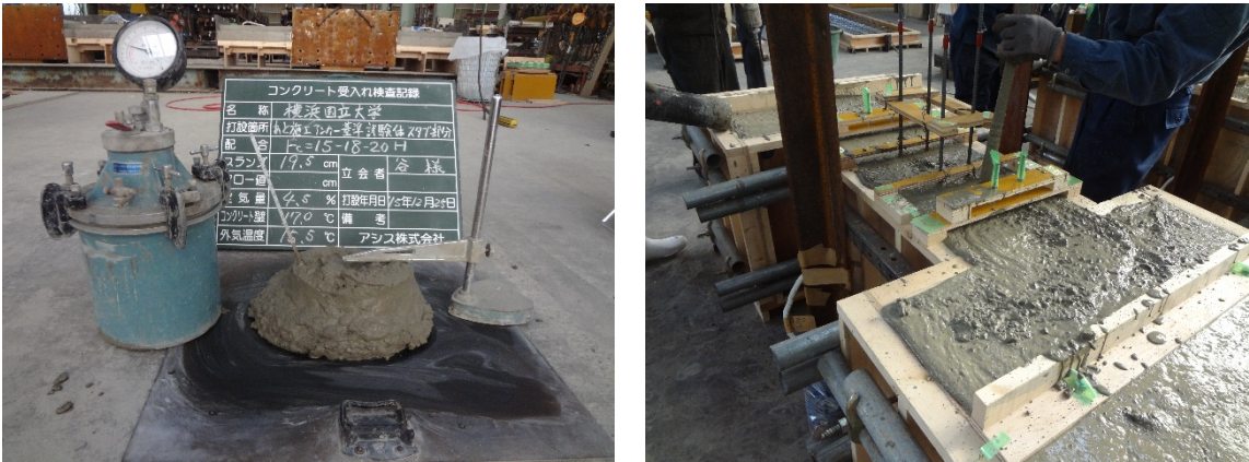
(a) スタブコンクリート打設状況
