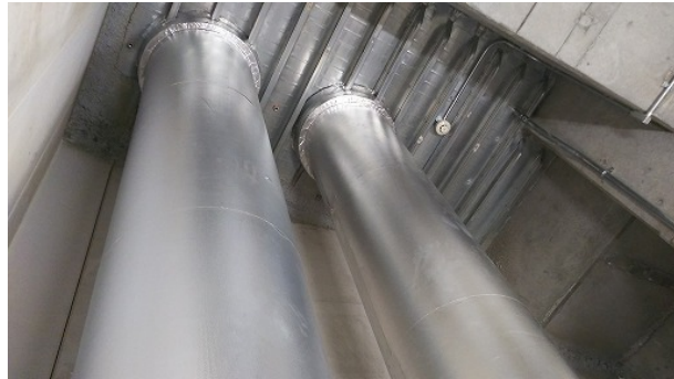
図 3.74 地域導管敷設状況 (Bプラント)
