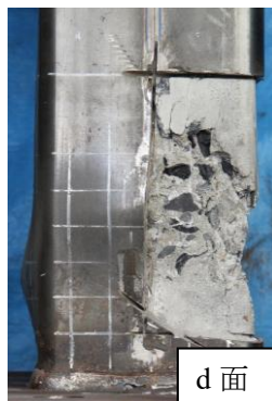
(k) d 面柱脚部 内部コンクリート
