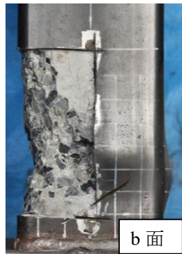
(j) b 面柱脚部 内部コンクリート
