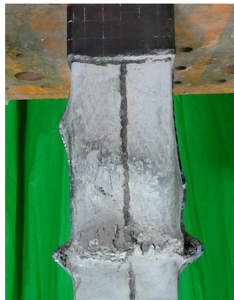
(b)内部コンクリート
