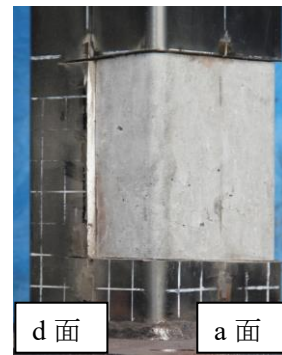
(k) d-a 面柱脚部 内部コンクリート
