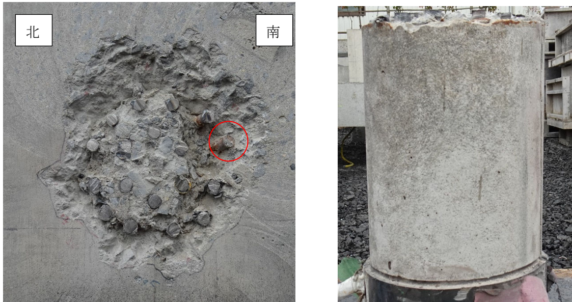
(a) パイルキャップ下面見上げ写真
