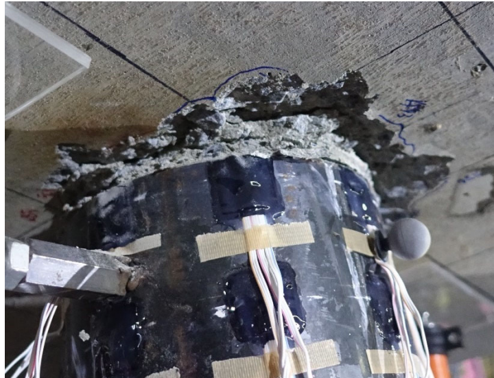
図 5.3.2-1 実験終了時損傷状況写真，北西からの写真
