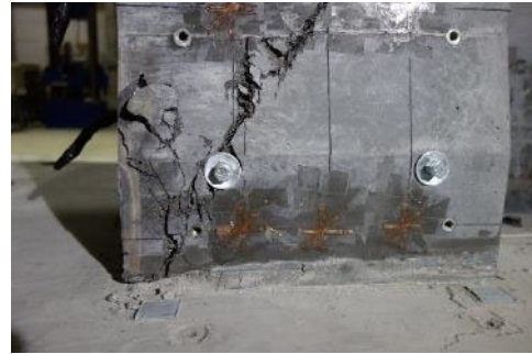
(k) 東面柱脚目地部
