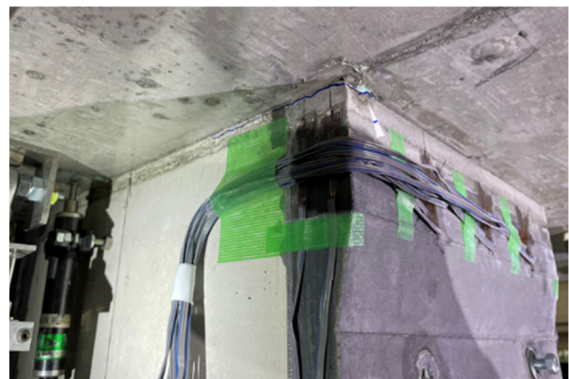
南西面 (柱頭付近)
