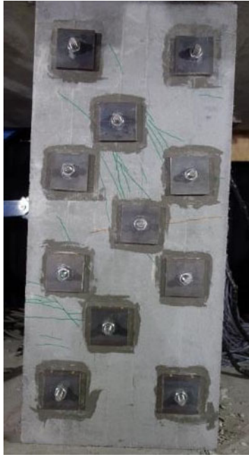
(a) パネル損傷状況
