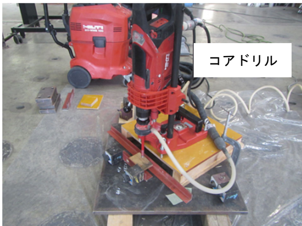
(a) コアドリル設置状況
