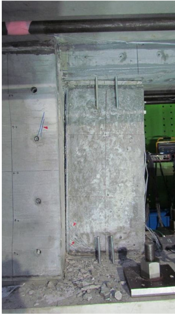
(h) 1C1 柱袖壁最終破壊形状
