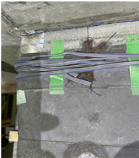
南面 (柱頭付近)
