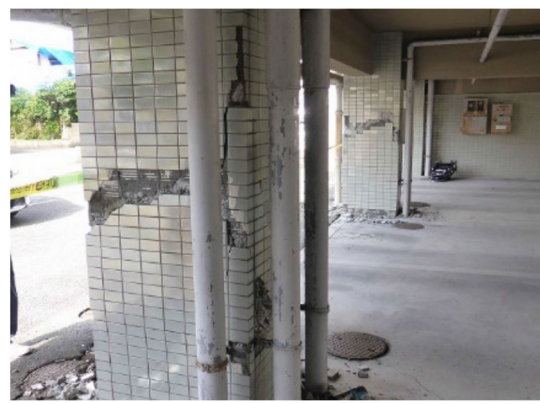
(d) 共同住宅 H (熊本市東区, 1986 年建設)
