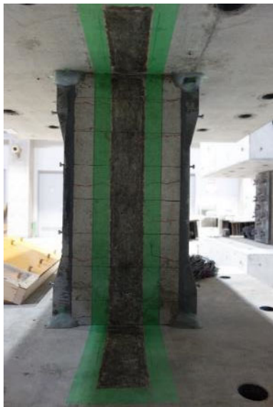
(a) 袖壁増設面の目粗し
