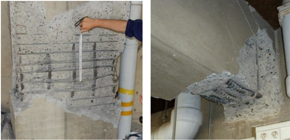
図 1.1.3-3 1階柱主筋, 2階大梁(張間方向)の配筋
