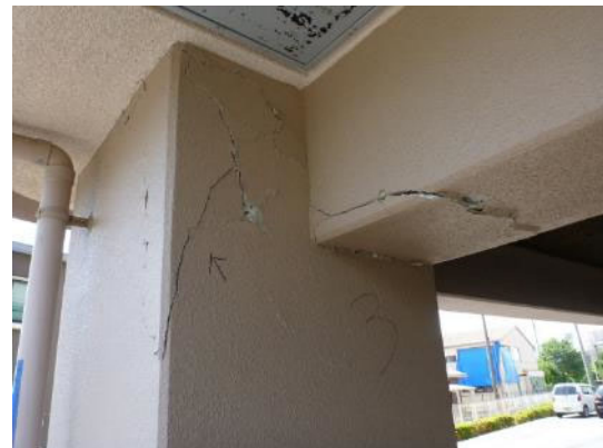
(d) 柱梁接合部 (X1Y1)
