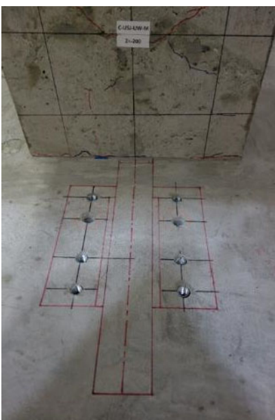
(a) UFC 袖壁位置墨出し
