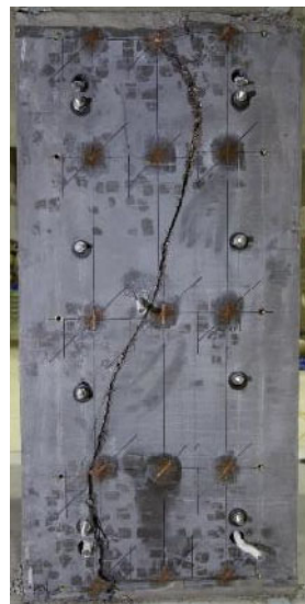
パネル損傷状況
