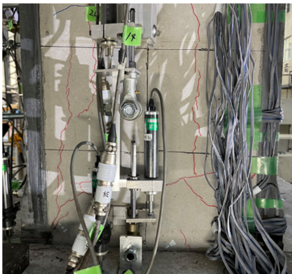
西面 (柱脚付近)
