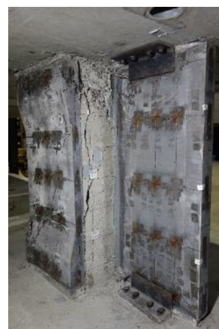
(f) 北面および袖壁東面
