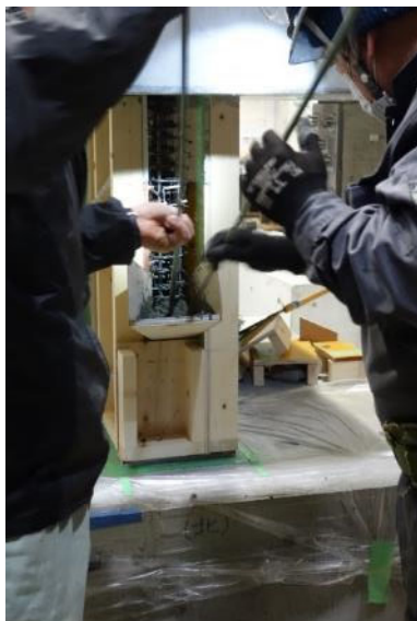
(d) 袖壁コンクリート打設
