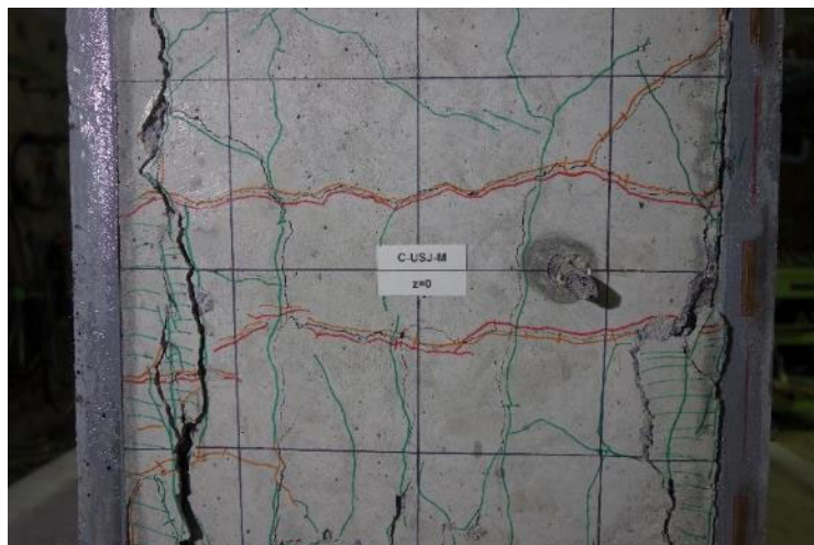
(f) パネル界面縦ひび割れおよび柱側面曲げひび割れ
