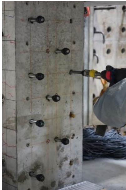
(b) アンカー打ち込み
