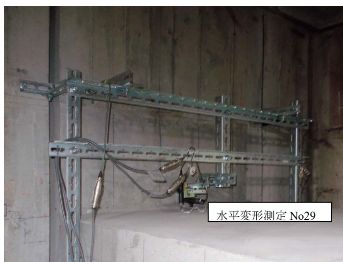
図 3.3.7-16 階段室側壁の測定用ビーム (アンクル) からの水平変形測定方法 (No.29)
