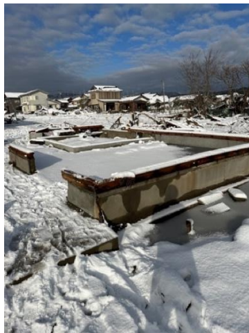
写真 5.7-13 建築物の流失
