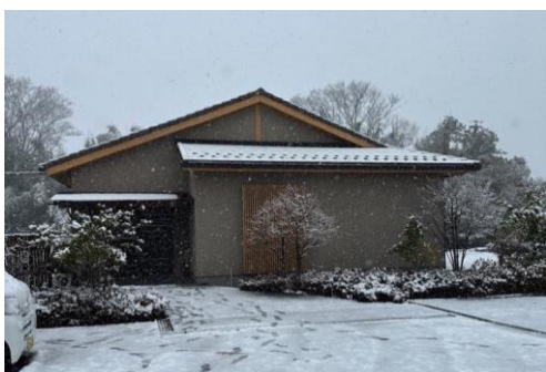
写真 5.7-37 ガイドライン工法による住宅 (F形瓦)
