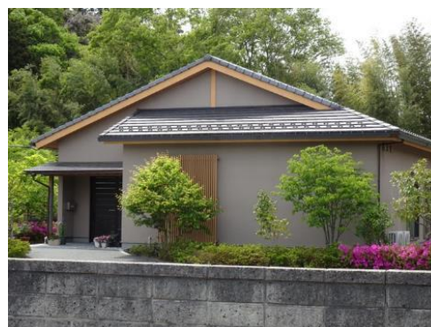
写真 5.7-38 令和5年5月の地震後の状況 5.7-8)
