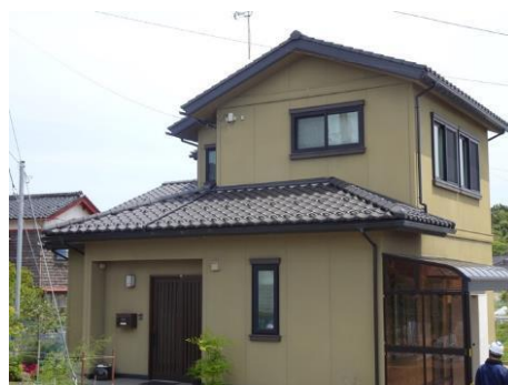
写真 5.7-36 令和5年5月の地震後の状況 5.7-8)
