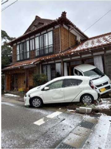
写真 5.7-24 津波による車の移動
