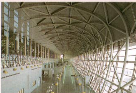
中川敦玲氏撮影(彰国社) 垂直な柱部分を除いて必要とされないが、安全をみてエアサイド4mの高さまで耐火ペイントが施された。
