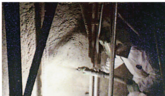
写真5 ポリマーセメントモルタルの吹付け施工の状況
