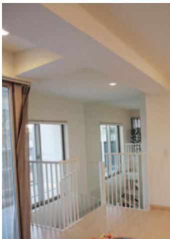
写真2 床の撤去によりメゾネット化した空間
