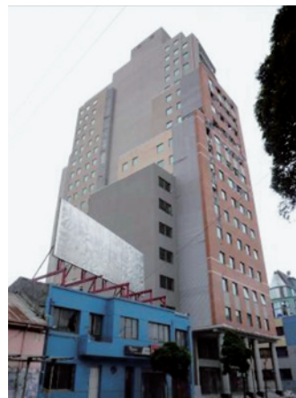
■写真6 層崩壊した12階付近
