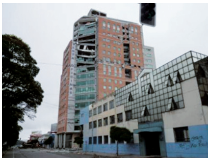
■写真5 中間層崩壊による被害
