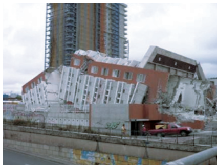
■写真3 転倒による被害
