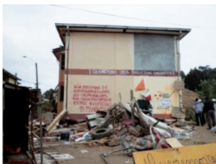
■写真7 1層部分で層崩壊した低層の組積造建築物
