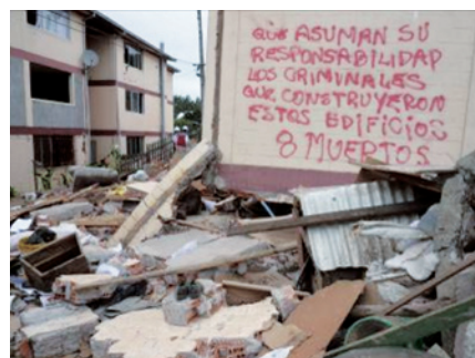
■写真7 1層部分で層崩壊した低層の組積造建築物
