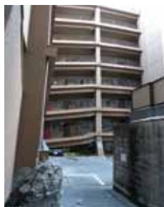
写真8 層崩壊した共同住宅(左)及び1階柱の圧壊状況
