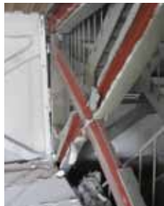
写真6 溝形鋼ブレースの座屈
