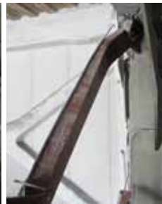
写真6 溝形鋼ブレースの座屈
