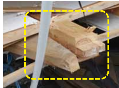
写真5 倒壊した木造アパート(左)及び柱頭接合部の拡大写真(金物なし、筋かい端部は釘打ちのみ)
