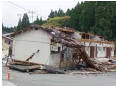
写真5 倒壊した木造アパート(左)及び柱頭接合部の拡大写真(金物なし、筋かい端部は釘打ちのみ)
