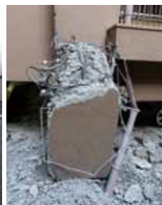
写真8 層崩壊した共同住宅(左)及び1階柱の圧壊状況
