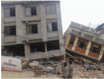
■写真3 ネパールのピロティ建築物の地震被害
